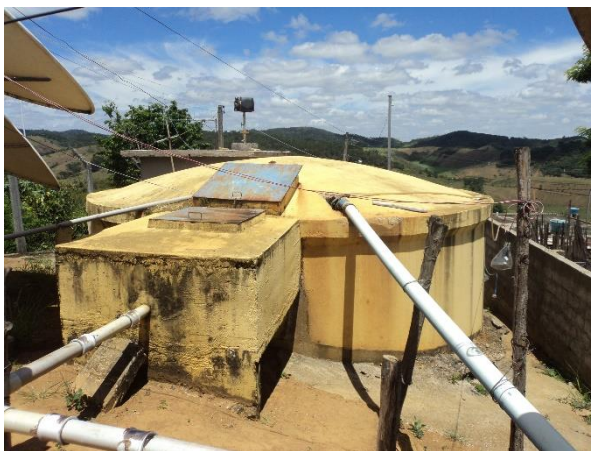
FIGURA 17 – RESERVATÓRIO R2 (FONTE: ACERVO DO AUTOR, 2014)
