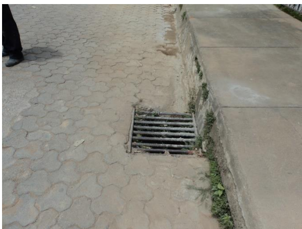
FIGURA 30 – BOCAS DE LOBO (FONTE: ACERVO DO AUTOR, 2014)
