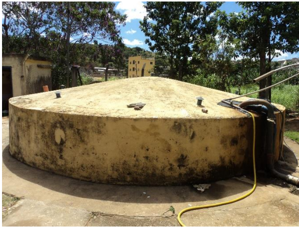
FIGURA 15 – RESERVATÓRIO R1 (FONTE: ACERVO DO AUTOR, 2014)
