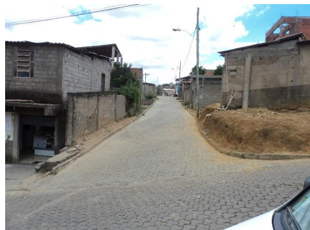
FIGURA 31 – RUA SEM REDE PLUVIAL (FONTE: ACERVO DO AUTOR, 2014)
