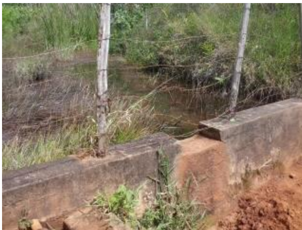
FIGURA 12 – CAPTAÇÃO (FONTE: ACERVO DO AUTOR, 2014)
