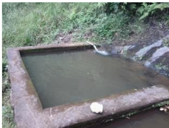
FIGURA 6 – CAIXA DE PASSAGEM (FONTE: ACERVO DO AUTOR, 2014)
