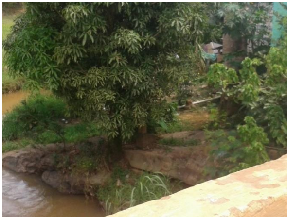
FIGURA 51 - LANÇAMENTO DE ESGOTO (FONTE: ACERVO DO AUTOR, 2014)
