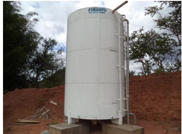
FIGURA 21 - RESERVATÓRIO R5 (FONTE: ACERVO DO AUTOR, 2014)
