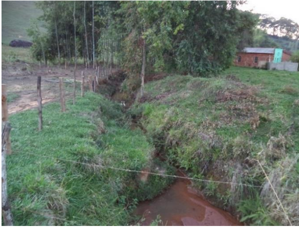
FIGURA 44 - LANÇAMENTO DE ESGOTO NO CÓRREGO SANTA EFIGÊNIA (FONTE: ACERVO DO AUTOR, 2014)
