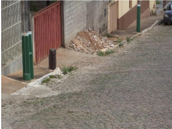
FIGURA 56 - RCC NA CALÇADA (FONTE: ACERVO DO AUTOR, 2014)
