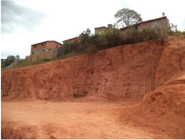
FIGURA 75 - OCUPAÇÃO EM ENCOSTAS (FONTE: ACERVO DO AUTOR, 2014)
