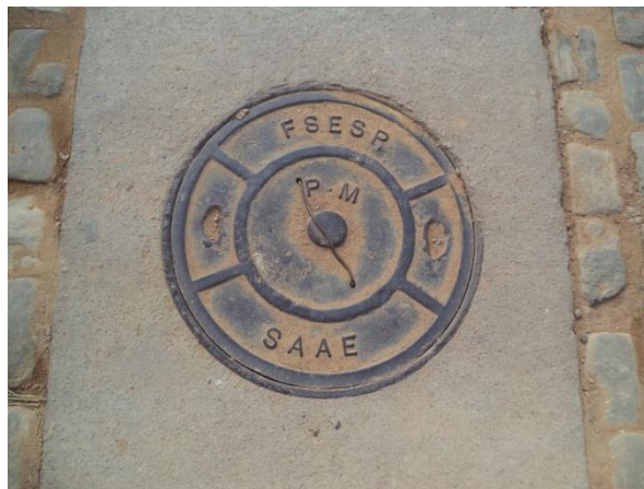
FIGURA 39 - POÇO DE VISITA (FONTE: ACERVO DO AUTOR, 2014)
