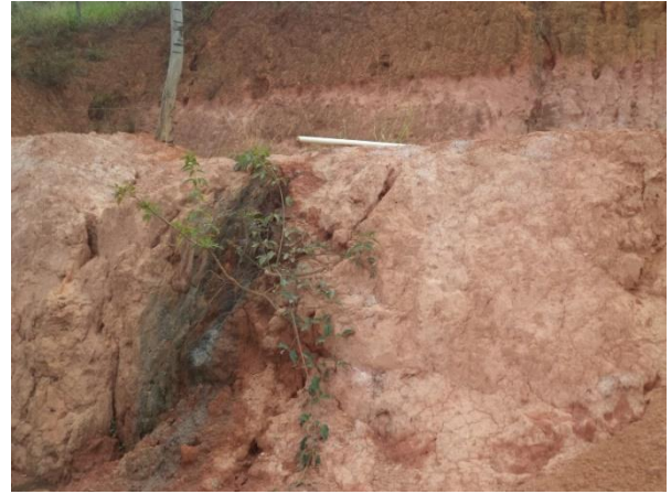
FIGURA 41 - ESGOTO A CÉU ABERTO NO BAIRRO VALE DO SOL (FONTE: ACERVO DO AUTOR, 2014)
