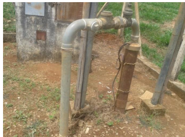
FIGURA 37 - POÇO DA LOCALIDADE DE CACHOEIRA DO LIVRAMENTO (VISTA 2) (FONTE: ACERVO DO AUTOR, 2014)
