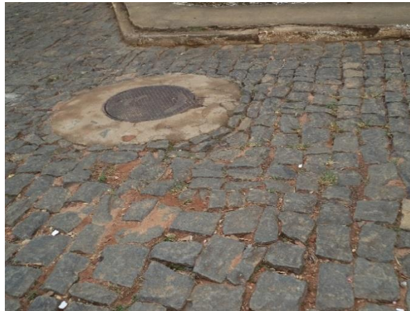
FIGURA 50 - POÇO DE VISITA (FONTE: ACERVO DO AUTOR, 2014)
