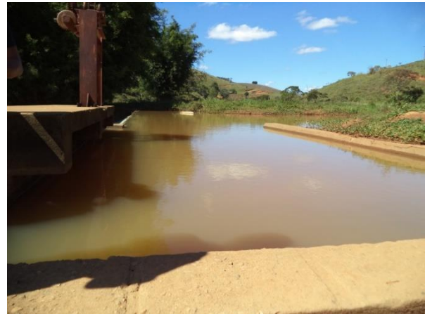
FIGURA 6 - CAPTAÇÃO (VISTA 2) (FONTE: ACERVO DO AUTOR, 2014)
