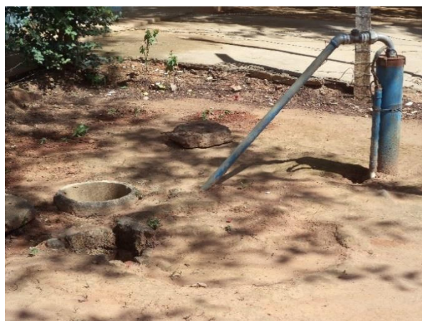
FIGURA 31 - POÇO DA LOCALIDADE DE BARROSO (VISTA 2) (FONTE: ACERVO DO AUTOR, 2014)
