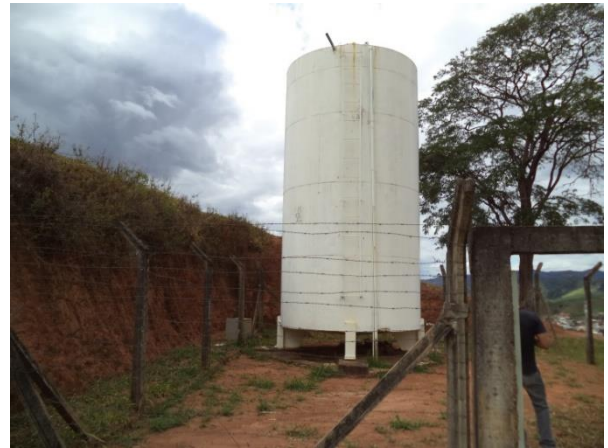
FIGURA 23 - RESERVATÓRIO R9 (FONTE: ACERVO DO AUTOR, 2014)
