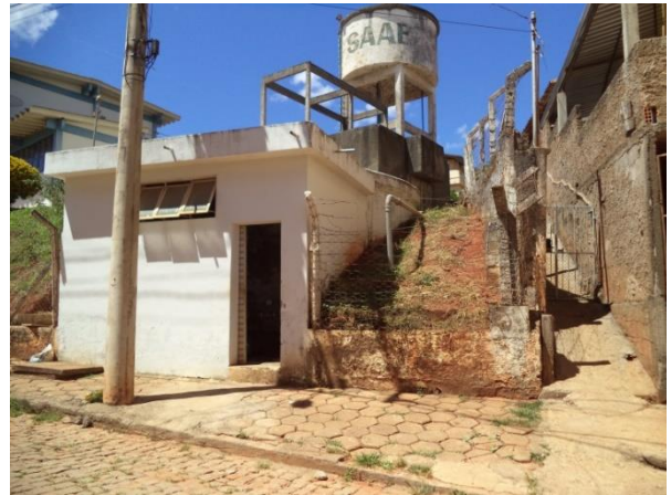
FIGURA 12 - EEAT (FONTE: ACERVO DO AUTOR, 2014)
