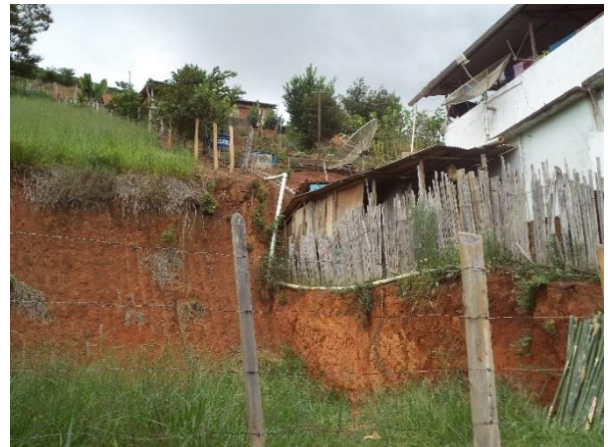
FIGURA 52 - TUBULAÇÃO DE ESGOTO EXPOSTA (FONTE: ACERVO DO AUTOR, 2014)
