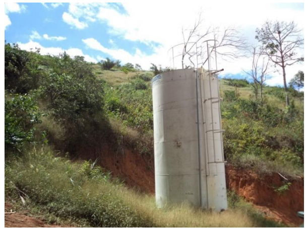
FIGURA 17 - RESERVATÓRIO R3 (FONTE: ACERVO DO AUTOR, 2014)
