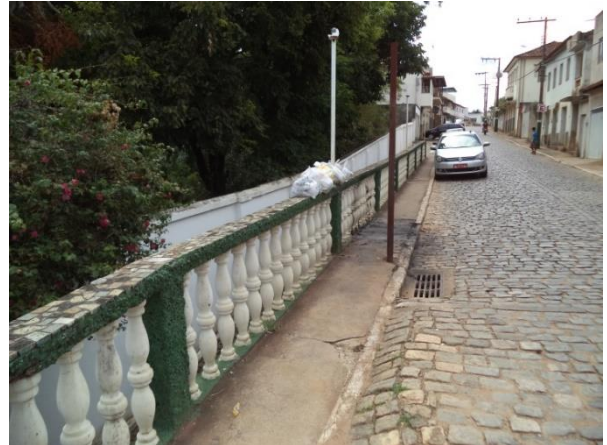
FIGURA 74 - DRENAGEM SUPERFICIAL (FONTE: ACERVO DO AUTOR, 2014)
