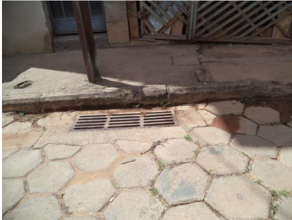
FIGURA 73 - GRADEAMENTO (FONTE: ACERVO DO AUTOR, 2014)
