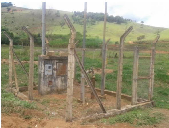
FIGURA 36 - POÇO DA LOCALIDADE DE CACHOEIRA DO LIVRAMENTO (VISTA 1) (FONTE: ACERVO DO AUTOR, 2014)
