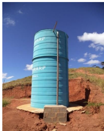
FIGURA 13 - RESERVATÓRIO R7 (FONTE: ACERVO DO AUTOR, 2014)
