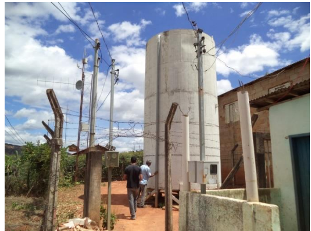
FIGURA 15 - RESERVATÓRIO R2 (FONTE: ACERVO DO AUTOR, 2014)
