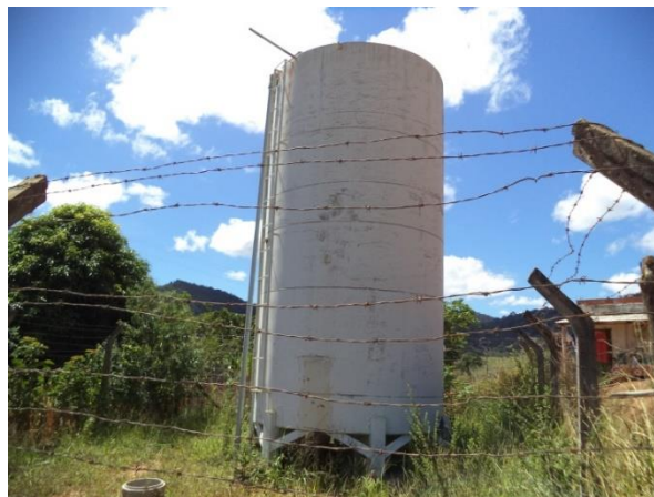
FIGURA 24 - RESERVATÓRIO R6 (FONTE: ACERVO DO AUTOR, 2014)
