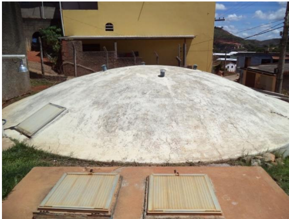
FIGURA 11 - RESERVATÓRIO R1 (FONTE: ACERVO DO AUTOR, 2014)
