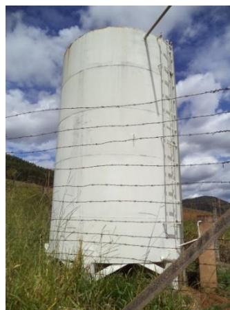
FIGURA 19 - RESERVATÓRIO R4 (FONTE: ACERVO DO AUTOR, 2014)
