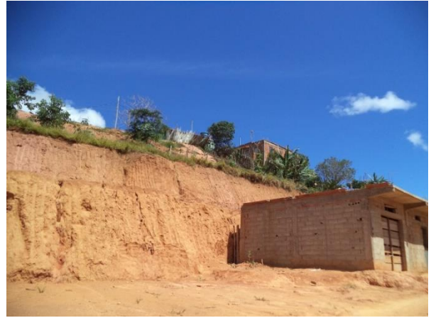
FIGURA 76 - OCUPAÇÃO EM ENCOSTAS (FONTE: ACERVO DO AUTOR, 2014)
