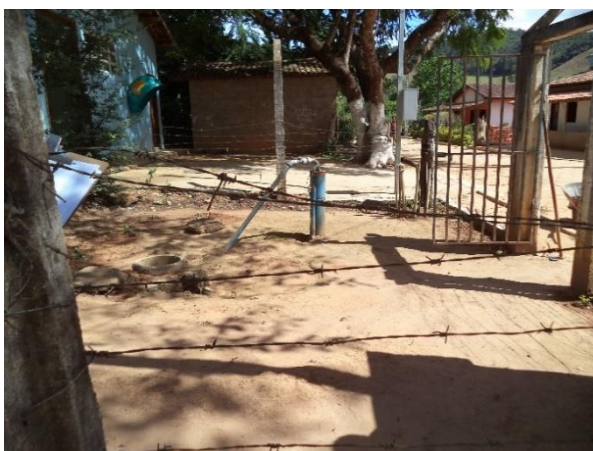
FIGURA 30 - POÇO DA LOCALIDADE DE BARROSO (VISTA 1) (FONTE: ACERVO DO AUTOR, 2014)
