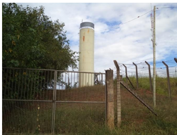
FIGURA 26 - RESERVATÓRIO R9 (FONTE: ACERVO DO AUTOR, 2014)
