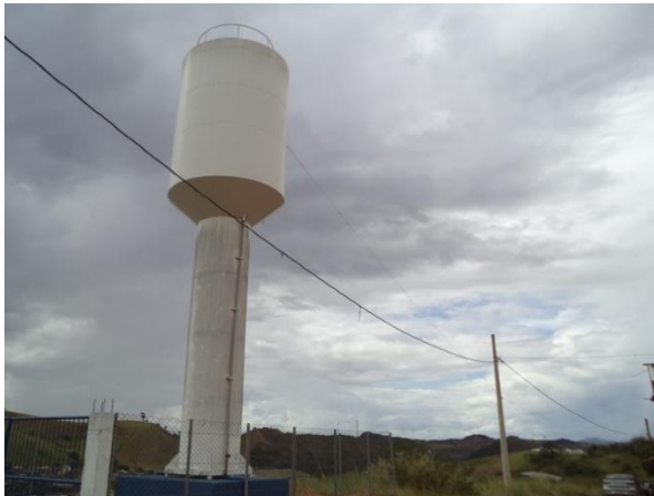
FIGURA 24 - RESERVATÓRIO R7 (FONTE: ACERVO DO AUTOR, 2014)
