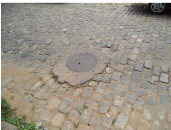
FIGURA 60 - REDE COLETORA (VISTA 1) (FONTE: ACERVO DO AUTOR, 2014)
