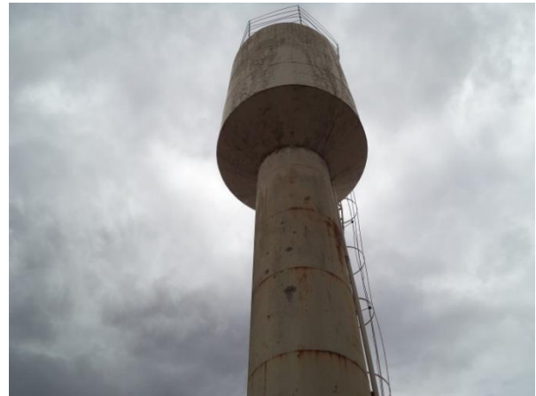
FIGURA 23 - RESERVATÓRIO R6 (FONTE: ACERVO DO AUTOR, 2014)
