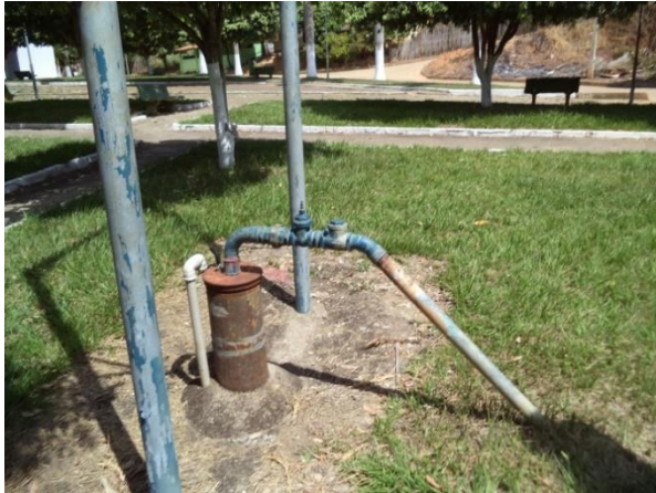
FIGURA 45 - CAPTAÇÃO SÃO VICENTE DA ESTRELA (VISTA 1) (FONTE: ACERVO DO AUTOR, 2014)
