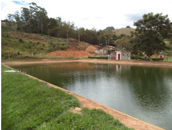
FIGURA 72 - ETE DISTRITO DE BICUÍBA (VISTA 5) (FONTE: ACERVO DO AUTOR, 2014)
