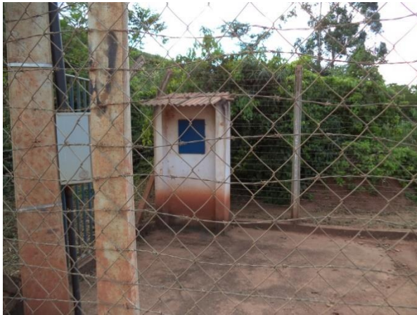
FIGURA 38 - CAPTAÇÃO SANTANA DO TABULEIRO (VISTA 1) (FONTE: ACERVO DO AUTOR, 2014)
