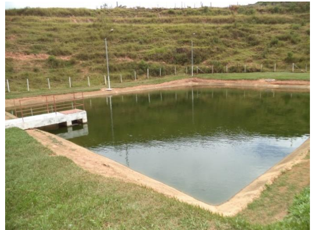
FIGURA 73 - ETE DISTRITO DE BICUÍBA (VISTA 6) (FONTE: ACERVO DO AUTOR, 2014)
