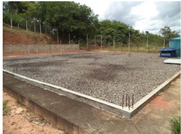
FIGURA 19 - RESERVATÓRIO R2 (FONTE: ACERVO DO AUTOR, 2014)
