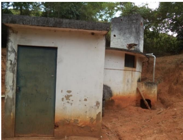
FIGURA 52 - SISTEMA DE TRATAMENTO E RESERVAÇÃO VERMELHO VELHO (VISTA 1) (FONTE: ACERVO DO AUTOR, 2014)
