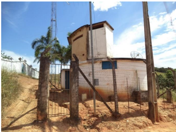
FIGURA 47 - SISTEMA DE TRATAMENTO E RESERVAÇÃO SÃO VICENTE DA ESTRELA (VISTA 1) (FONTE: ACERVO DO AUTOR, 2014)
