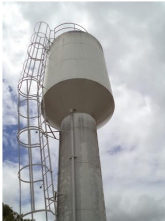
FIGURA 20 - RESERVATÓRIO R3 (FONTE: ACERVO DO AUTOR, 2014)
