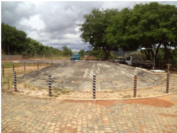
FIGURA 18 - RESERVATÓRIO R1 (FONTE: ACERVO DO AUTOR, 2014)
