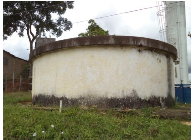
FIGURA 21 - RESERVATÓRIO R4 (FONTE: ACERVO DO AUTOR, 2014)
