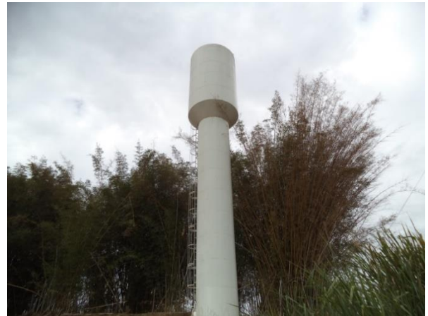
FIGURA 25 - RESERVATÓRIO R8 (FONTE: ACERVO DO AUTOR, 2014)
