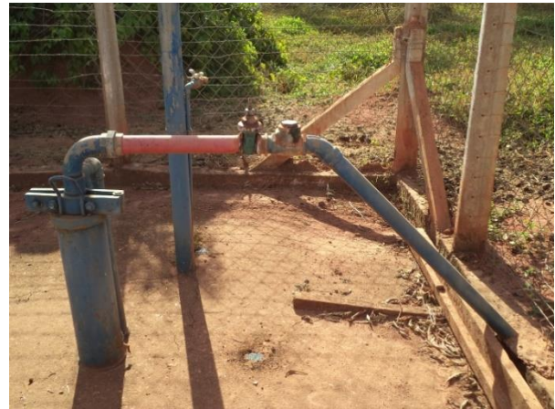
FIGURA 39 - CAPTAÇÃO SANTANA DO TABULEIRO (VISTA 2) (FONTE: ACERVO DO AUTOR, 2014)
