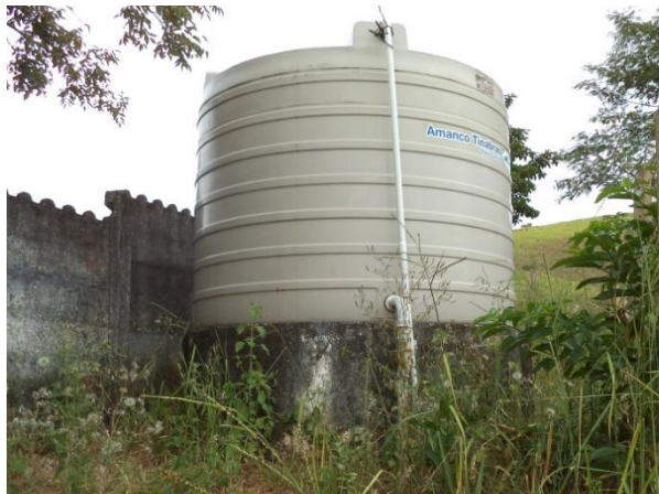
FIGURA 54 - RESERVATÓRIO R2 VERMELHO VELHO (FONTE: ACERVO DO AUTOR, 2014)
