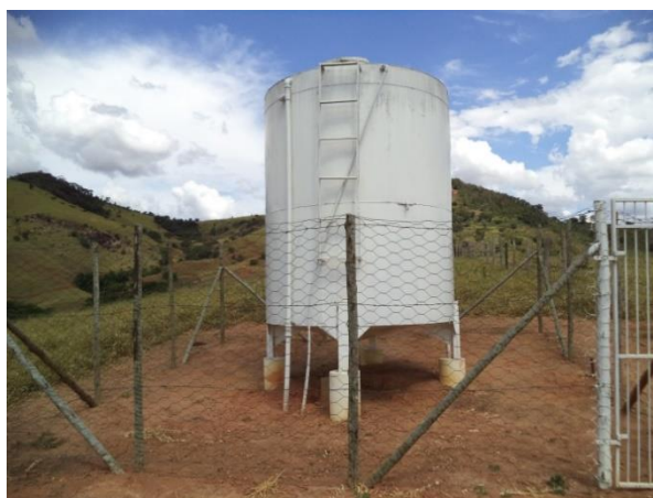
FIGURA 49 - RESERVATÓRIO R2 SÃO VICENTE DA ESTRELA (FONTE: ACERVO DO AUTOR, 2014)
