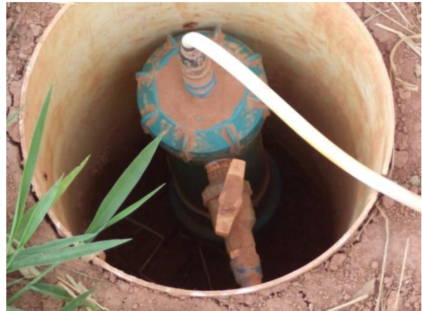
FIGURA 37 - SISTEMA DE TRATAMENTO E RESERVAÇÃO BICUÍBA (VISTA 2) (FONTE: ACERVO DO AUTOR, 2014)
