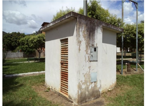
FIGURA 46 - CAPTAÇÃO SÃO VICENTE DA ESTRELA (VISTA 2) (FONTE: ACERVO DO AUTOR, 2014)
