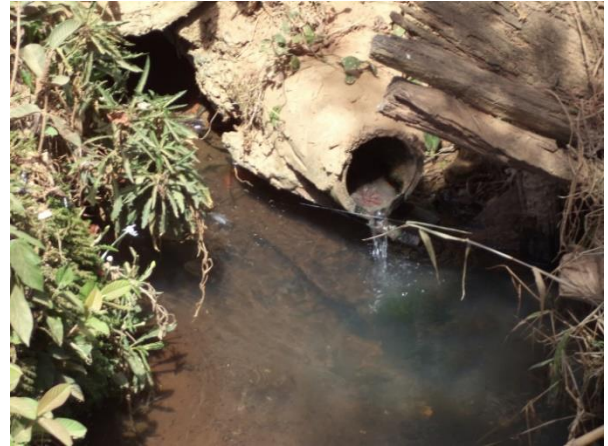
FIGURA 76 - PONTO DE DESPEJO DE ESGOTO - CÓRREGO SÃO VICENTE - DISTRITO DE SÃO VICENTE DA ESTRELA (vista 2) (FONTE: ACERVO DO AUTOR, 2014)
