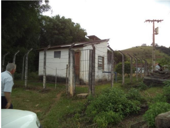
FIGURA 34 - CAPTAÇÃO BICUÍBA (VISTA 1) (FONTE: ACERVO DO AUTOR, 2014)
