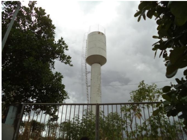
FIGURA 22 - RESERVATÓRIO R5 (FONTE: ACERVO DO AUTOR, 2014)
