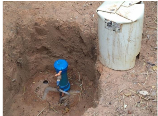
FIGURA 59 - SISTEMA DE FILTRAÇÃO CORNÉLIO ALVES (FONTE: ACERVO DO AUTOR, 2014)
