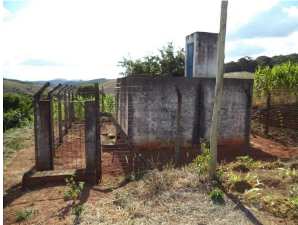
FIGURA 40 - SISTEMA DE TRATAMENTO E RESERVAÇÃO DE SANTANA DO TABULEIRO (FONTE: ACERVO DO AUTOR, 2014)
