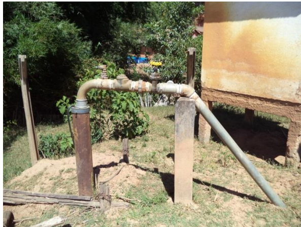
FIGURA 20 - POÇO ÁGUAS FÉRREAS (FONTE: ACERVO DO AUTOR, 2014)
