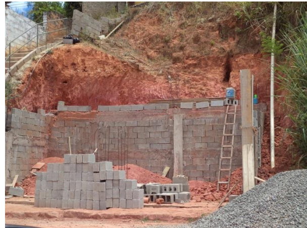
FIGURA 52 - OCUPAÇÕES IRREGULARES (VISTA 2) (FONTE: ACERVO DO AUTOR, 2014)
