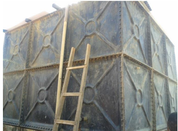
FIGURA 26 - RESERVATÓRIO R2 ÁGUAS FÉRREAS (VISTA 2)
