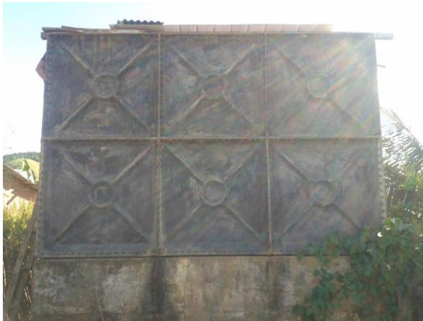
FIGURA 25 - RESERVATÓRIO R2 ÁGUAS FÉRREAS (VISTA 1)
