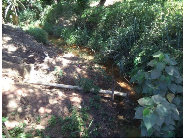
FIGURA 31 - LANÇAMENTO DE ESGOTO ÁGUAS FÉRREAS (FONTE: ACERVO DO AUTOR, 2014)
