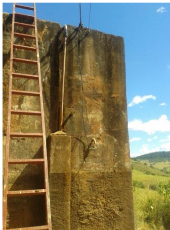
FIGURA 24 - RESERVATÓRIO R1 ÁGUAS FÉRREAS (FONTE: ACERVO DO AUTOR, 2014)
