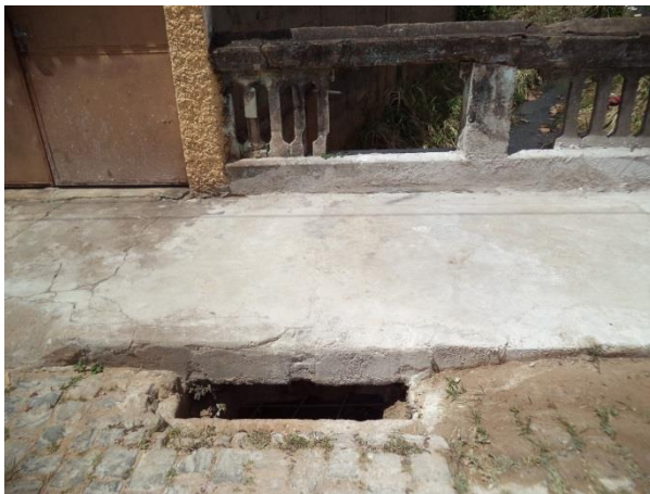
FIGURA 49 - DISPOSITIVOS DE MICRODRENAGEM (VISTA 1) (FONTE: ACERVO DO AUTOR, 2014)
