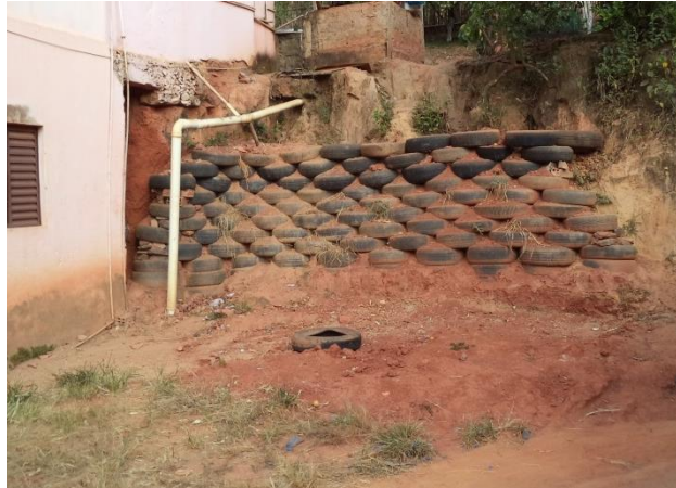
FIGURA 43 - UTILIZAÇÃO DE PNEUS NA CONTENÇÃO DE BARREIRAS (FONTE: ACERVO DO AUTOR, 2014)
