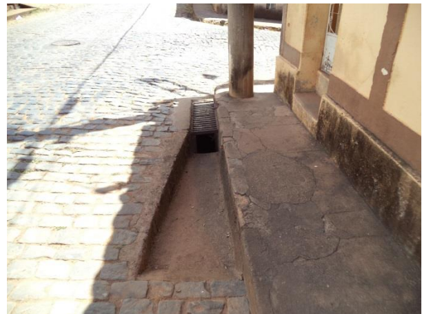
FIGURA 50 - DISPOSITIVOS DE MICRODRENAGEM (VISTA 2) (FONTE: ACERVO DO AUTOR, 2014)
