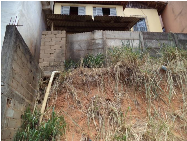
FIGURA 51 - OCUPAÇÕES IRREGULARES (VISTA 1) (FONTE: ACERVO DO AUTOR, 2014)
