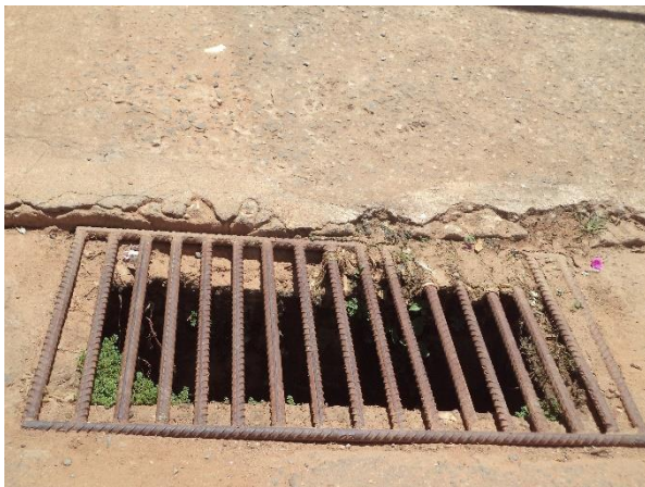
FIGURA 27 – BOCA DE LOBO (FONTE: ACERVO DO AUTOR, 2014)
