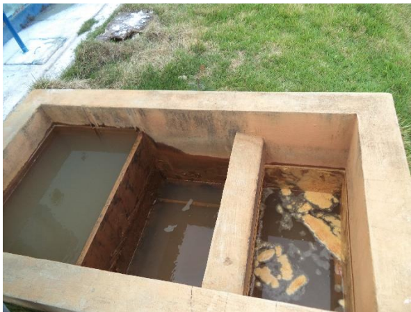
FIGURA 10 - FLOCULADOR (FONTE: ACERVO DO AUTOR, 2014)
