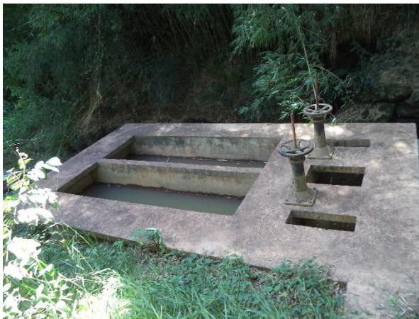
FIGURA 6 - CAPTAÇÃO (FONTE: ACERVO DO AUTOR, 2014)
