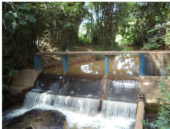
FIGURA 5 - CAPTAÇÃO (FONTE: ACERVO DO AUTOR, 2014)
