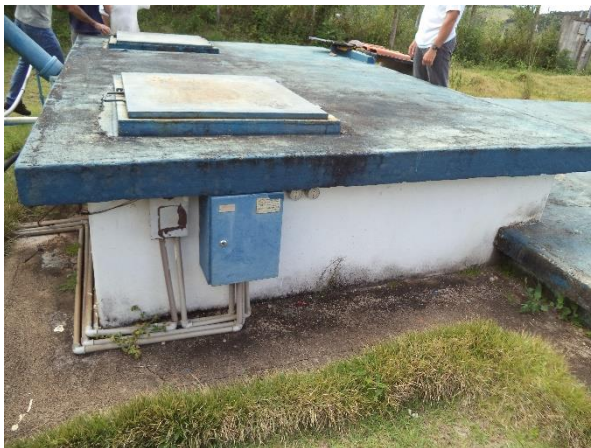
FIGURA 12 - CAIXA DE CONTATO (FONTE: ACERVO DO AUTOR, 2014)
