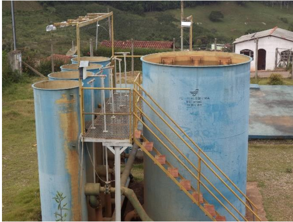
FIGURA 8 - ETA DO TIPO COMPACTA (FONTE: ACERVO DO AUTOR, 2014)
