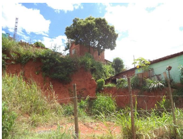
FIGURA 29 - ÁREA DE RISCO (FONTE: ACERVO DO AUTOR, 2014)
