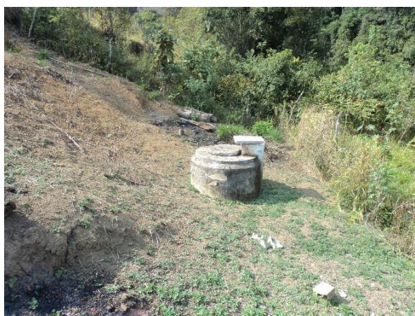
FIGURA 24 – POÇO TIPO CISTERNA (FONTE: ACERVO DO AUTOR, 2014)
