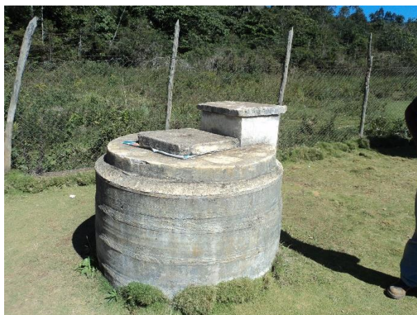
FIGURA 26 – POÇO TIPO CISTERNA LOCALIZADO NA ESCOLA (FONTE: ACERVO DO AUTOR, 2014)
