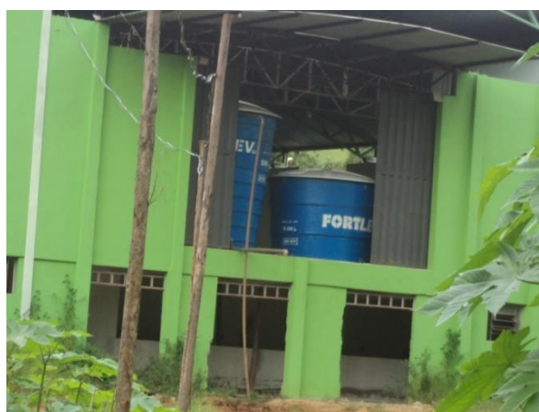
FIGURA 19 – RESERVATÓRIO R4 E R5 (FONTE: ACERVO DO AUTOR, 2014)
