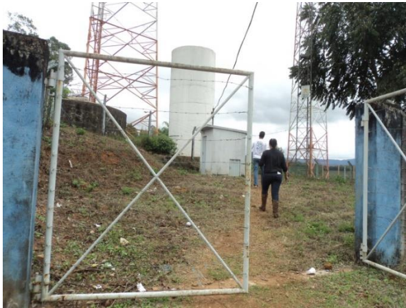
FIGURA 13 – RESERVATÓRIO R1 (FONTE: ACERVO DO AUTOR, 2014)
