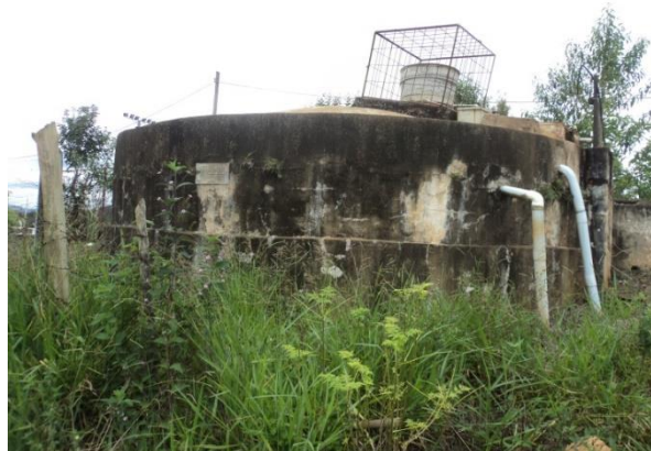
FIGURA 20 – RESERVATÓRIO R6 - DESATIVADO (FONTE: ACERVO DO AUTOR, 2014)
