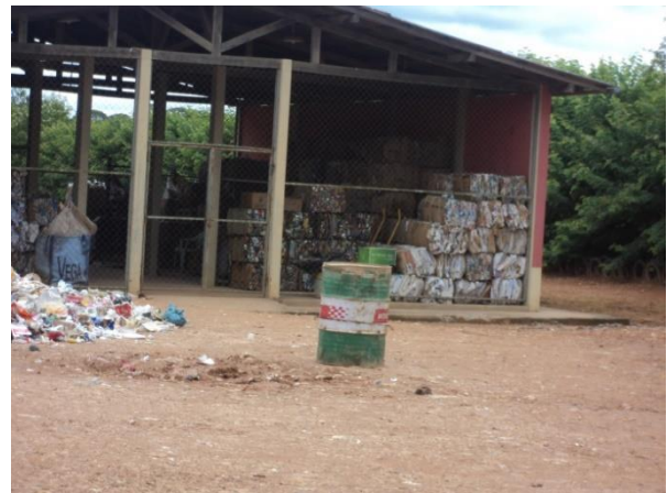
FIGURA 39 – UTC - GALPÃO (FONTE: ACERVO DO AUTOR, 2014)
