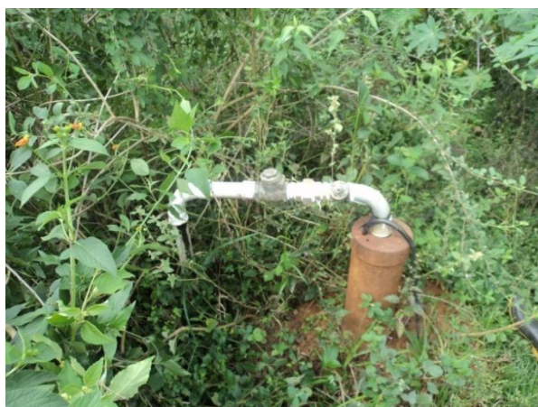
FIGURA 21 – POÇO 1 (FONTE: ACERVO DO AUTOR, 2014)
