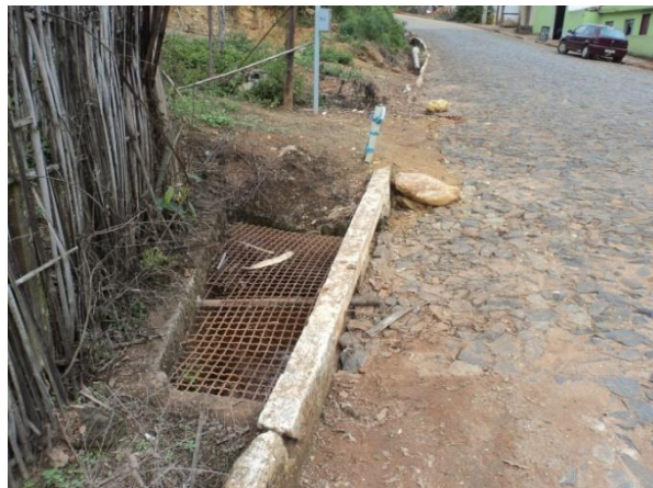
FIGURA 42 – BOCA DE LOBO NO PASSEIO (FONTE: ACERVO DO AUTOR, 2014)
