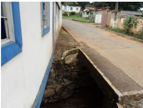
FIGURA 43 – DRENAGEM SUPERFICIAL (FONTE: ACERVO DO AUTOR, 2014)
