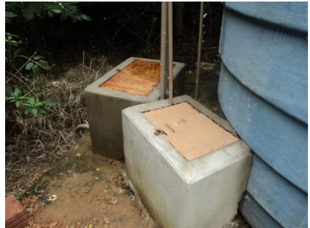
FIGURA 18 – ADUTORAS DE ÁGUA TRATADA E TRATAMENTO (FONTE: ACERVO DO AUTOR, 2014)
