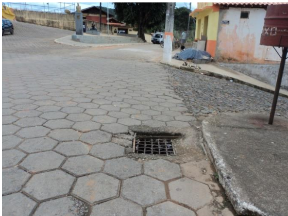
FIGURA 41 – BOCA DE LOBO NA RUA (FONTE: ACERVO DO AUTOR, 2014)
