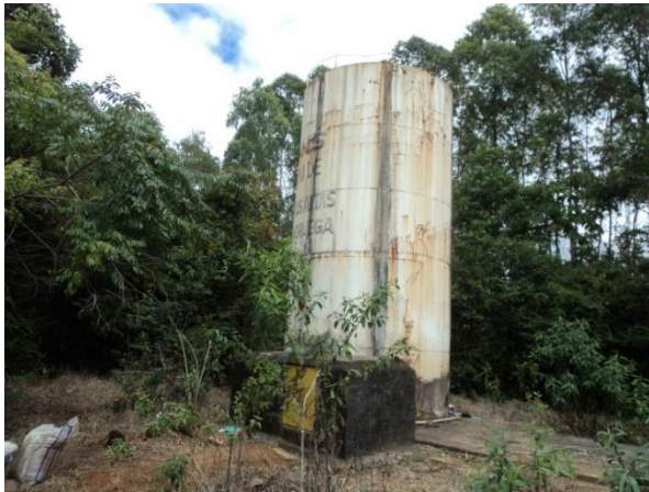
FIGURA 15 – RESERVATÓRIO R2 (FONTE: ACERVO DO AUTOR, 2014)
