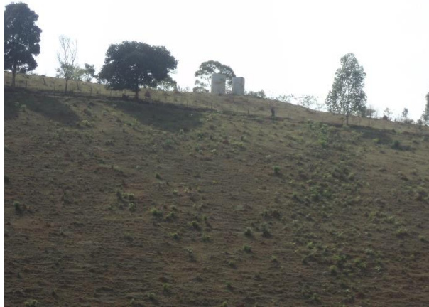
FIGURA 30 – RESERVATÓRIOS R1 E R2 (FONTE: ACERVO DO AUTOR, 2014)
