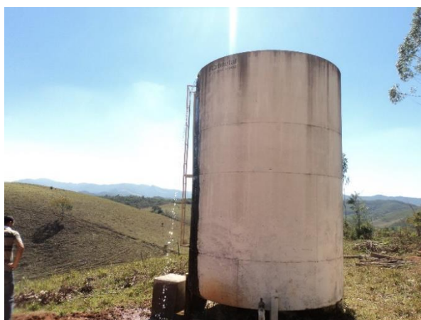
FIGURA 23 – RESERVATÓRIO (FONTE: ACERVO DO AUTOR, 2014)
