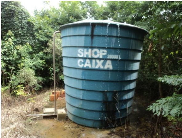
FIGURA 17 – RESERVATÓRIO R3 (FONTE: ACERVO DO AUTOR, 2014)
