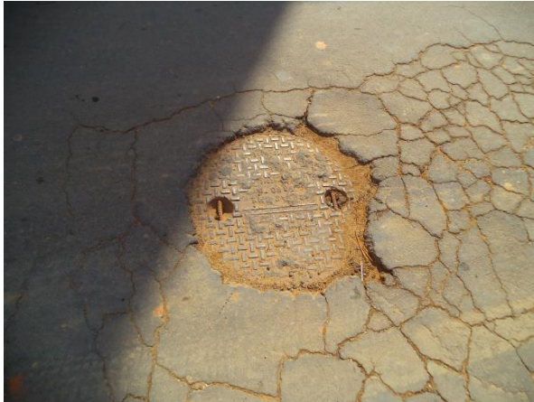
FIGURA 23 - POÇO DE VISITA 1 (FONTE: ACERVO DO AUTOR, 2014)
