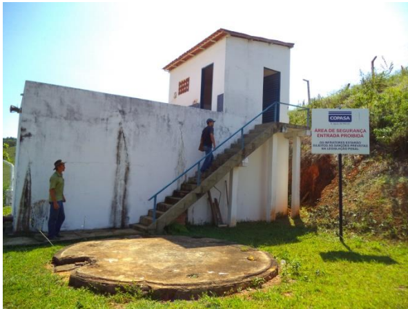
FIGURA 11 - RESERVATÓRIO R1 (FONTE: ACERVO DO AUTOR, 2014)
