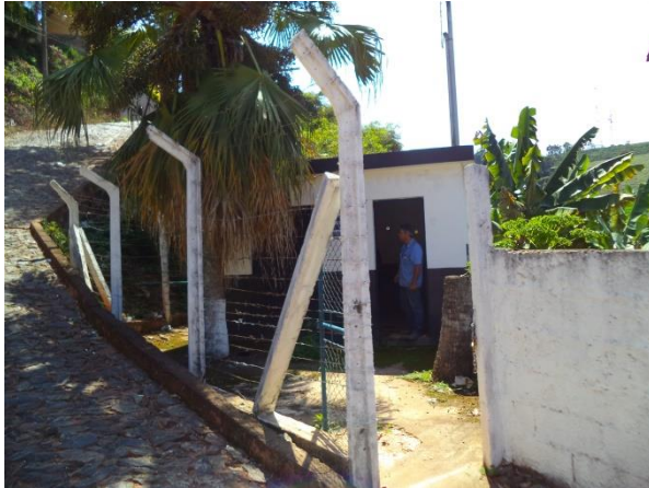
FIGURA 19 - ENTRADA DO BOOSTER ITAMAR (FONTE: ACERVO DO AUTOR, 2014)
