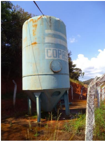
FIGURA 17 - RESERVATÓRIO NOVO HORIZONTE (VISTA 1) (FONTE: ACERVO DO AUTOR, 2014)
