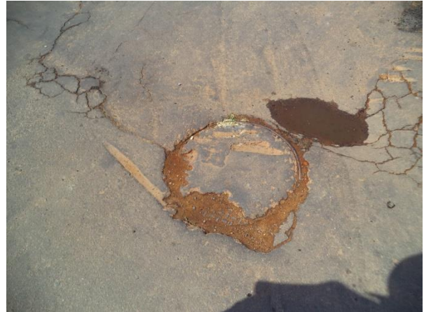
FIGURA 24 - POÇO DE VISITA 2 (FONTE: ACERVO DO AUTOR, 2014)
