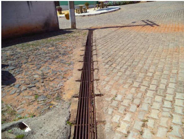
FIGURA 40 - BOCA DE LOBO NA RUA (FONTE: ACERVO DO AUTOR, 2014)
