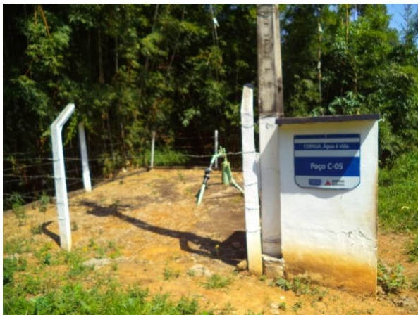
FIGURA 5 - CAPTAÇÃO POÇO C-05 (VISTA 1) (FONTE: ACERVO DO AUTOR, 2014)
