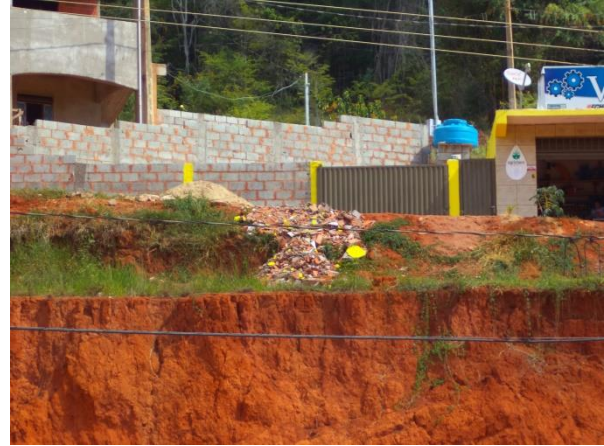
FIGURA 31 - RCC DEPOSITADO EM TERRO VAZIO 2 (FONTE: ACERVO DO AUTOR, 2014)
