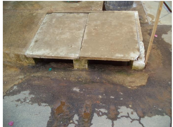
FIGURA 41 - BOCAS DE LOBO (FONTE: ACERVO DO AUTOR, 2014)
