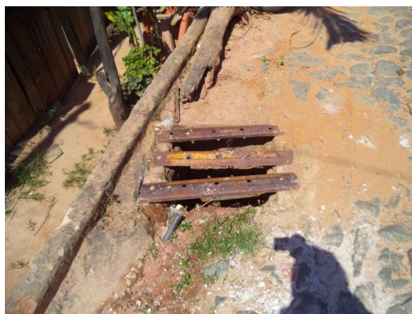
FIGURA 42 - BOCA DE LOBO (FONTE: ACERVO DO AUTOR, 2014)
