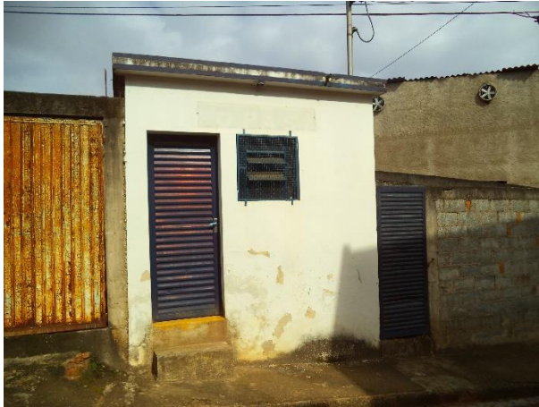
FIGURA 18 - CASA DO BOOSTER 1 (FONTE: ACERVO DO AUTOR, 2014)
