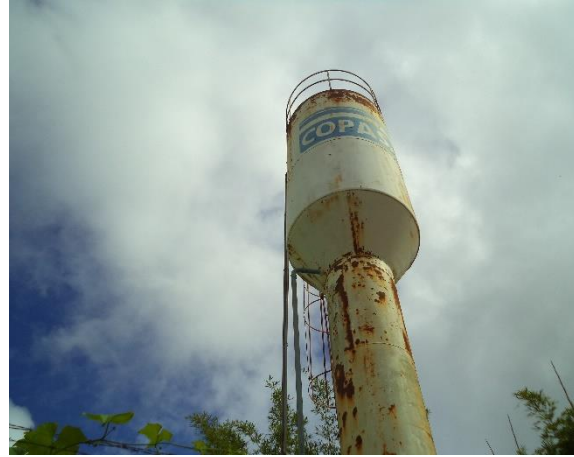
FIGURA 29 - RESERVATÓRIO-R5 (VISTA 2) (FONTE: ACERVO DO AUTOR, 2014)
