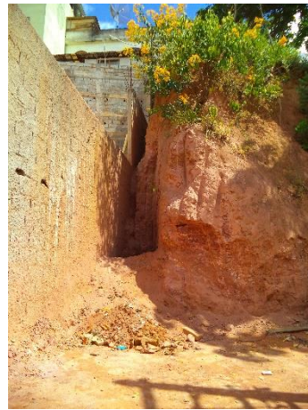
FIGURA 53 - TALUDE PRÓXIMO A RESIDÊNCIAS (FONTE: ACERVO DO AUTOR, 2014)
