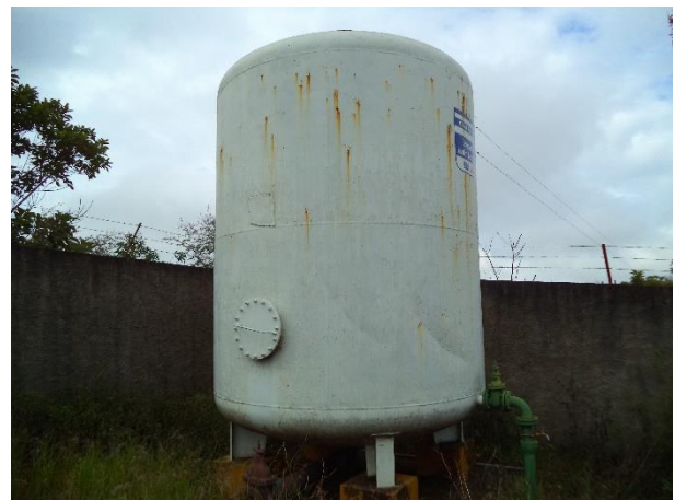
FIGURA 21 - RESERVATÓRIO-R2 (VISTA 2) (FONTE: ACERVO DO AUTOR, 2014)
