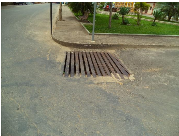
FIGURA 50 - BOCA DE LOBO (FONTE: ACERVO DO AUTOR, 2014)
