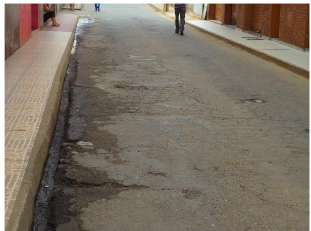
FIGURA 51 - DRENAGEM SUPERFICIAL (FONTE: ACERVO DO AUTOR, 2014)
