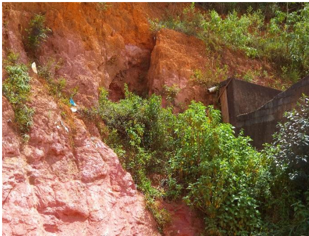
FIGURA 52 - ÁREA DE RISCO DE DESMORONAMENTO (FONTE: ACERVO DO AUTOR, 2014)
