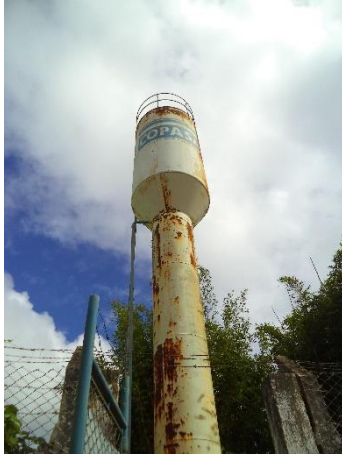
FIGURA 28 - RESERVATÓRIO-R5 (VISTA 1) (FONTE: ACERVO DO AUTOR, 2014)
