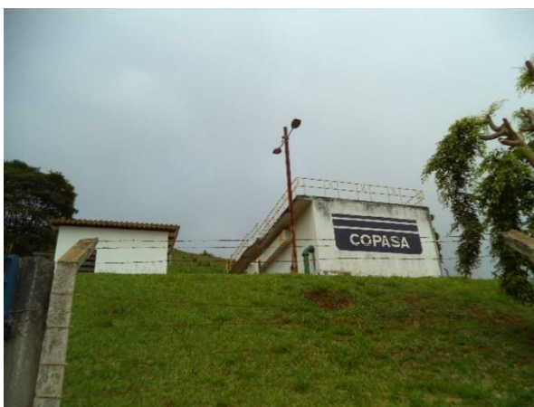
FIGURA 14 - EEAT 1 e ETA (FONTE: ACERVO DO AUTOR, 2014)
