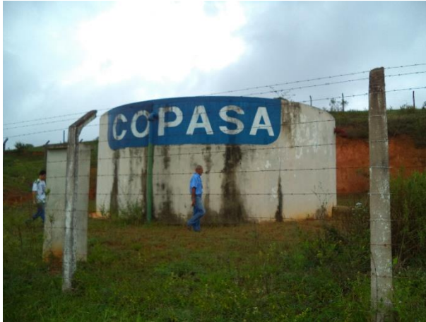
FIGURA 16 - RESERVATÓRIO R1 (VISTA 1) (FONTE: ACERVO DO AUTOR, 2014)
