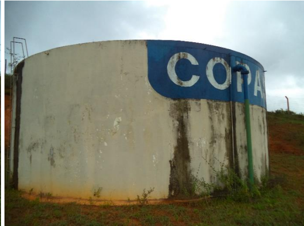
FIGURA 17 - RESERVATÓRIO R1 (VISTA 2) (FONTE: ACERVO DO AUTOR, 2014)
