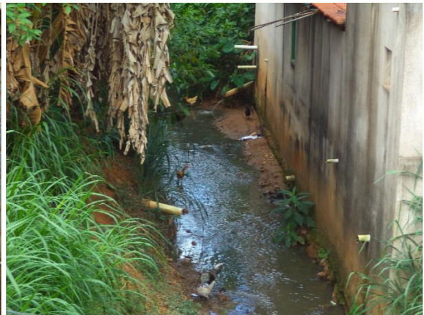
FIGURA 33 - LANÇAMENTO DIRETO DE EFLUENTES (FONTE: ACERVO DO AUTOR, 2014)
