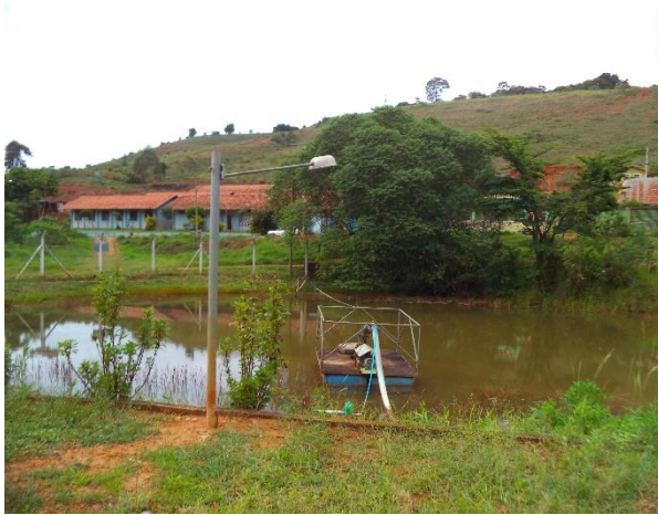
FIGURA 5 – Balsa flutuante (Vista 1) (Fonte: Acervo do Autor, 2014)
