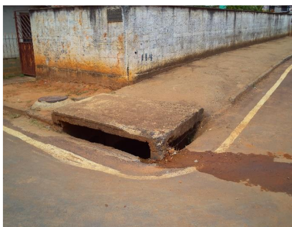
FIGURA 29 – BOCA DE LOBO (FONTE: ACERVO DO AUTOR, 2014)
