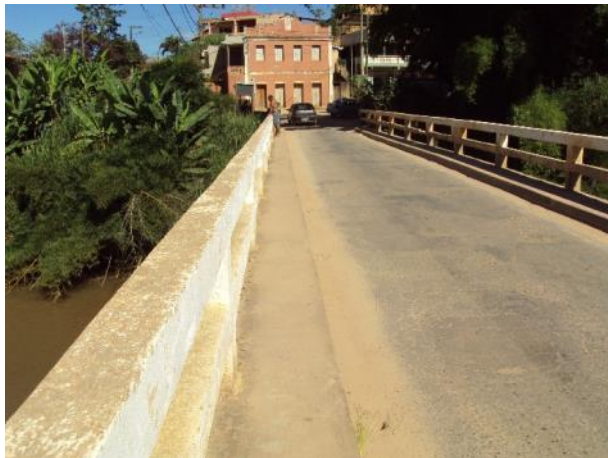
Foto 8.1 – Ponte sobre o Rio Xopotó na Rua Hortêncio Vilela
