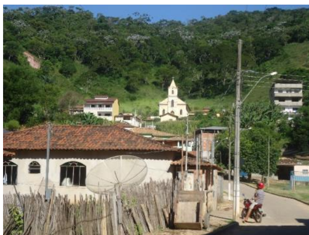
Foto 8.5 – Casas na Rua Firmino Fidélis – área de inundação
