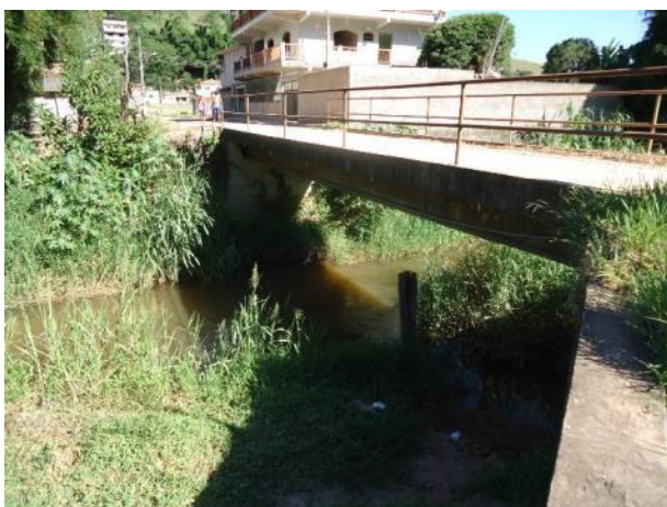
Foto 8.3 – Ponte sobre o Ribeirão Santo Antônio na Rua Firmino Fidélis
