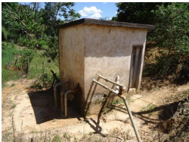
Foto 5.3 – Captação Córrego Água Quente – EEAB
