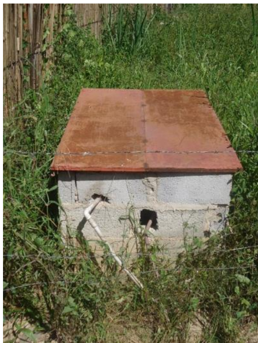
Foto 5.7 – Caixa do Poço P3
