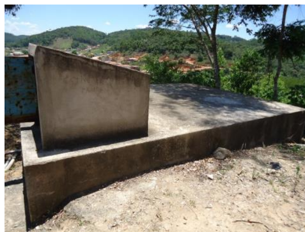
Foto 5.18 – Reservatório R2 (ETA)
