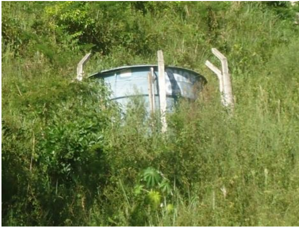
Foto 5.25 – Reservatório 1 (Capt. Poço)
