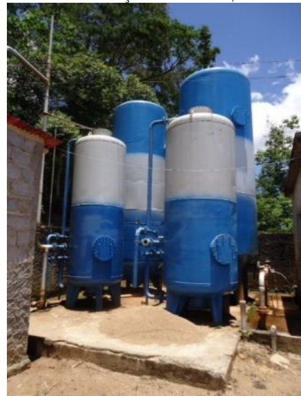
Foto 5.15 – 2 Decantadores (tanques maiores) e 2 Filtros (tanques menores) Fonte: Elaboração ENGECORPS, 2014.
