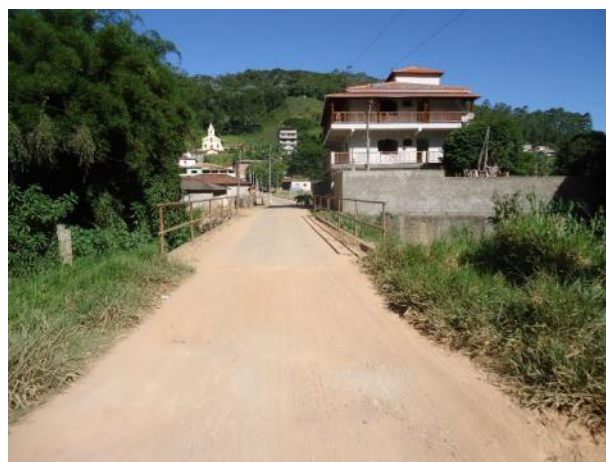
Foto 8.4 – Ponte na Rua Firmino Fidélis
