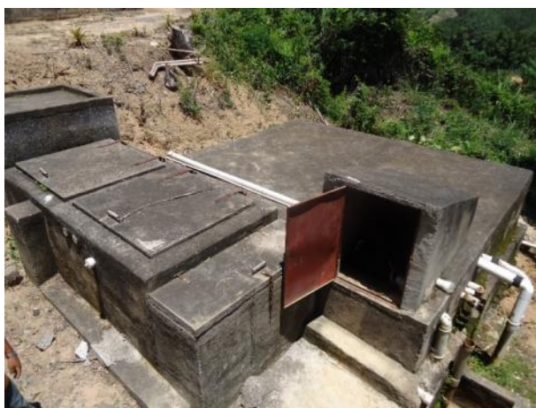
Foto 5.17 – Reservatório R1 (ETA)
