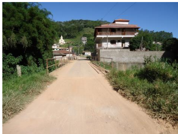
Foto 5.41 – Ponte na Rua Firmino Fidélis
