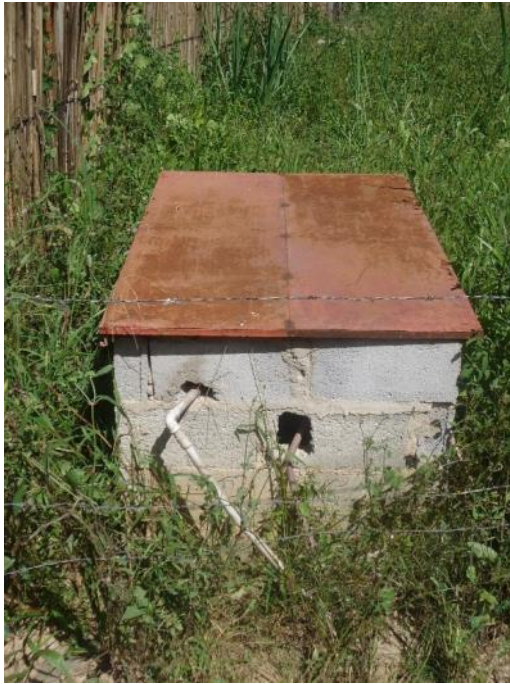
Foto 5.7 – Caixa do Poço P3 Fonte: Elaboração ENGEORPS, 2014.
