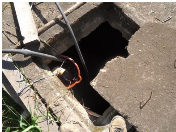
Foto 5.26 – Reservatório 2 (Capt. Nasc. Faísca)
