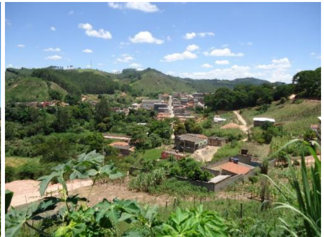
Foto 5.46 – Residências abaixo do Loteamento Bela Vista
