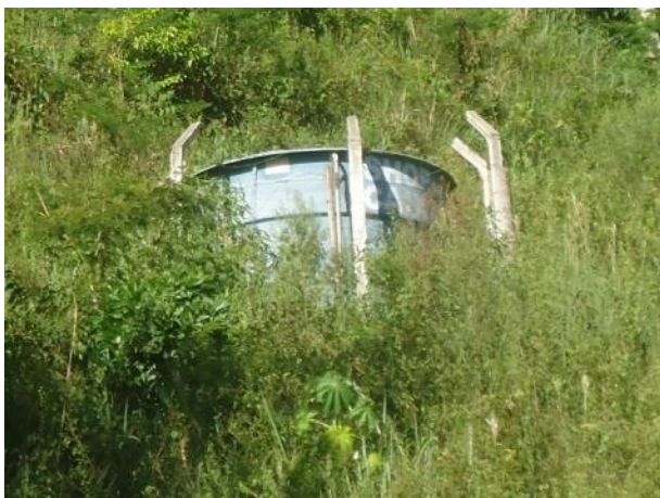
Foto 5.25 – Reservatório 1 (Capt. Poço)
