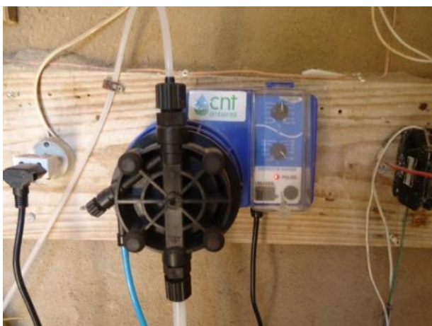
Foto 5.14 – Controle de Dosagem da Desinfecção Fonte: Elaboração ENGECORPS, 2014.
