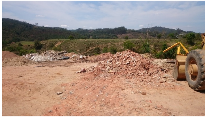
Figura 3.11 – Área do antigo lixão onde hoje é depositado RCC
