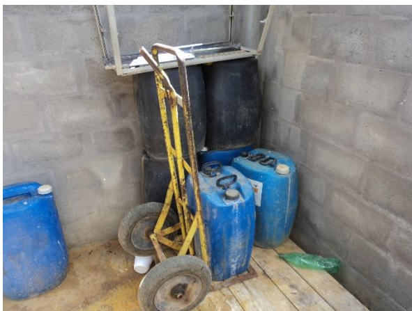
FIGURA 27 – ARMAZENAMENTO DE PRODUTOS QUÍMICOS (VISTA 1) (FONTE: VALLENGE, 2014)
