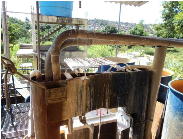
FIGURA 22 – ETA CONVENCIONAL (VISTA 1) (FONTE: VALLENGE, 2014)
