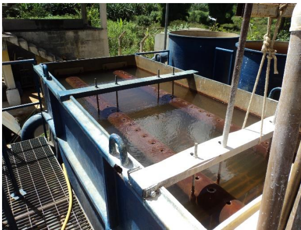
FIGURA 24 – ETA CONVENCIONAL (VISTA 3) (FONTE: VALLENGE, 2014)
