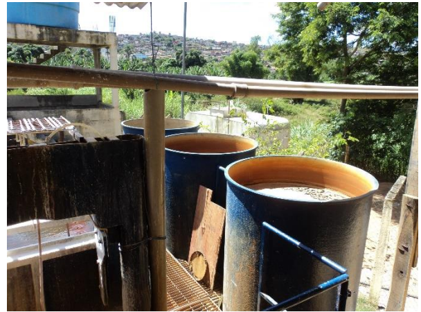
FIGURA 23 – ETA CONVENCIONAL (VISTA 2) (FONTE: VALLENGE, 2014)
