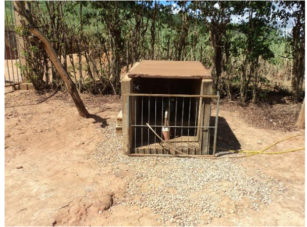
FIGURA 42 – POÇO SEMI-ARTESIANO (FONTE: VALLENGE, 2014)
