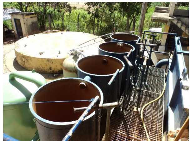
FIGURA 25 – ETA CONVENCIONAL (VISTA 4) (FONTE: VALLENGE, 2014)
