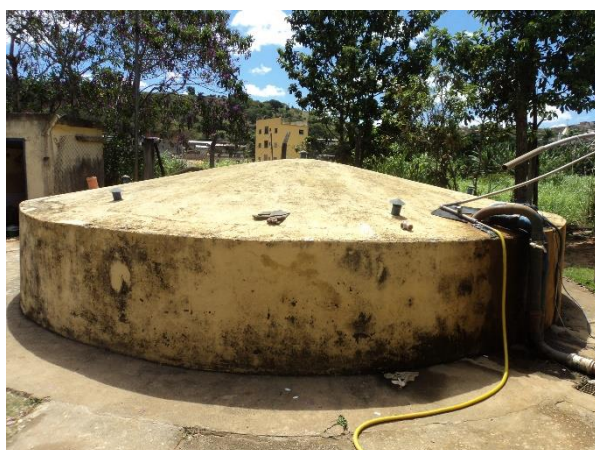
FIGURA 29 – RESERVATÓRIO R1 (FONTE: VALLENGE, 2014)
