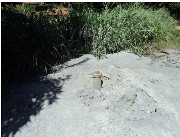
FIGURA 20 – POÇO DE CAPTAÇÃO 3 (FONTE: VALLENGE, 2014)
