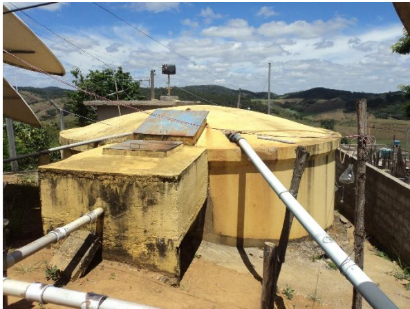
FIGURA 31 – RESERVATÓRIO R2 (FONTE: VALLENGE, 2014)
