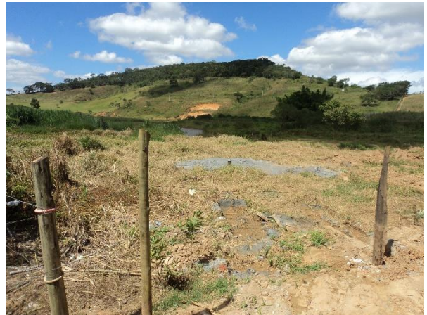
FIGURA 19 – POÇO DE CAPTAÇÃO 2 (FONTE: VALLENGE, 2014)
