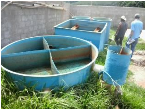
FIGURA 30 – ETA DESATIVADA (FONTE: VALLENGE, 2014)
