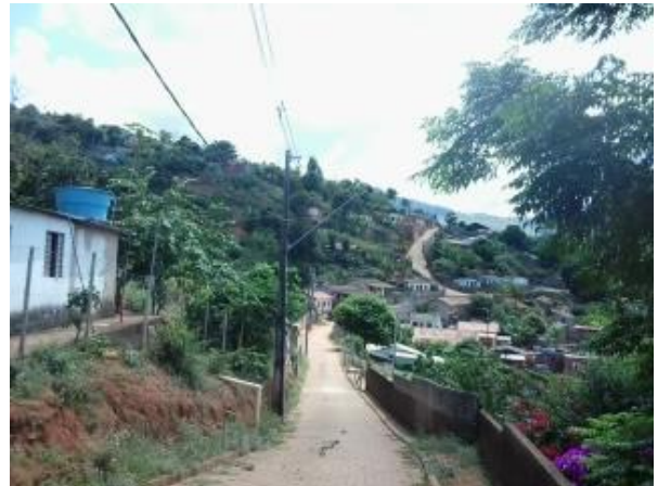
FIGURA 42 – RUA SEM REDE PLUVIAL (FONTE: VALLENGE, 2014)
