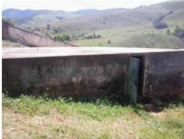
FIGURA 27 – RESERVATÓRIO R3 (FONTE: VALLENGE, 2014)
