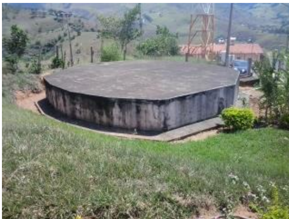
FIGURA 25 – RESERVATÓRIO R1 (FONTE: VALLENGE, 2014)
