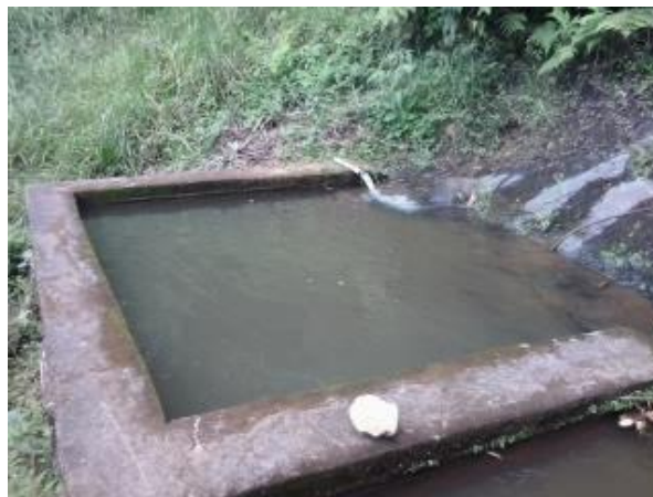
FIGURA 19 – RESERVATÓRIO R1 (FONTE: VALLENGE, 2014)
