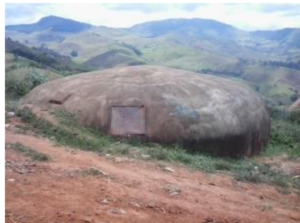
FIGURA 26 – RESERVATÓRIO R2 (FONTE: VALLENGE, 2014)
