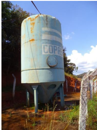
FIGURA 29 – RESERVATÓRIO NOVO HORIZONTE (VISTA 1) (FONTE: VALLENGE, 2014)
