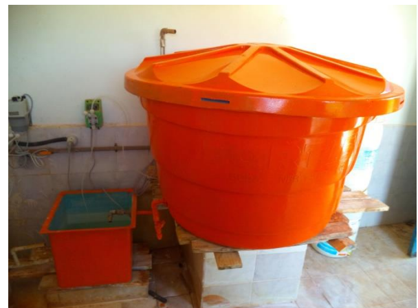
FIGURA 26 – CASA QUÍMICA (VISTA 2) (FONTE: VALLENGE, 2014)
