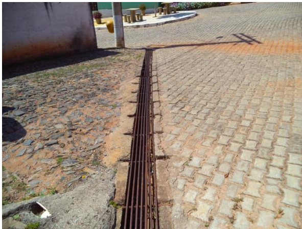
FIGURA 52 – BOCA-DE-LOBO NA RUA (FONTE: VALLENGE, 2014)
