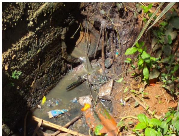
FIGURA 37 – PONTO DE DESPEJO DE ESGOTO (FONTE: VALLENGE, 2014)
