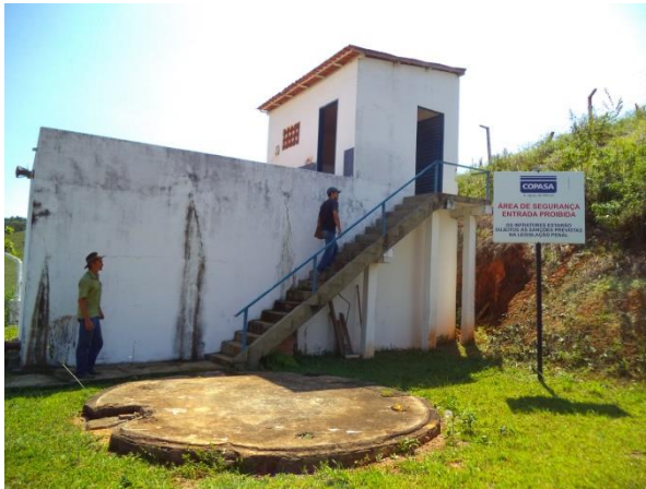
FIGURA 23 – RESERVATÓRIO R1 (FONTE: VALLENGE, 2014)
