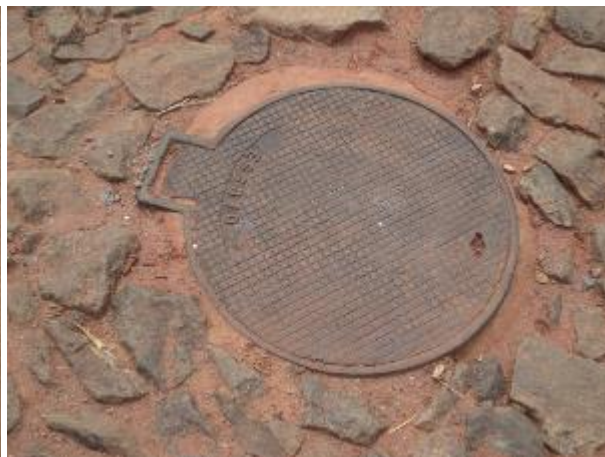
FIGURA 159 – POÇO DE VISITA – POVOADO DE GARAPA (FONTE: VALLENGE, 2014)
