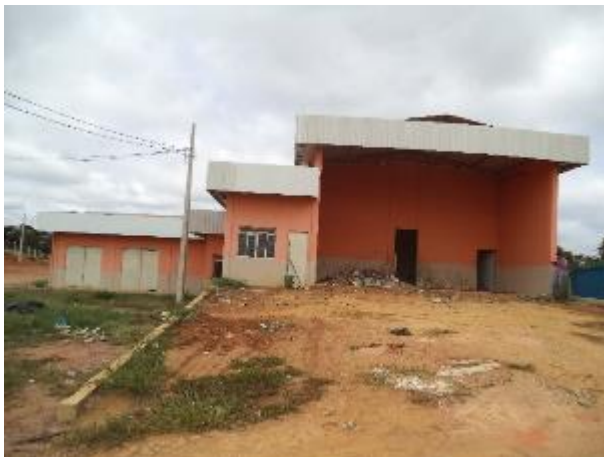
FIGURA 174 – USINA DE TRIAGEM E COMPOSTAGEM – PARTE INTERNA (FONTE: VALLENGE, 2014)
