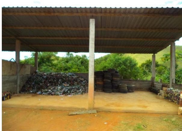
FIGURA 57 – ACONDICIONAMENTO DE PNEUS (VISTA 1) (Fonte: VALLENGE, 2014)
