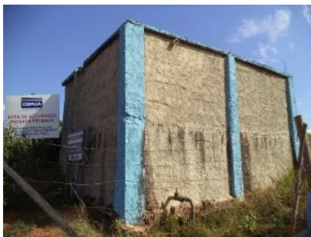
FIGURA 112 – RESERVATÓRIO-R3 (VISTA 1) (FONTE: VALLENGE, 2014)
