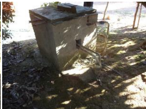
FIGURA 135 – POÇO TUBULAR P3 – POVOADO DE CHÁCARA (VISTA 2) (FONTE: VALLENGE, 2014)
