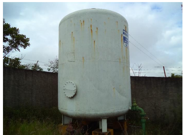
FIGURA 33 – RESERVATÓRIO-R2 (VISTA 2) (FONTE: VALLENGE, 2014)
