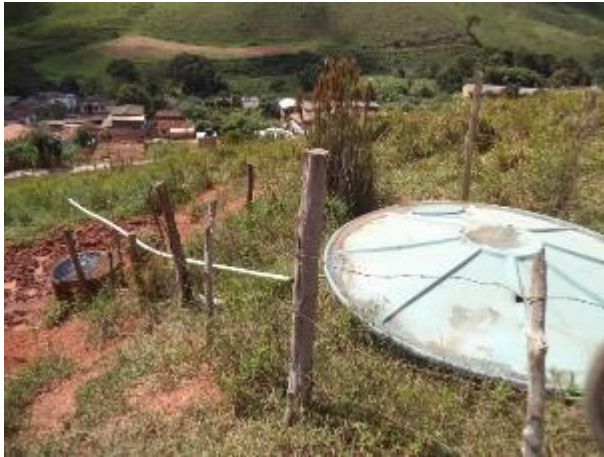
FIGURA 122 – RESERVATÓRIO – POVOADO DE GARAPA (VISTA 1) (FONTE: VALLENGE, 2014)
