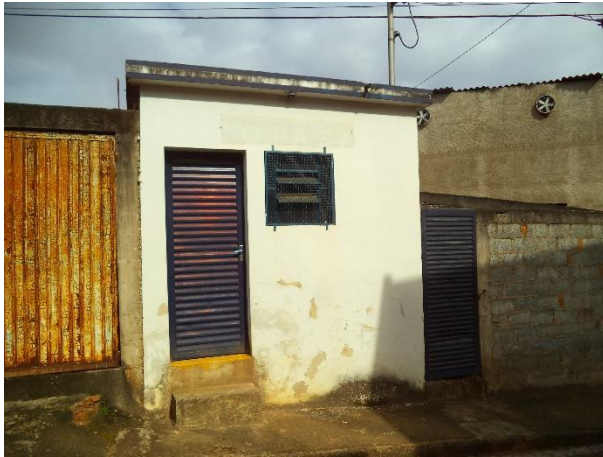
FIGURA 30 – BOOSTER 1 e ETA (FONTE: VALLENGE, 2014)
