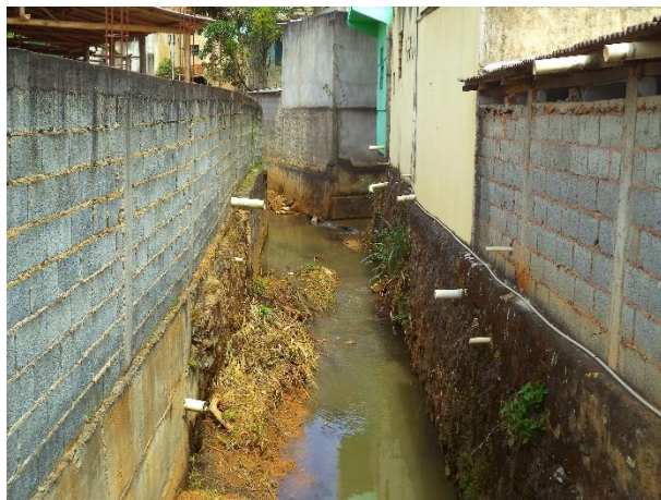
FIGURA 44 – LANÇAMENTO DIRETO DE EFLUENTES (VISTA 1) (FONTE: VALLENGE, 2014)
