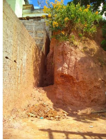
FIGURA 66 – TALUDE PRÓXIMO A RESIDÊNCIAS (FONTE: VALLENGE, 2014)
