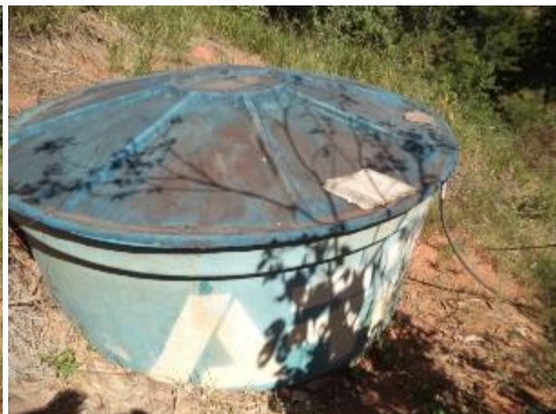
FIGURA 129 – RESERVATÓRIO-R2 – POVOADO DE FONSECA (VISTA 2) (FONTE: VALLENGE, 2014)
