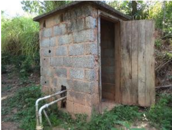
FIGURA 132 – POÇO TUBULAR P2 – POVOADO DE CHÁCARA (VISTA 1) (FONTE: VALLENGE, 2014)
