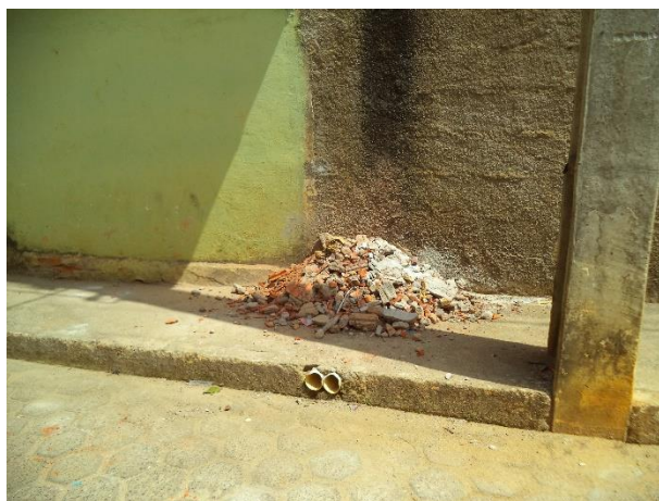
FIGURA 53 – ARMAZENAMENTO IRREGULAR DE RESÍDUOS DE CONSTRUÇÃO CIVIL – BEIRAS DE ESTRADAS (FONTE: VALLENGE, 2014)
