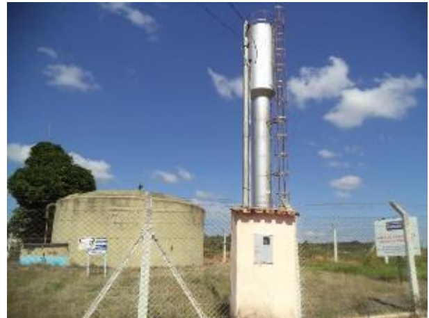
FIGURA 109 – RESERVATÓRIO-R2 E R1 (VISTA 2) (FONTE: VALLENGE, 2014)
