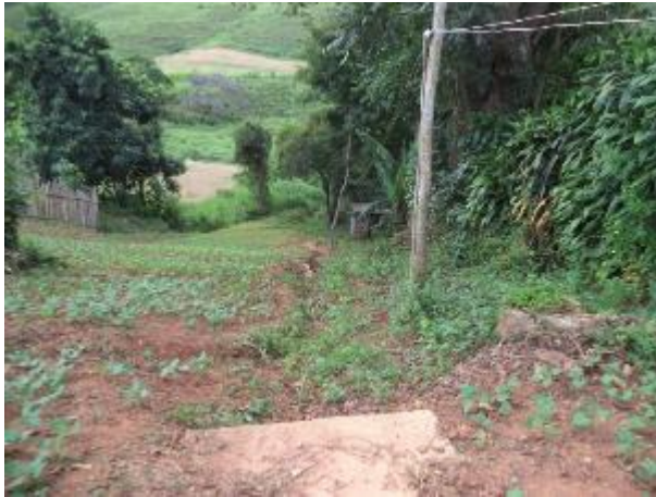
FIGURA 120 – POÇO TUBULAR – POVOADO DE GARAPA (VISTA 1) (FONTE: VALLENGE, 2014)
