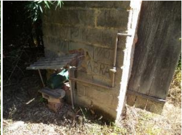
FIGURA 125 – POÇO TUBULAR – POVOADO DE FONSECA (VISTA 2) (FONTE: VALLENGE, 2014)
