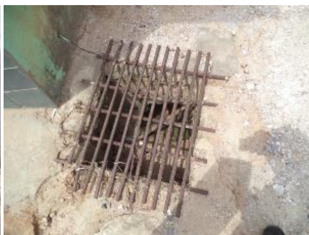
FIGURA 183 – MICRODRENAGEM – DISTRITO DE AIRÕES (FONTE: VALLENGE, 2014)
