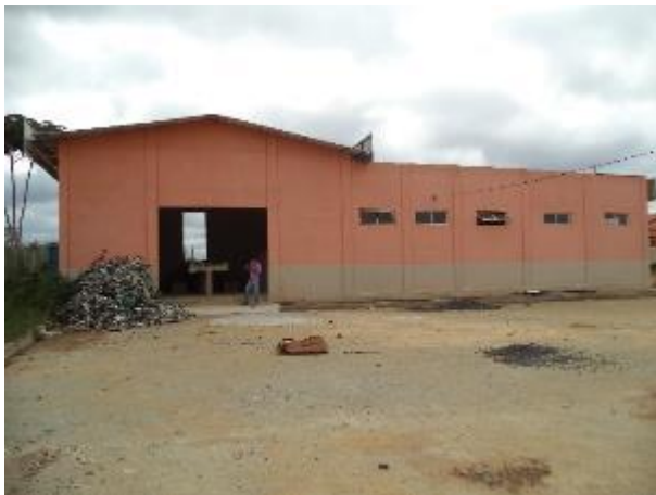
FIGURA 178 – PÁTIO DE COMPOSTAGEM (VISTA 1) (FONTE: VALLENGE, 2014)
