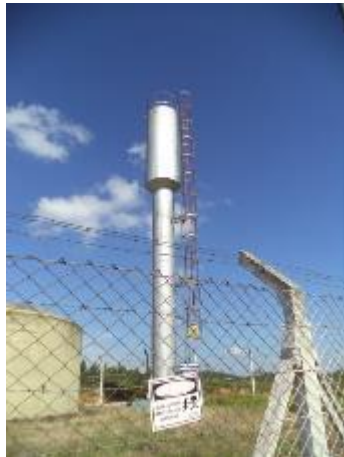
FIGURA 108 – RESERVATÓRIO-R2 (VISTA 1) (FONTE: VALLENGE, 2014)
