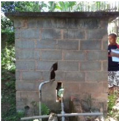
FIGURA 130 – POÇO TUBULAR-P1 – POVOADO DE CHÁCARA (VISTA 1) (FONTE: VALLENGE, 2014)
