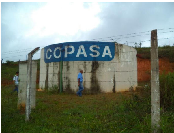
FIGURA 28 – RESERVATÓRIO R1 (VISTA 1) (FONTE: VALLENGE, 2014)
