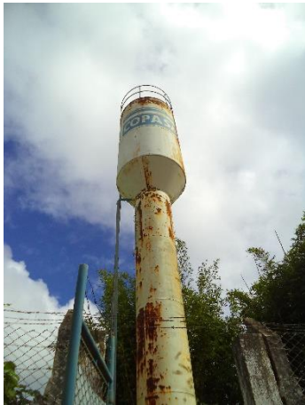
FIGURA 40 – RESERVATÓRIO-R5 (VISTA 1) (FONTE: VALLENGE, 2014)
