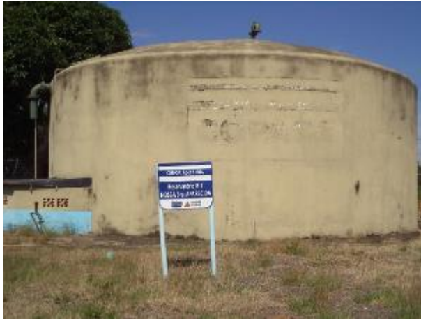
FIGURA 104 – RESERVATÓRIO R1 (FONTE: VALLENGE, 2014)
