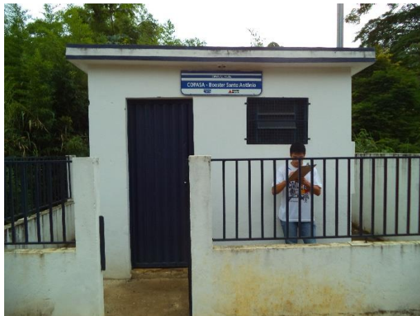
FIGURA 34 – BOOSTER-2 E ETA (FONTE: VALLENGE, 2014)
