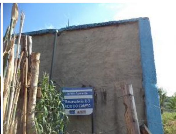
FIGURA 113 – RESERVATÓRIO-R3 (VISTA 2) (FONTE: VALLENGE, 2014)
