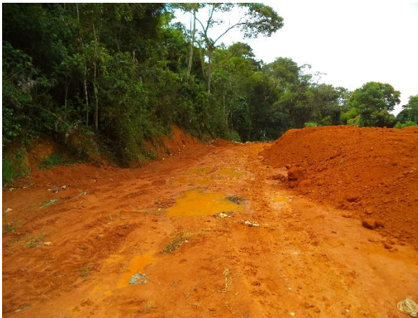
FIGURA 61 – VALA (VISTA 1) (FONTE: VALLENGE, 2014)
