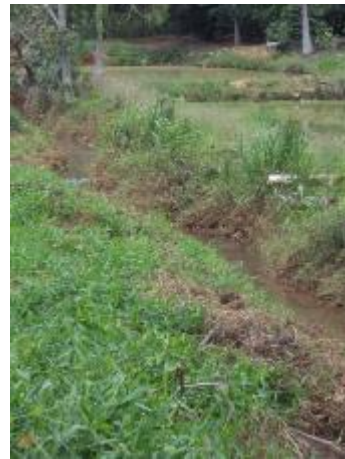
FIGURA 157 – LANÇAMENTO IN NATURA DE ESGOTO (VISTA 2) (FONTE: VALLENGE, 2014)
