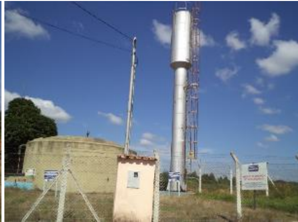
FIGURA 105 – RESERVATÓRIO R1 E R2 (FONTE: VALLENGE, 2014)
