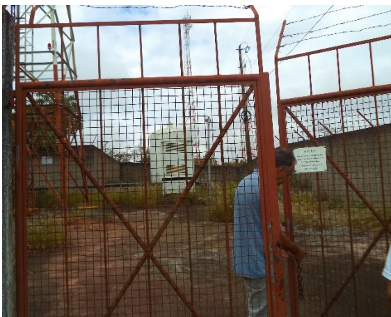
FIGURA 32 – RESERVATÓRIO-R2 (VISTA 1) (FONTE: VALLENGE, 2014)
