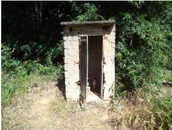
FIGURA 124 – POÇO TUBULAR – POVOADO DE FONSECA (VISTA 1) (FONTE: VALLENGE, 2014)
