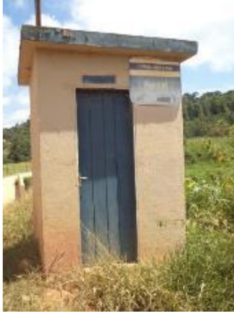
FIGURA 116 – POÇO E-01 (VISTA 1) (FONTE: VALLENGE, 2014)
