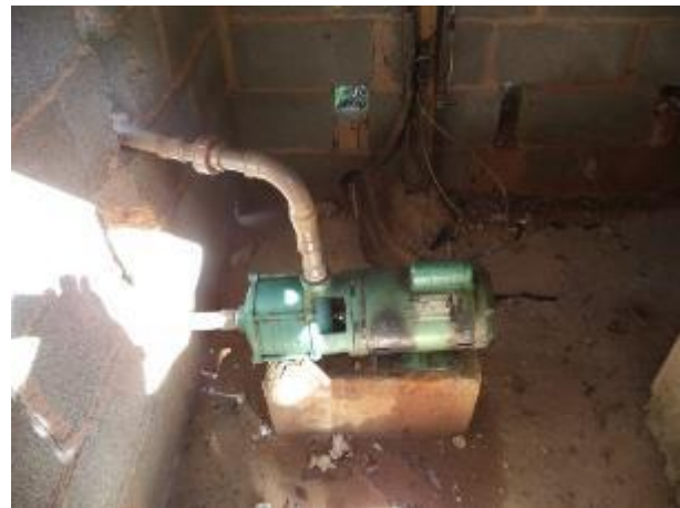
FIGURA 131 – POÇO TUBULAR-P1 – POVOADO DE CHÁCARA (VISTA 2) (FONTE: VALLENGE, 2014)
