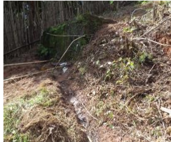
FIGURA 127 – RESERVATÓRIO-R1 – POVOADO DE FONSECA (VISTA 2) (FONTE: VALLENGE, 2014)
