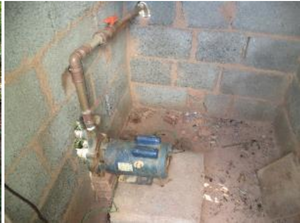
FIGURA 133 – POÇO TUBULAR P2 – POVOADO DE CHÁCARA (VISTA 2) (FONTE: VALLENGE, 2014)
