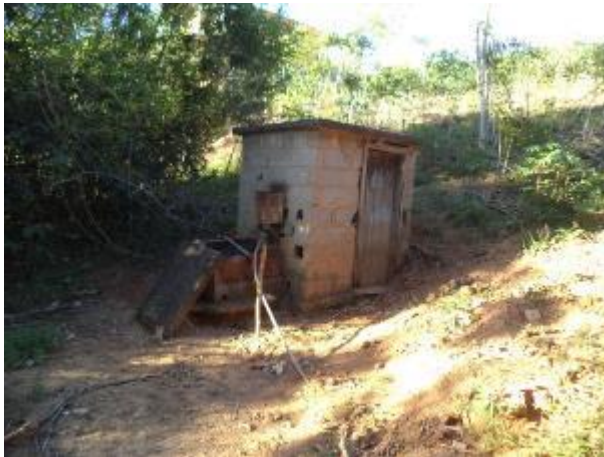
FIGURA 144 – POÇO TUBULAR P3 – POVOADO DE BARROS (VISTA 1) (FONTE: VALLENGE, 2014)
