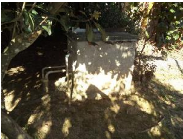
FIGURA 134 – POÇO TUBULAR P3 – POVOADO DE CHÁCARA (VISTA 1) (FONTE: VALLENGE, 2014)
