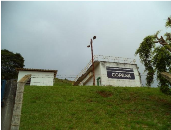
FIGURA 26 – EEAT 1 e ETA (FONTE: VALLENGE, 2014)
