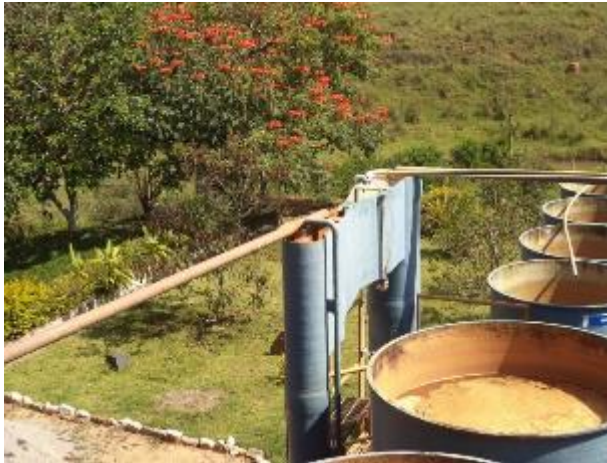
FIGURA 92 – ESTAÇÃO DE TRATAMENTO DE ÁGUA (VISTA 1)
