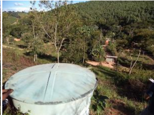
FIGURA 139 – RESERVATÓRIO R3 – POVOADO DE CHÁCARA (VISTA 2) (FONTE: VALLENGE, 2014)
