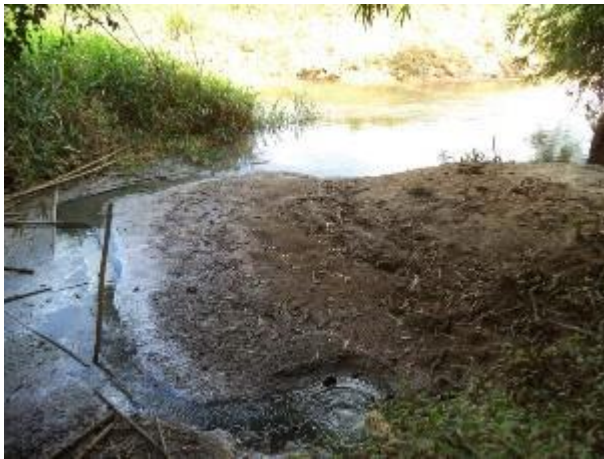
FIGURA 156 – LANÇAMENTO IN NATURA DE ESGOTO (VISTA 1) (FONTE: VALLENGE, 2014)
