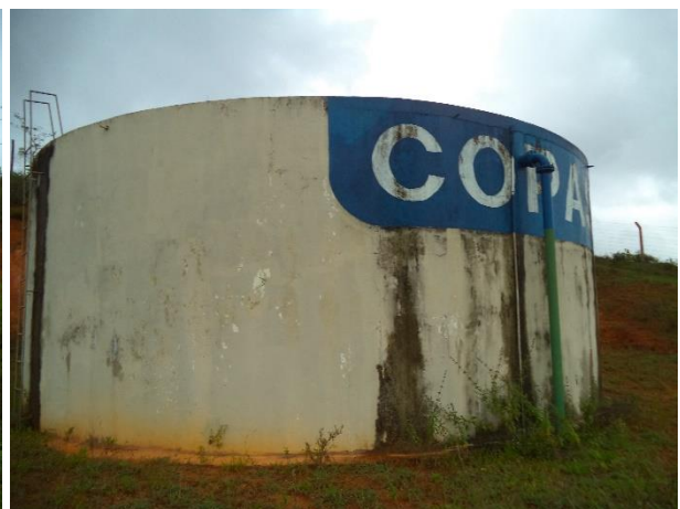
FIGURA 29 – RESERVATÓRIO R1 (VISTA 2) (FONTE: VALLENGE, 2014)
