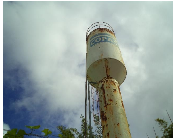
FIGURA 41 – RESERVATÓRIO-R5 (VISTA 2) (FONTE: VALLENGE, 2014)
