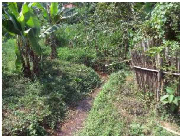
FIGURA 162 – LANÇAMENTO IN NATURA DE ESGOTO NO POVOADO DE FONSECA (FONTE: VALLENGE, 2014)
