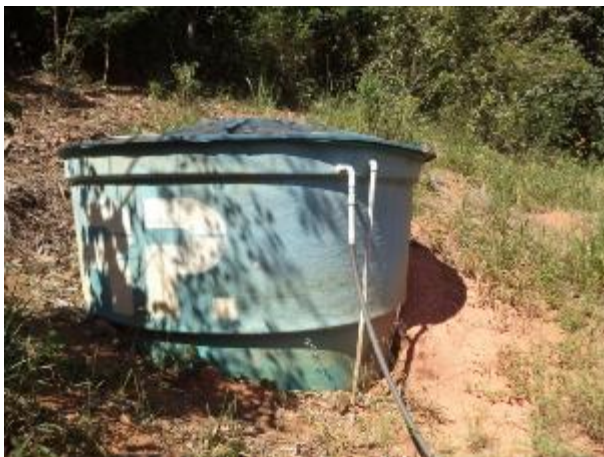
FIGURA 128 – RESERVATÓRIO-R2 – POVOADO DE FONSECA (VISTA 1) (FONTE: VALLENGE, 2014)
