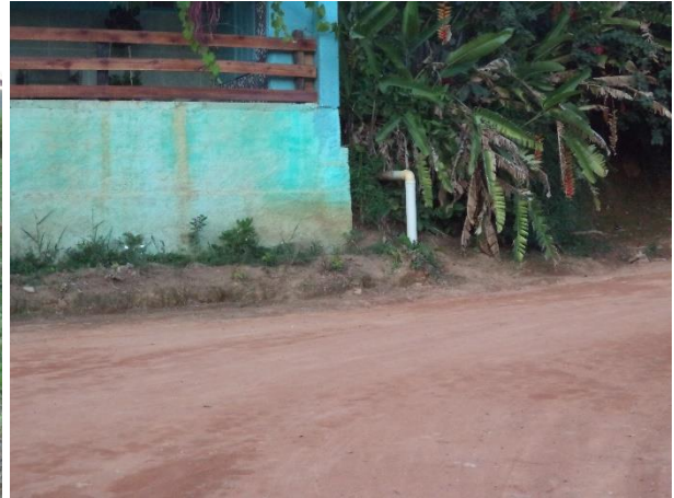
FIGURA 62 – TUBULAÇÃO EXPOSTA DE ESGOTO SANTA EFIGÊNIA (FONTE: VALLENGE, 2014)
