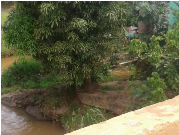
FIGURA 68 – LANÇAMENTO DE ESGOTO (FONTE: VALLENGE, 2014)
