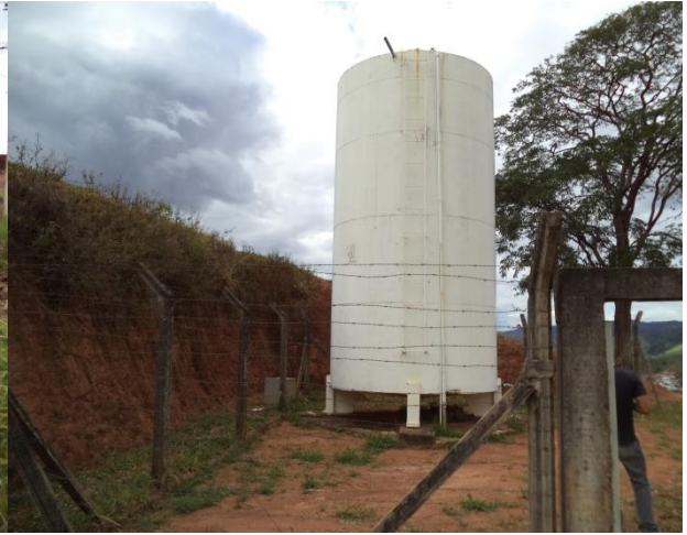
FIGURA 37 – RESERVATÓRIO R9 (FONTE: VALLENGE, 2014)
