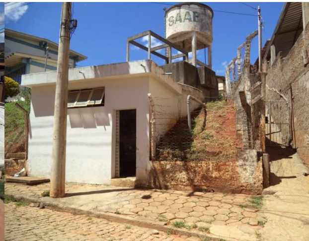
FIGURA 26 – ESTAÇÃO ELEVATÓRIA DE ÁGUA TRATADA (FONTE: VALLENGE, 2014)
