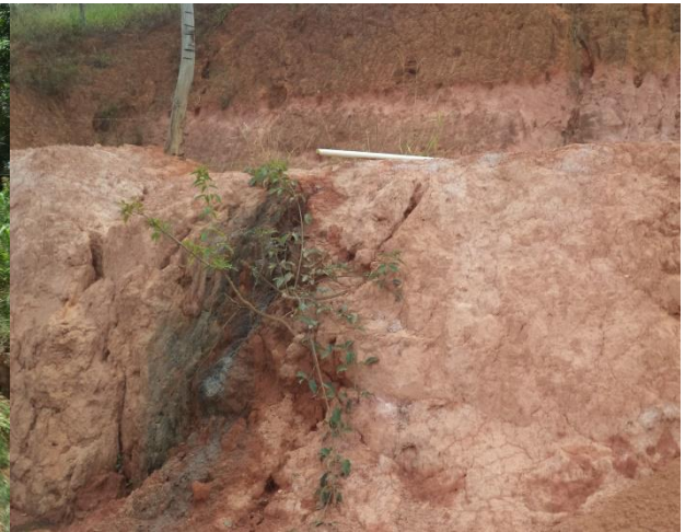
FIGURA 58 – ESGOTO A CÉU ABERTO BAIRRO VALE DO SOL (FONTE: VALLENGE, 2014)
