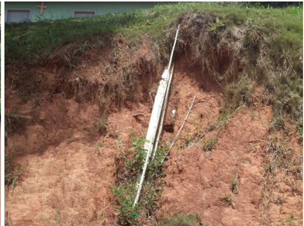
FIGURA 66 – LANÇAMENTO DE ESGOTO APARECIDA (VISTA 2) (FONTE: VALLENGE, 2014)
