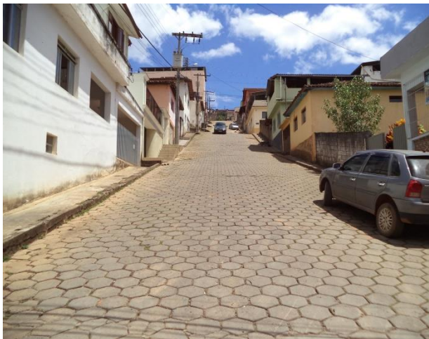
FIGURA 92 – DRENAGEM SUPERFICIAL VISTA 1 (FONTE: VALLENGE, 2014)
