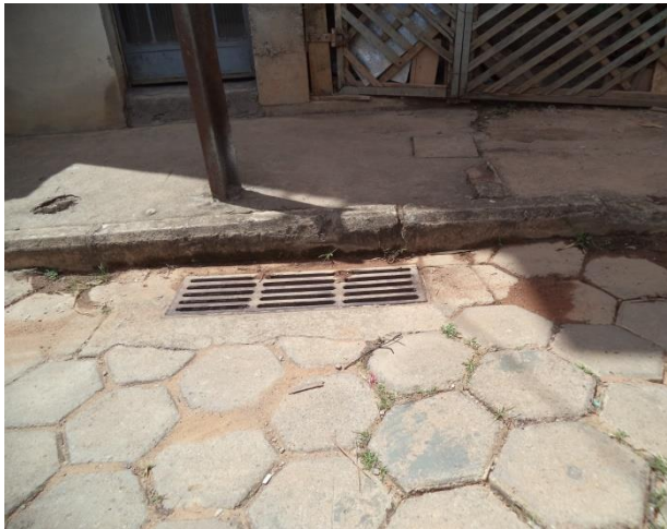
FIGURA 90 – GRADEAMENTO VISTA 1 (FONTE: VALLENGE, 2014)
