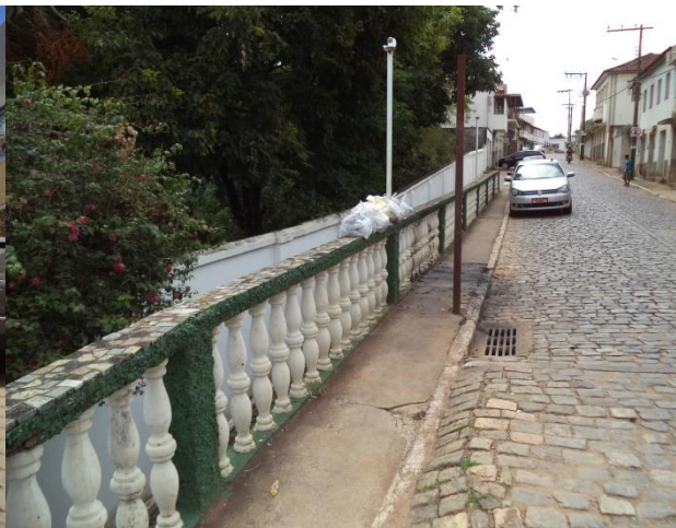
FIGURA 93 – DRENAGEM SUPERFICIAL VISTA 2 (FONTE: VALLENGE, 2014)
