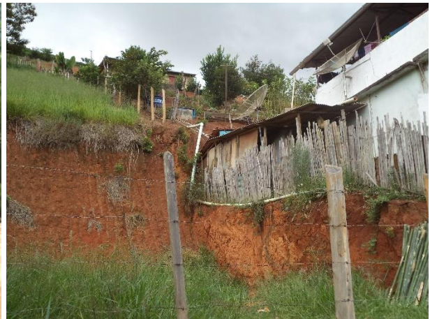
FIGURA 69 – TUBULAÇÃO DE ESGOTO EXPOSTA (FONTE: VALLENGE, 2014)
