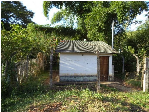
FIGURA 41 – POÇO 2 GRANADA (VISTA 1) (FONTE: VALLENGE, 2014)
