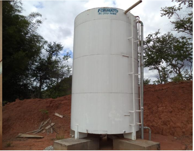
FIGURA 35 – RESERVATÓRIO R5 (FONTE: VALLENGE, 2014)
