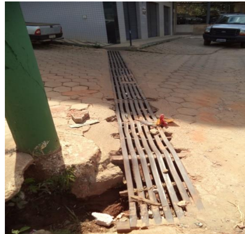
FIGURA 91 – GRADEAMENTO VISTA 2 (FONTE: VALLENGE, 2014)
