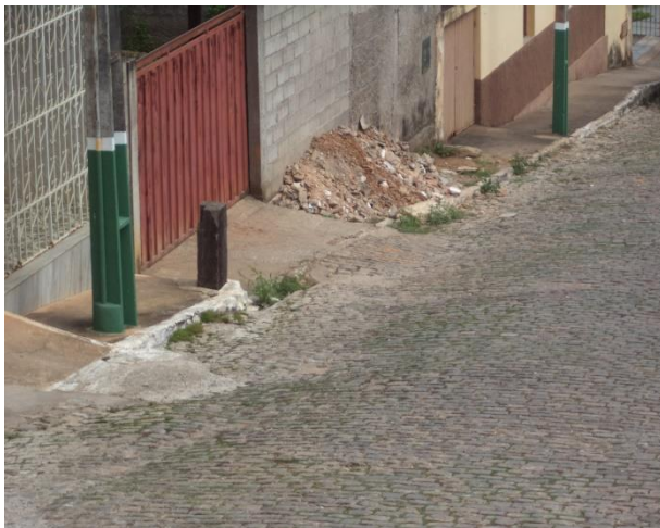
FIGURA 73 – RESÍDUOS DE CONSTRUÇÃO CIVIL (VISTA 1) (FONTE: VALLENGE, 2014)
