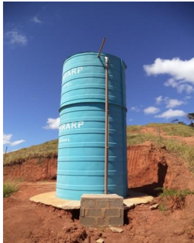
FIGURA 27 – RESERVATÓRIO R7 (FONTE: VALLENGE, 2014)
