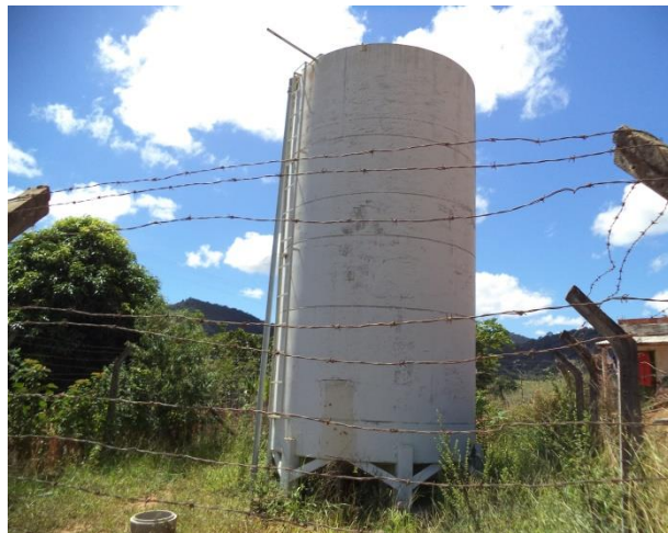
FIGURA 38 – RESERVATÓRIO R6 (FONTE: VALLENGE, 2014)
