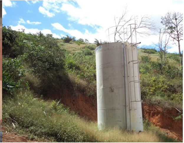
FIGURA 31 – RESERVATÓRIO R3 (FONTE: VALLENGE, 2014)
