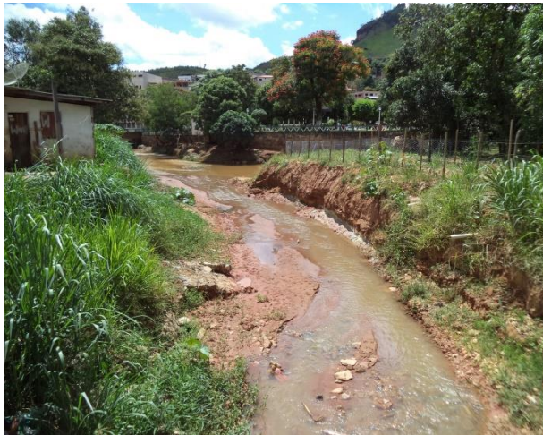
FIGURA 57 – PONTO DE DESPEJO DE ESGOTO IN NATURA CÓRREGO DOS DUQUES (FONTE: VALLENGE, 2014)
