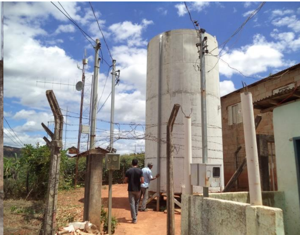
FIGURA 29 – RESERVATÓRIO R2 (FONTE: VALLENGE, 2014)
