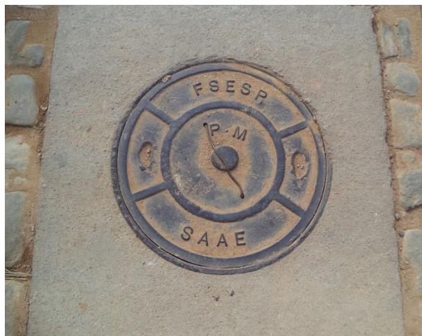
FIGURA 56 –POÇO DE VISITA (FONTE: VALLENGE, 2014)
