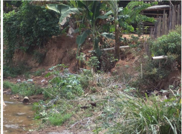
FIGURA 64 – LANÇAMENTO DE ESGOTO BARROSO (FONTE: VALLENGE, 2014)
