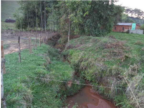
FIGURA 61 – LANÇAMENTO DE ESGOTO CÓRREGO SANTA EFIGÊNIA (FONTE: VALLENGE, 2014)
