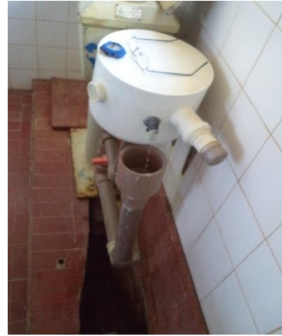
FIGURA 20 – CALHA PARSHALL (VISTA 2) (FONTE: VALLENGE, 2014)
