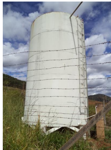
FIGURA 33 – RESERVATÓRIO R4 (FONTE: VALLENGE, 2014)
