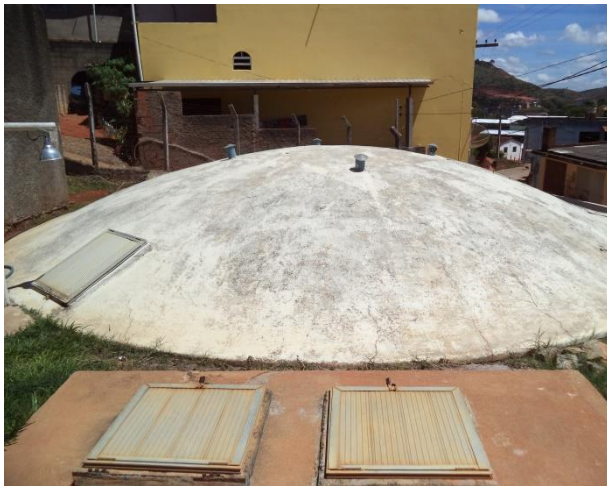
FIGURA 25 – RESERVATÓRIO R1 (FONTE: VALLENGE, 2014)
