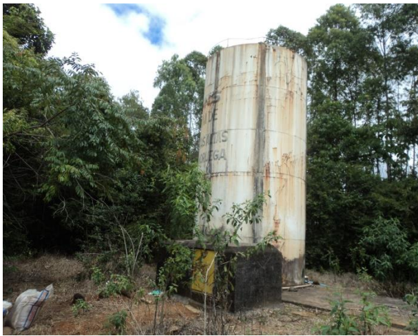
FIGURA 26 – RESERVATÓRIO R2 (FONTE: VALLENGE, 2014)
