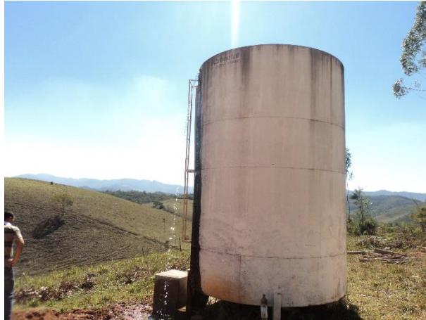
FIGURA 34 – RESERVATÓRIO DE JEQUITIBÁ (FONTE: VALLENGE, 2014)
