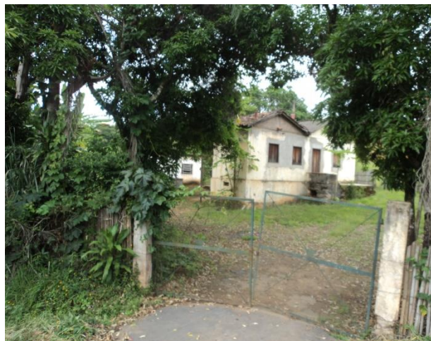
FIGURA 43 – NOVA ÁREA DA ESTAÇÃO DE TRATAMENTO DE ESGOTO (FONTE: VALLENGE, 2014)
