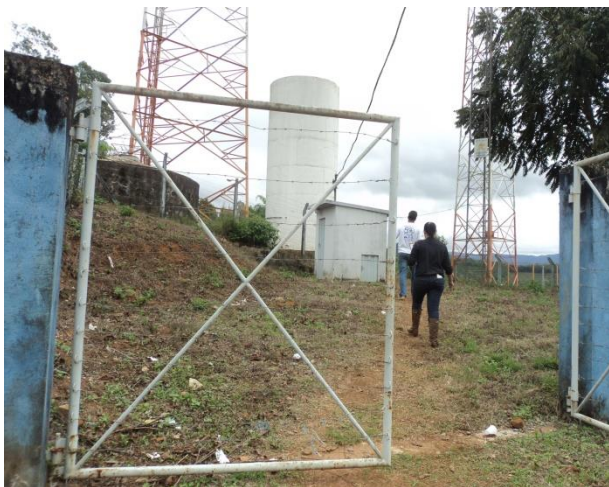
FIGURA 24 – RESERVATÓRIO R1 (FONTE: VALLENGE, 2014)
