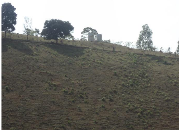
FIGURA 41 – RESERVATÓRIOS R1 E R2 (FONTE: VALLENGE, 2014)
