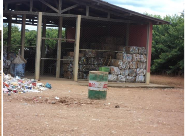
FIGURA 50– USINA DE TRIAGEM E COMPOSTAGEM - GALPÃO (FONTE: VALLENGE, 2014)
