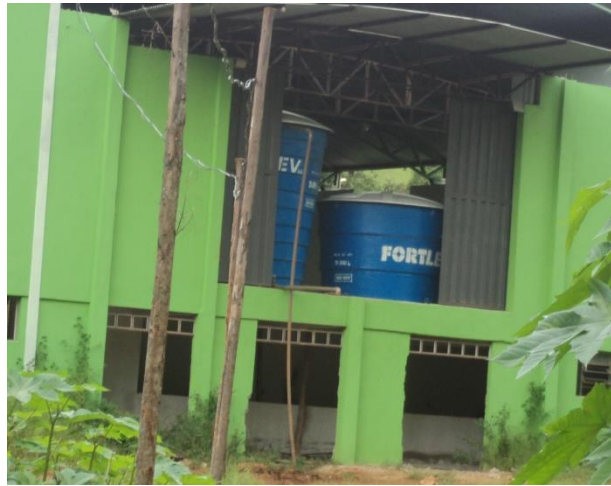
FIGURA 30 – RESERVATÓRIO R4 E R5 (FONTE: VALLENGE, 2014)
