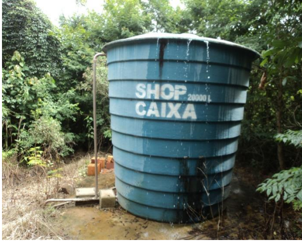
FIGURA 28 – RESERVATÓRIO R3 (FONTE: VALLENGE, 2014)
