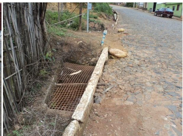
FIGURA 53 – BOCA-DE-LOBO NO PASSEIO (FONTE: VALLENGE, 2014)
