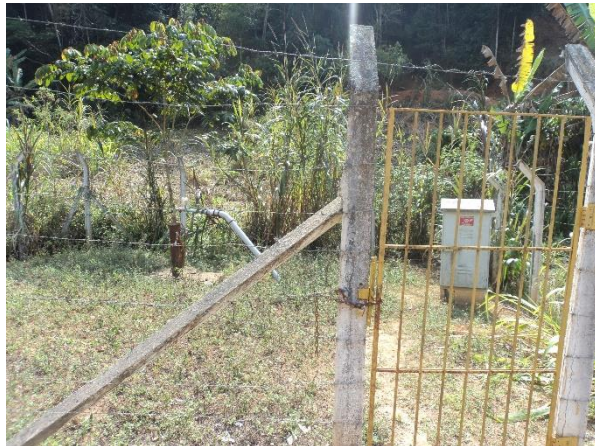
FIGURA 40 – POÇO TUBULAR BOA VISTA (VISTA 2) (FONTE: VALLENGE, 2014)
