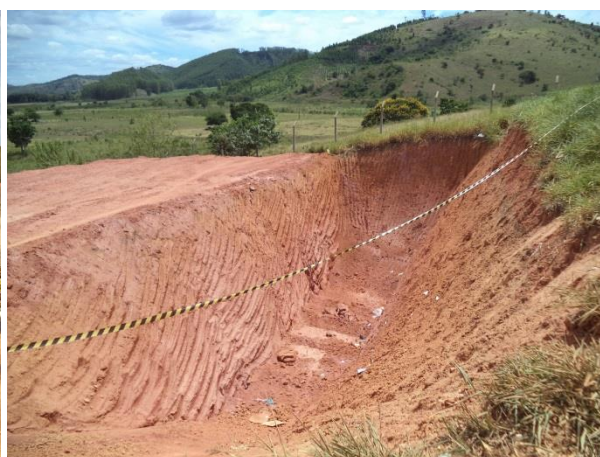
Figura 97 – Futura área de aterramento UTC (Fonte: Vallenge, 2014)
