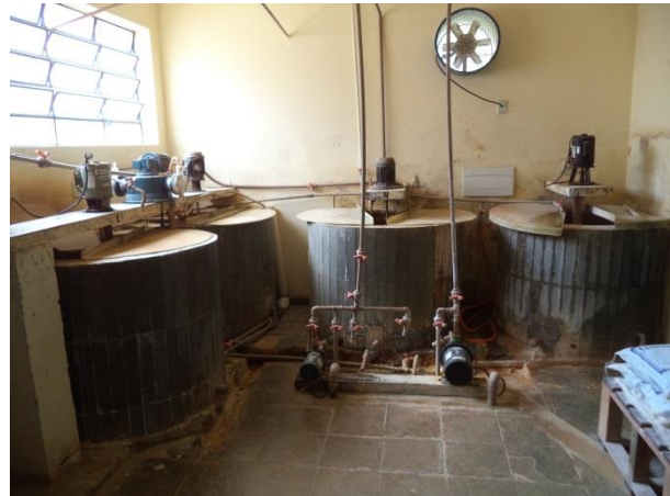
Figura 29 – Sala de química (Fonte: Vallenge, 2014)
