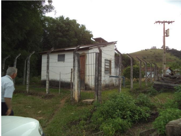
Figura 46 – Captação Bicuíba (vista 1) (Fonte: Vallenge, 2014)
