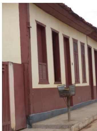
Figura 99 – Acondicionamento de RSU – distrito de Bicuíba (vista 2) (Fonte: Vallenge, 2014)
