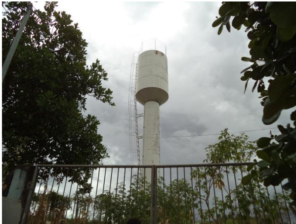
Figura 34 – Reservatório R5 (Fonte: Vallenge, 2014)
