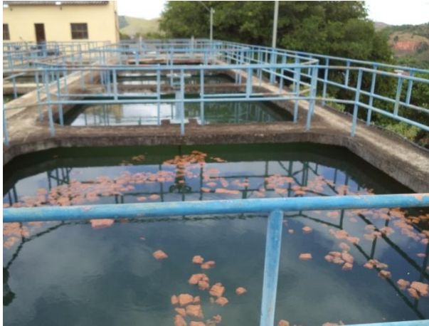
Figura 24 – Estação de tratamento de água (vista 3) (Fonte: Vallenge, 2014)
