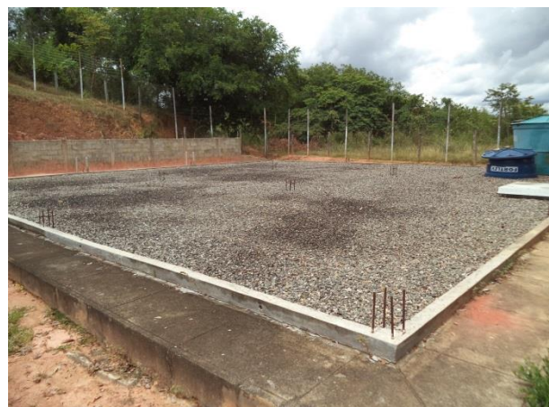
Figura 31 – Reservatório R2 (Fonte: Vallenge, 2014)
