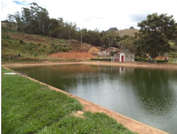
Figura 84 – ETE Distrito de Bicuíba (vista 5) (Fonte: Vallenge, 2014)
