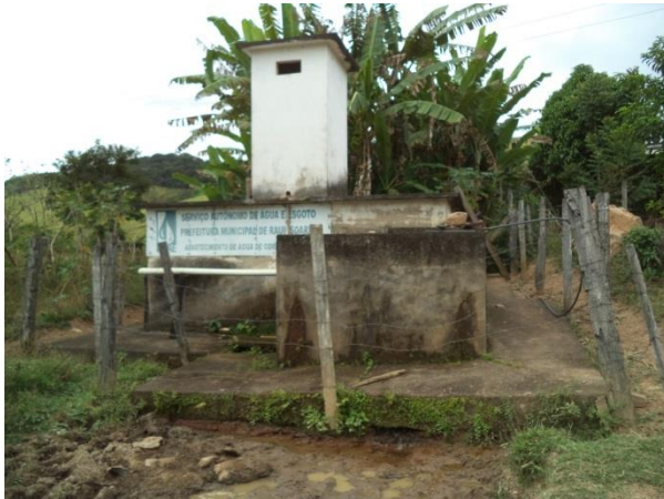
Figura 70 – Reservação de água bruta Cornélio Alves (Fonte: Vallenge, 2014)
