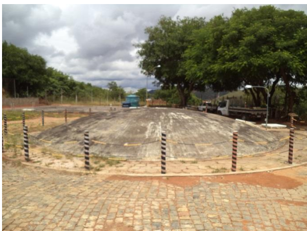
Figura 30 – Reservatório R1 (Fonte: Vallenge, 2014)
