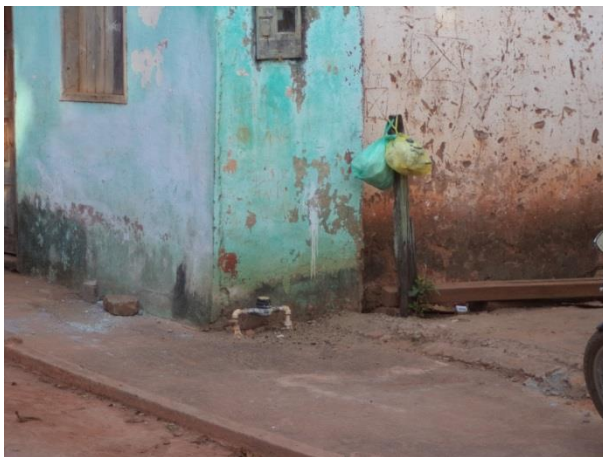
Figura 101 – Acondicionamento de RSU – distrito de Santana do Tabuleiro (Fonte: Vallenge, 2014)
