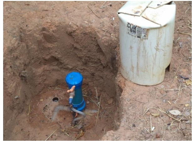
Figura 71 – Sistema de filtração Cornélio Alves (Fonte: Vallenge, 2014)
