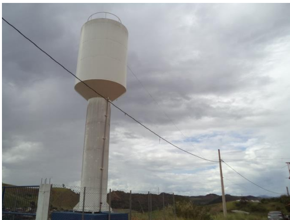
Figura 36 – Reservatório R7 (Fonte: Vallenge, 2014)
