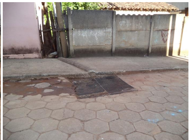
Figura 106 – Microdrenagem – distrito Santana do Tabuleiro (Fonte: Vallenge, 2014)
