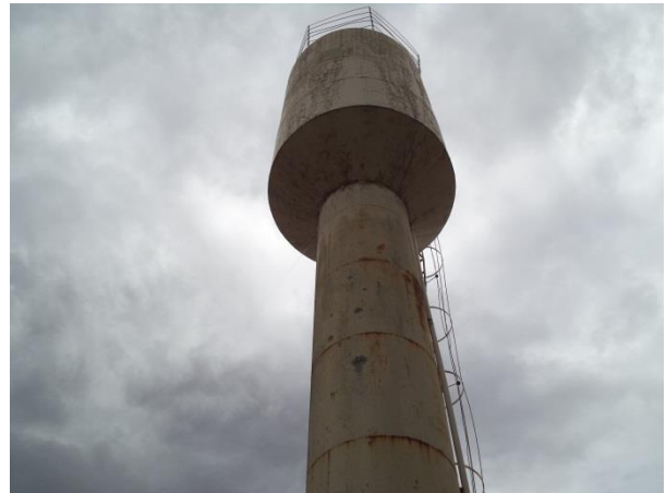
Figura 35 – Reservatório R6 (Fonte: Vallenge, 2014)
