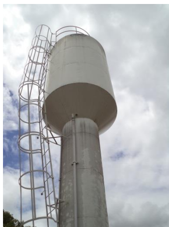
Figura 32 – Reservatório R3 (Fonte: Vallenge, 2014)
