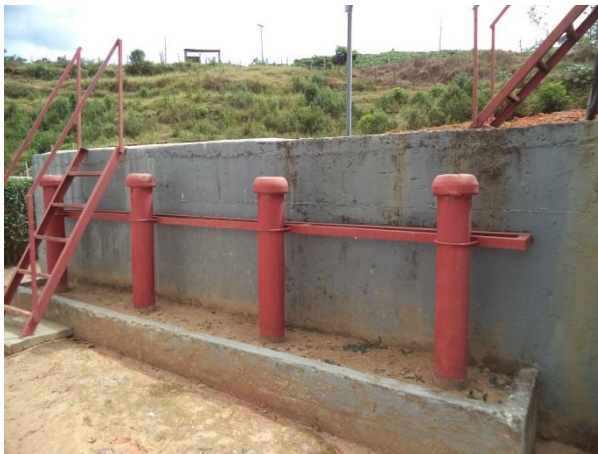
Figura 82 – ETE Distrito de Bicuíba (vista 3) (Fonte: Vallenge, 2014)
