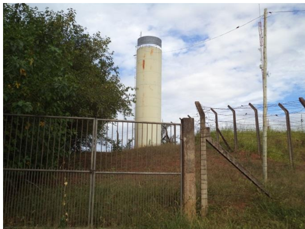
Figura 38 – Reservatório R9 (Fonte: Vallenge, 2014)
