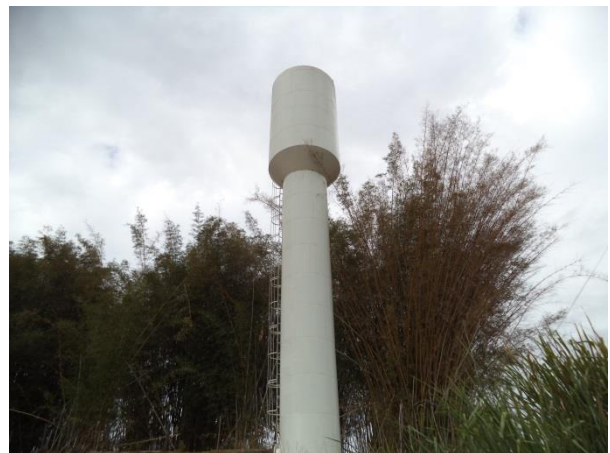
Figura 37 – Reservatório R8 (Fonte: Vallenge, 2014)
