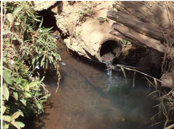
Figura 88 – Ponto de despejo de esgoto-Córrego São Vicente – distrito de São Vicente da Estrela (Vista 2) (Fonte: Vallenge, 2014)
