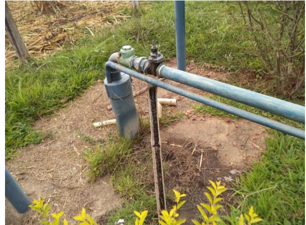
Figura 47 – Captação Bicuíba (vista 2) (Fonte: Vallenge, 2014)
