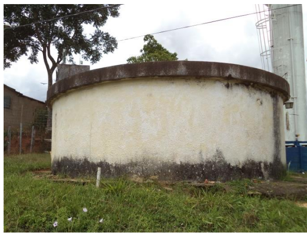
Figura 33 – Reservatório R4 (Fonte: Vallenge, 2014)
