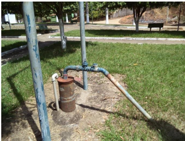
Figura 57 – Captação São Vicente da Estrela (vista 1) (Fonte: Vallenge, 2014)
