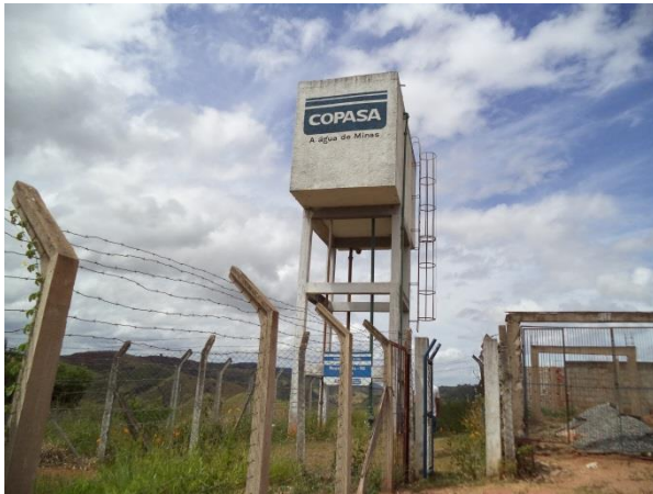
FIGURA 29 – RESERVATÓRIO R5 (FONTE: VALLENGE, 2014)
