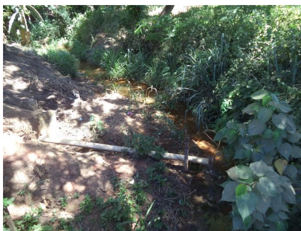
FIGURA 43 – LANÇAMENTO DE ESGOTO ÁGUAS FÉRREAS (FONTE: VALLENGE, 2014)
