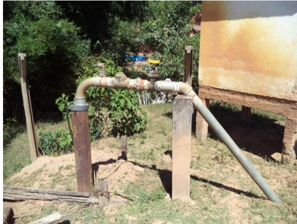
FIGURA 32 – POÇO ÁGUAS FÉRREAS (FONTE: VALLENGE, 2014)
