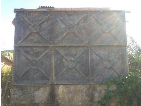
FIGURA 37 – RESERVATÓRIO R2 ÁGUAS FÉRREAS (VISTA 1) (FONTE: VALLENGE, 2014)
