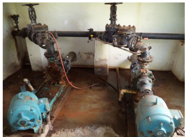
FIGURA 23 – EEAB 2 (VISTA 2) (FONTE: VALLENGE, 2014)
