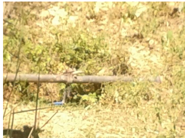
FIGURA 34 – BARRAGEM DE NÍVEL ÁGUAS FÉRREAS (VISTA 2) (FONTE: VALLENGE, 2014)
