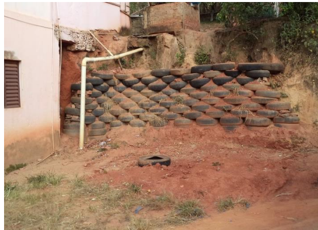
FIGURA 55 – UTILIZAÇÃO DE PNEUS NA CONTENÇÃO DE BARREIRAS (FONTE: VALLENGE, 2014)
