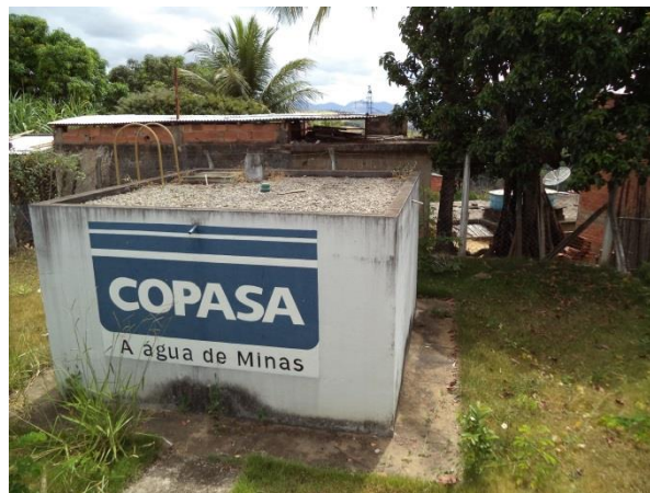
FIGURA 31 – RESERVATÓRIO R4 (FONTE: VALLENGE, 2014)
