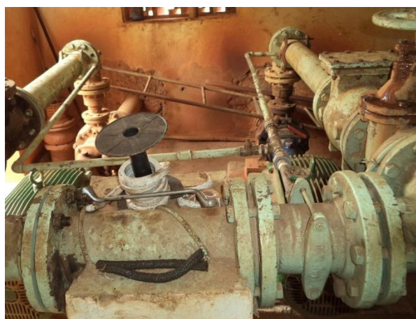
FIGURA 19 – EEAB 1 (VISTA 2) (FONTE: VALLENGE, 2014)
