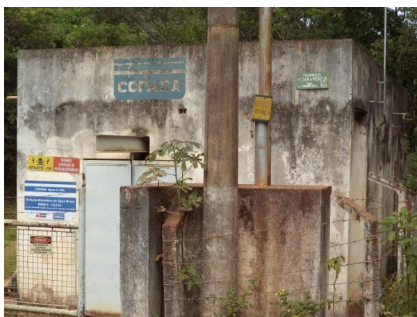
FIGURA 18 – EEAB 1 (VISTA 1) (FONTE: VALLENGE, 2014)
