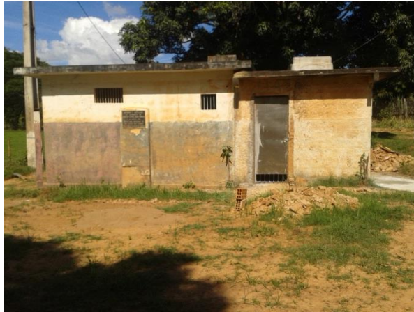
FIGURA 65 – DOMICÍLIO SUSCEPTÍVEL A INUNDAÇÃO (FONTE: VALLENGE, 2014)
