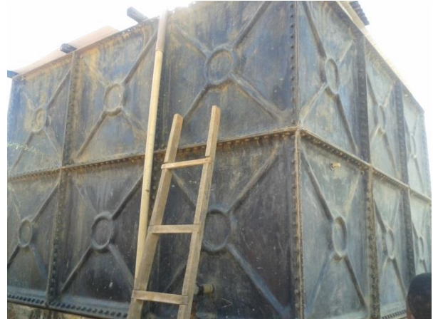
FIGURA 38 – RESERVATÓRIO R2 ÁGUAS FÉRREAS (VISTA 2) (FONTE: VALLENGE, 2014)
