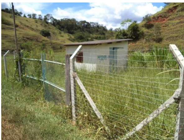
FIGURA 22 – EEAB 2 (VISTA 1) (FONTE: VALLENGE, 2014)
