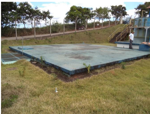
FIGURA 28 – RESERVATÓRIO R1 (FONTE: VALLENGE, 2014)
