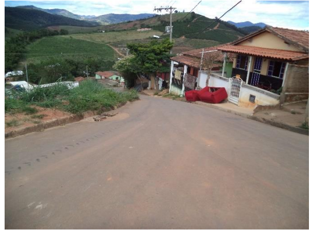
FIGURA 40 – RUA SEM REDE PLUVIAL (FONTE: VALLENGE, 2014)
