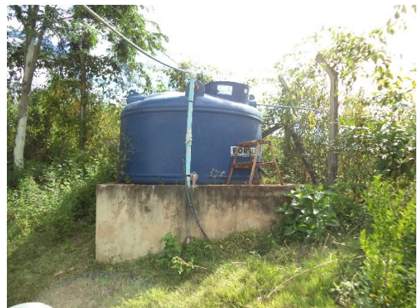
FIGURA 29 – RESERVATÓRIO R1.1 (FONTE: VALLENGE, 2014)
