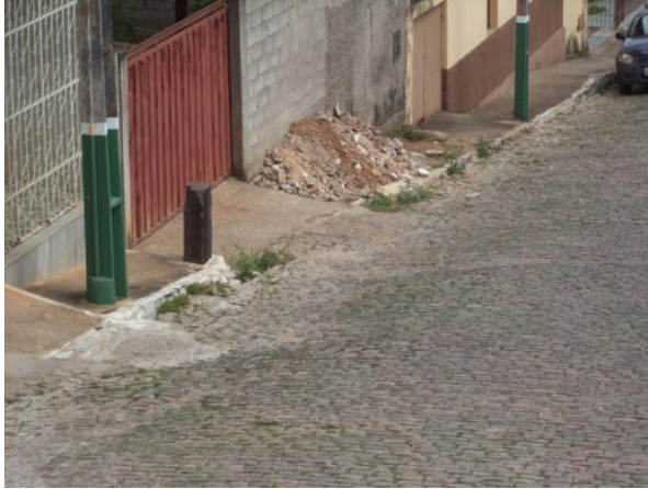
FIGURA 7 - RCC NA CALÇADA (FONTE: ACERVO DO AUTOR, 2014)
