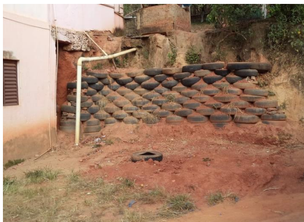
FIGURA 15 - UTILIZAÇÃO DE PNEUS NA CONTENÇÃO DE BARREIRAS (FONTE: ACERVO DO AUTOR, 2014)
