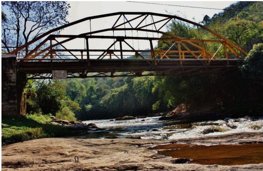
Figura 3 - Ponte de Ferro em Cipotânea
