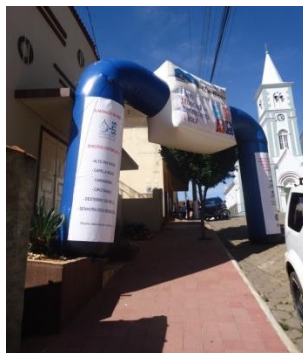
Figura 3 - Fachada do Salão Paroquial, local da 1ª Reunião de PMSB para os 6 (seis) municípios do Alto Rio Doce
