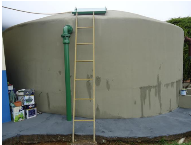
Figura 20 – Reservatório de capacidade de 100m 3 (sede)
