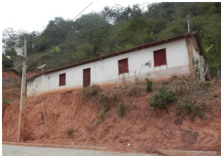
Figura 63 – Erosão no distrito de Estevão Araújo (continuação)
