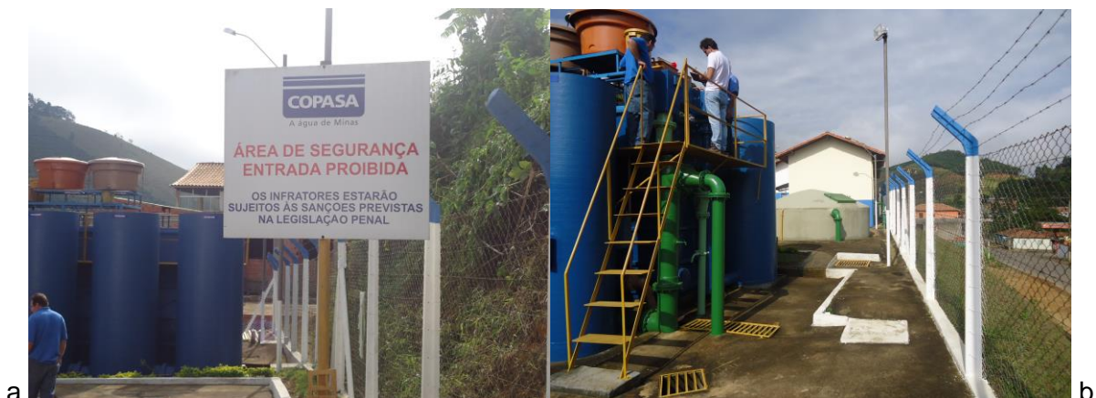
Figura 18 – Estruturas da ETA (sede)
