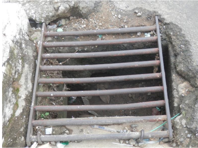
Figura 54 – Detalhe da rede de drenagem
