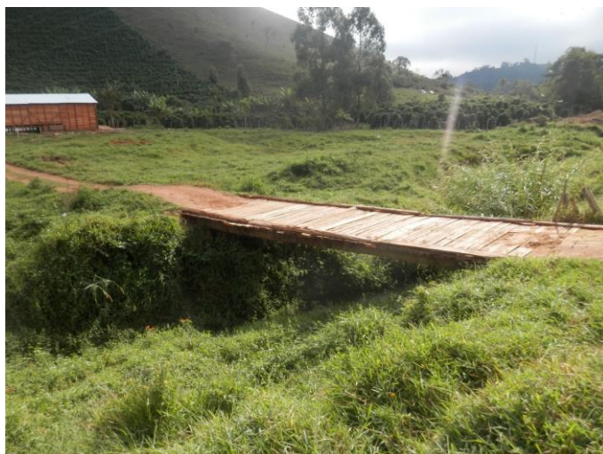
Figura 40 – Ponte sobre o ribeirão do Félix
