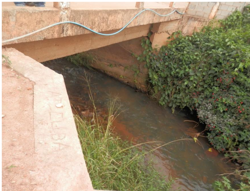
Figura 49 – Visão de perfil da ponte
