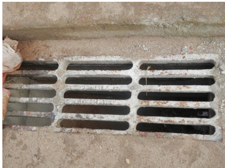
Figura 55 – Detalhe da rede de drenagem (continuação)
