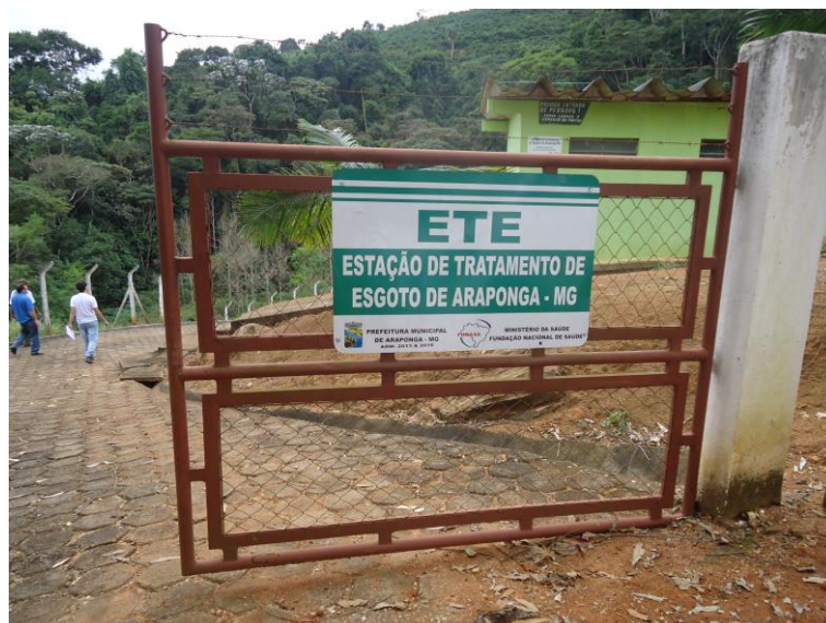
Figura 24 – Área sinalizada da entrada da ETE
