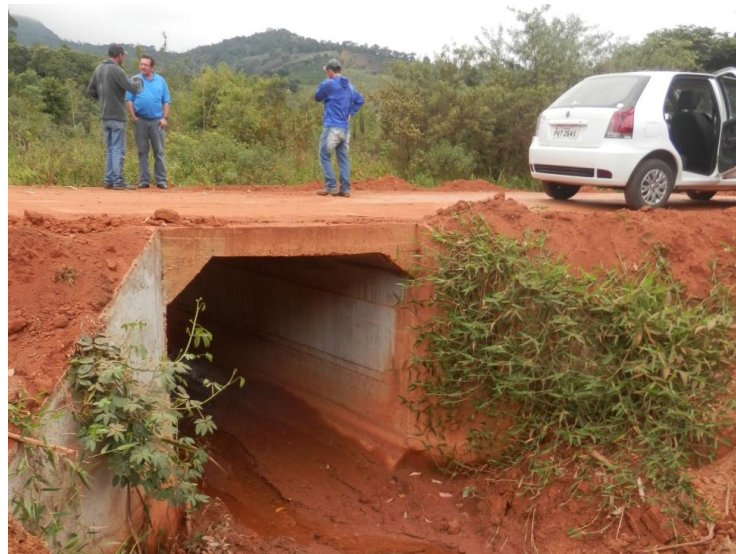
Figura 43 – Ponte recém construída
