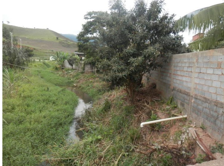
Figura 56 – Lançamento de esgotos diretamente no corpo d'água
