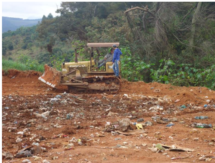
Figura 72 – Trator de esteira realizando a compactação de resíduos sólidos na vala ativa do lixão
