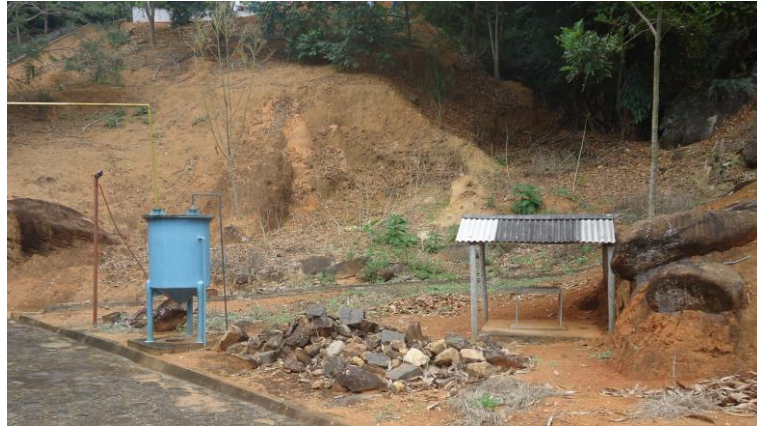
Figura 29 – Coletor de gases gerados no tratamento dos efluentes
