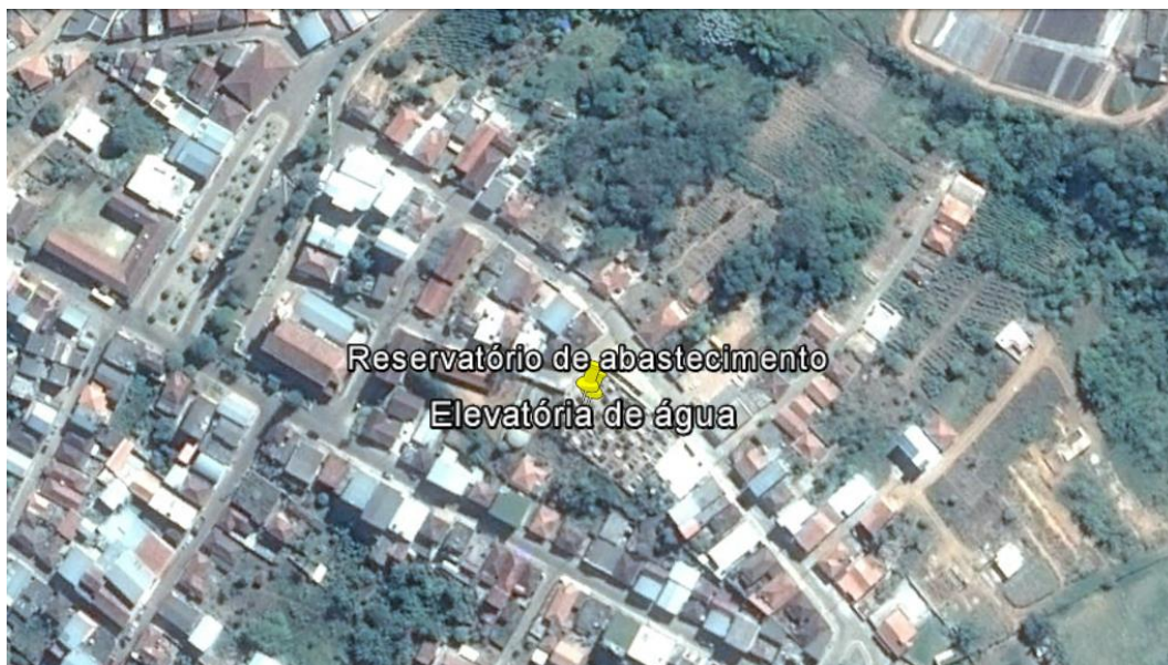
Figura 21 – Vista superior do local da estação elevatório da água e o reservatório de abastecimento da sede do município de Araponga
