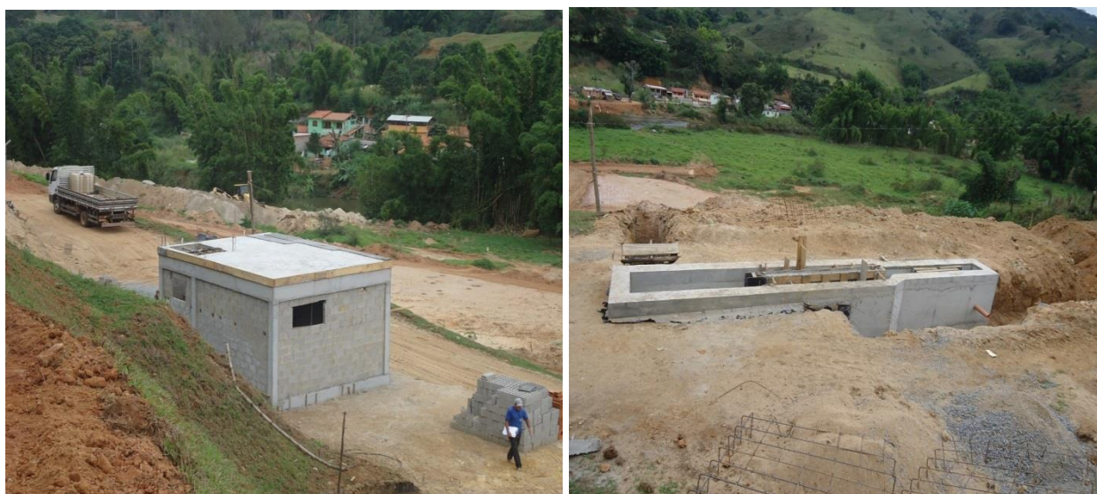
Figura 22 - Construção da ETE de Acaiaca
