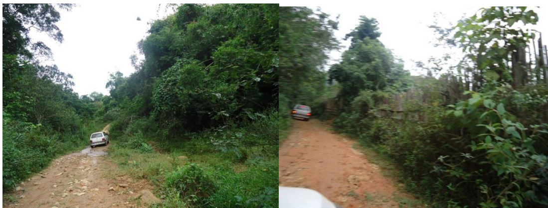
Figura 46 - Estrada de acesso à usina de triagem e compostagem
