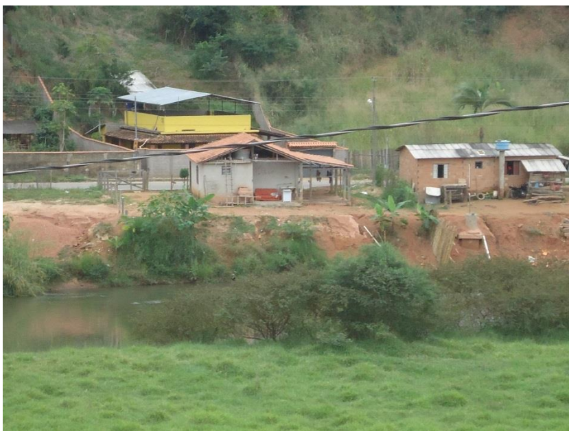
Figura 39 - Erosão das margens do rio do Carmo em Acaiaca
