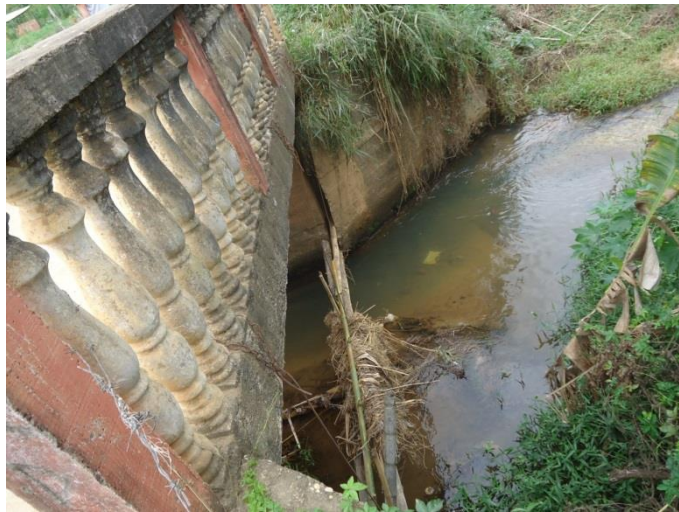
Figura 31 - Ponte 1 sobre o ribeirão Ubá
