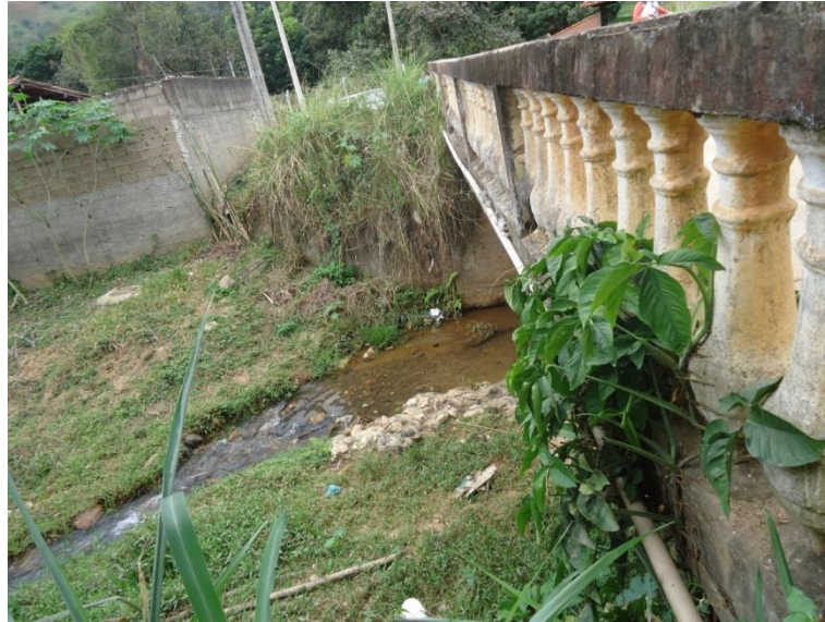
Figura 33 - Segunda ponte do ribeirão Ubá
