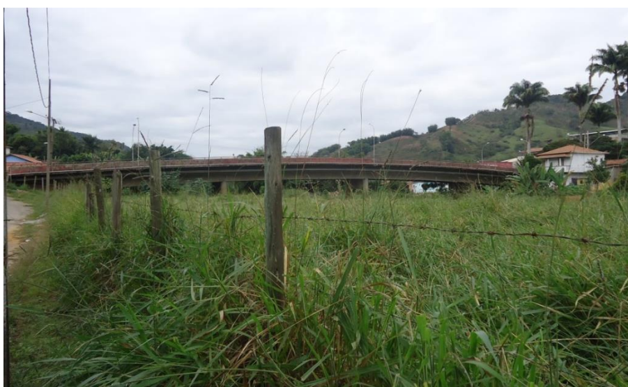
Figura 26 - Ponte sobre o rio do Carmo
