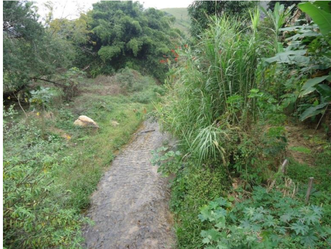
Figura 35 - Visão de jusante da ponte 2
