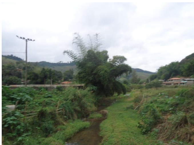
Figura 32 - Visão de montante da Ponte 1
