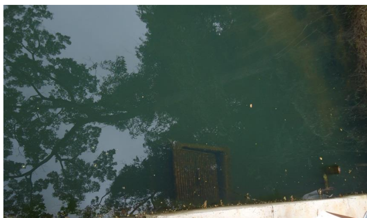
Figura 17 - Grade para retenção de sólidos grosseiros
