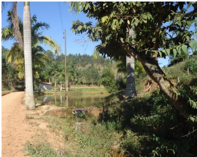
Figura 37 – Barragem na entrada do distrito
