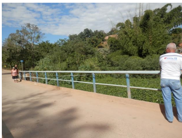
Figura 30 – Visão lateral da ponte 1
