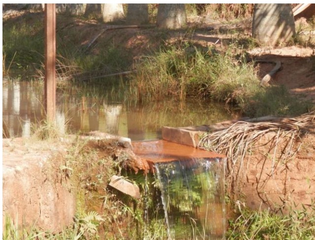
Figura 38 – Vertedor da barragem
