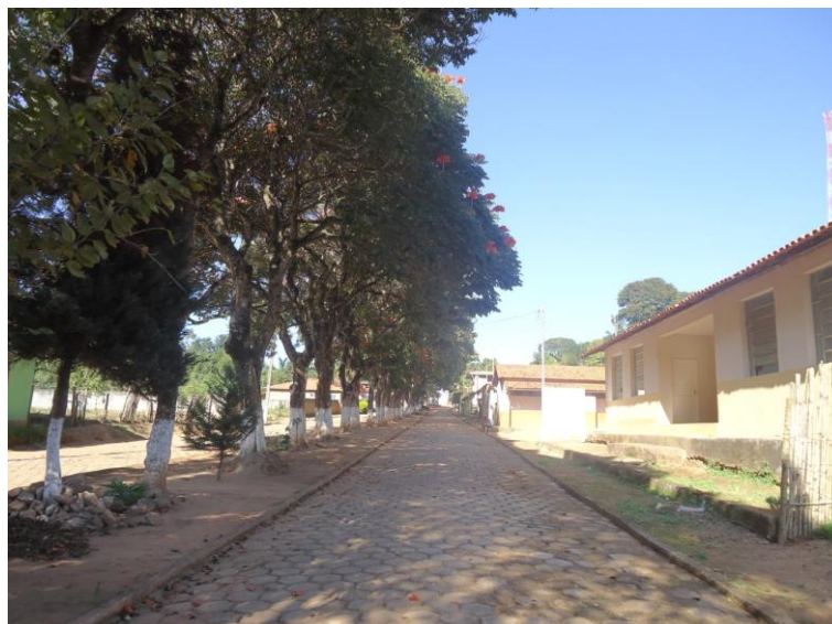
Figura 36 – Pavimentação do distrito de Padre Felisberto
