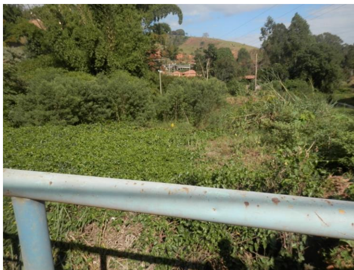
Figura 31 – Ponte inacabada em ruínas ao lado da ponte estudada
