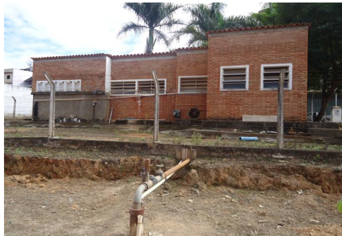
Figura 16 – Poço de captação localizado próximo à ETA
