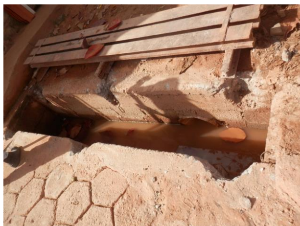
Figura 41 – Rede de drenagem durante manutenção
