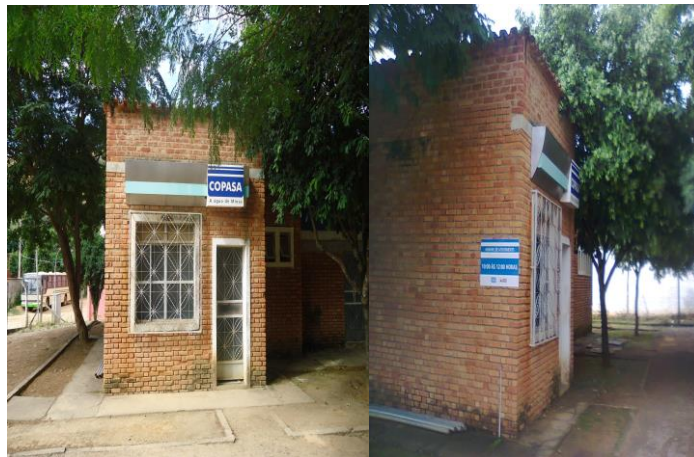
Figura 15 – Estação de Tratamento de Água (Sede)
