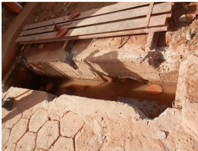
Figura 20 – Manutenção em interceptor de esgotos
