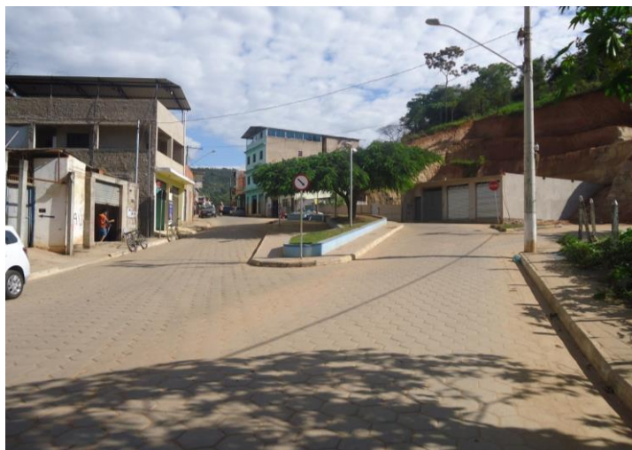
Figura 26 – Pavimentação de bloquete sextavado
