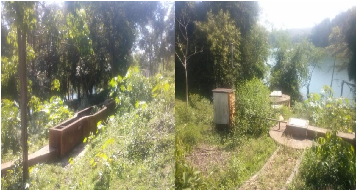
Figura 21 – ETE desativada na localidade de Miguel Rodrigues
