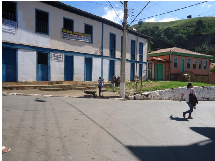
Figura 24 – Pavimentação de asfalto na área mais central
