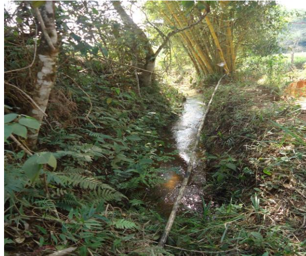
Figura 16 – Canal livre para adução de água
