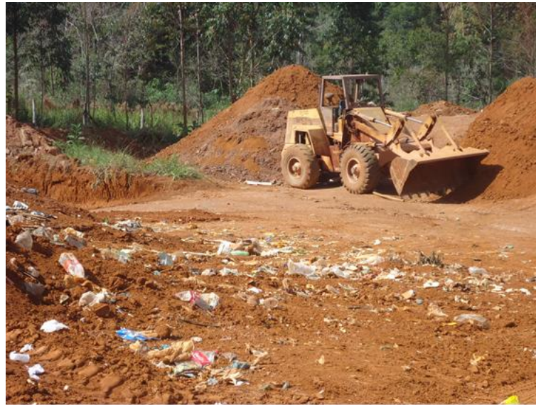
Figura 31 – Vala de disposição de resíduos sólidos
