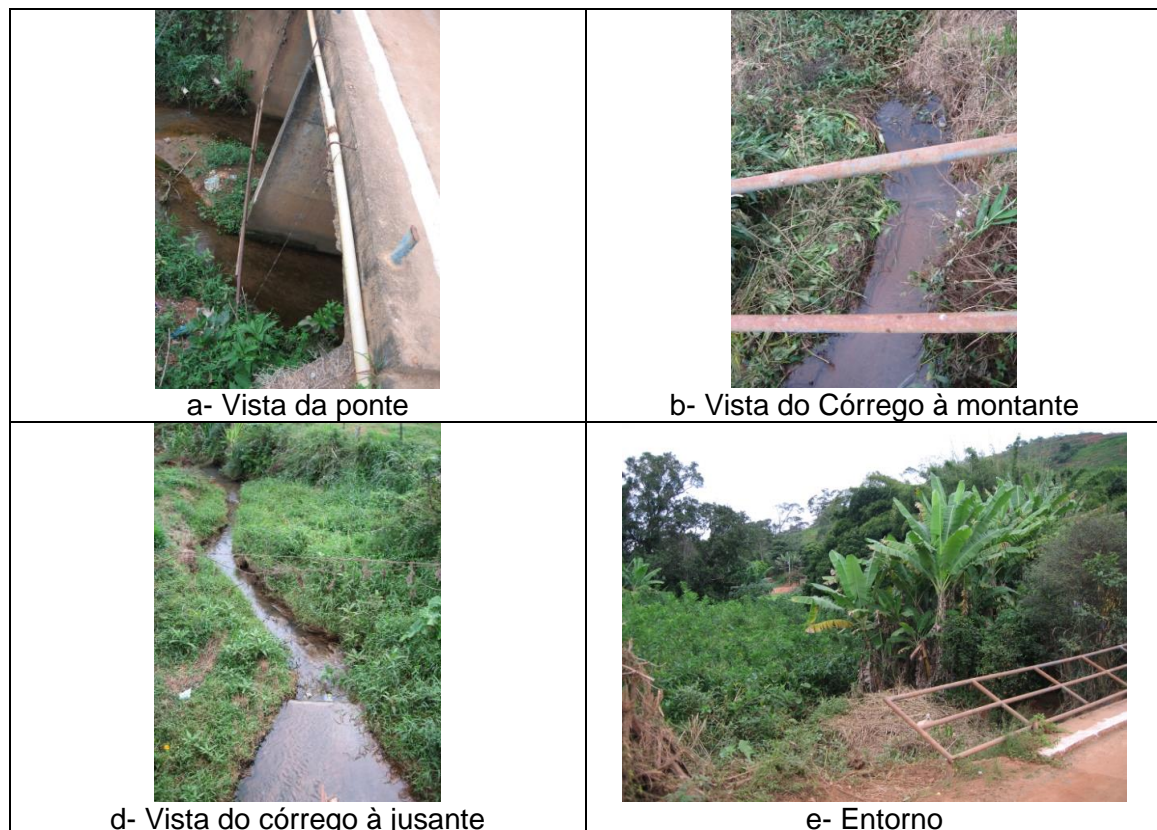
Figura 57 - Vista da oitava ponte amostrada (2º ponte do distrito de Zito Soares)
