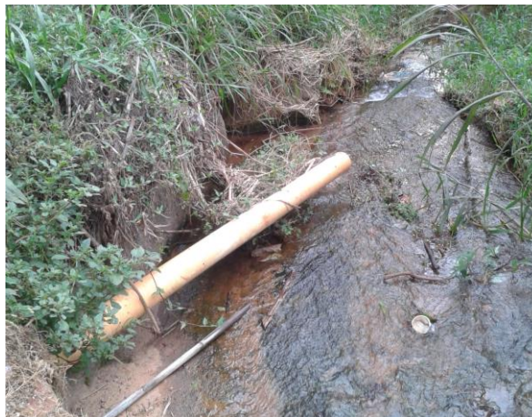
Figura 37 - Lançamento de esgotos 01
