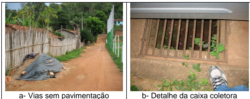
Figura 66 - Bocas coletoras do distrito de Zito Soares
