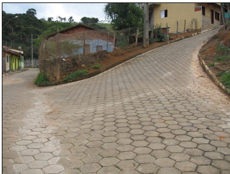
Figura 58 - Detalhe pavimentação de bloquete sextavado
