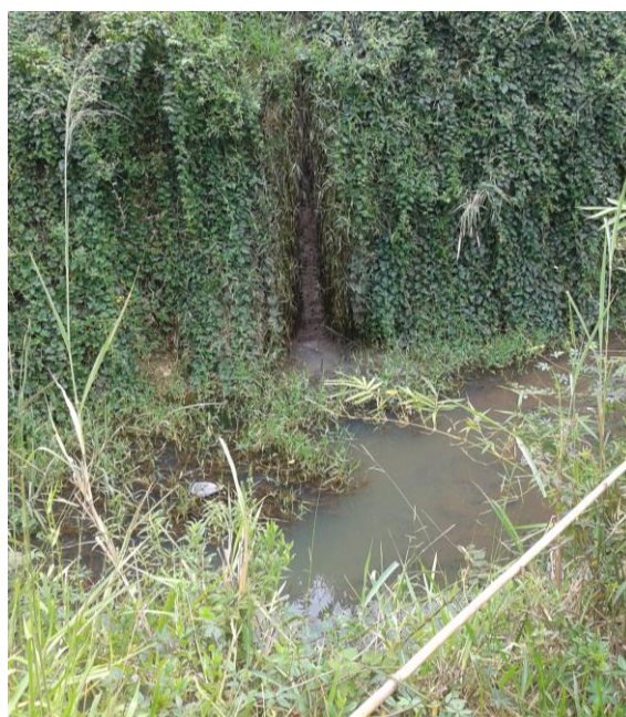
Figura 34 - Lançamento de esgotos 05
