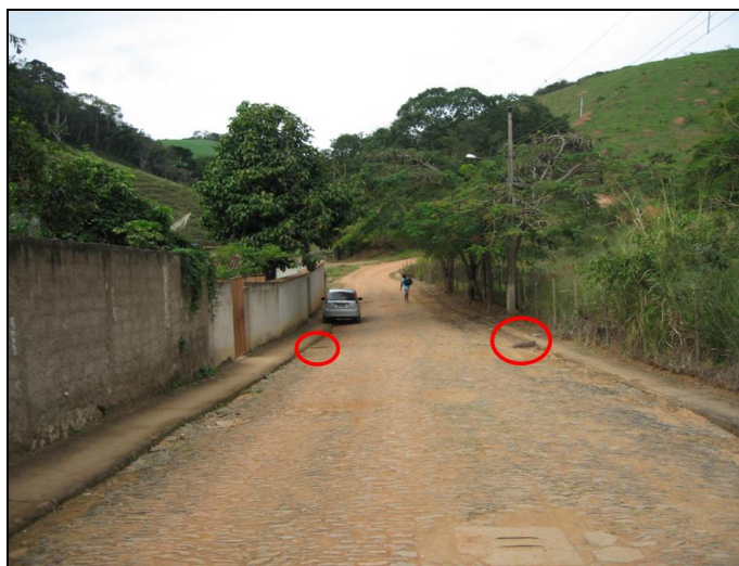
Figura 68 - Detalhe da microdrenagem do povoado de São José da Vargem Alegre
