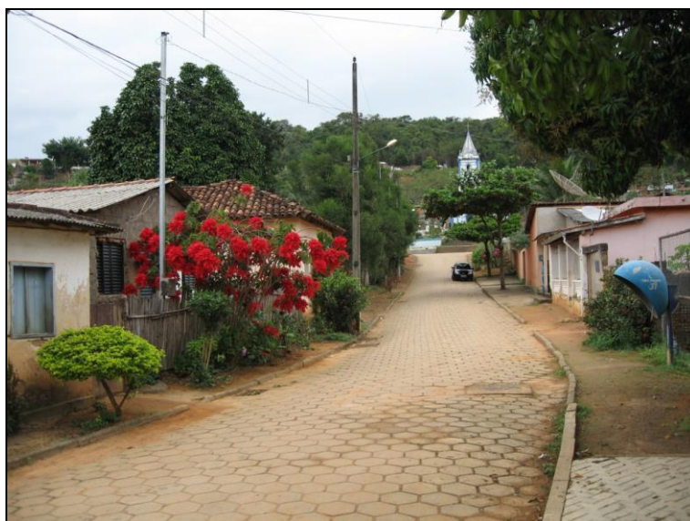
Figura 62 - Pavimentação de bloquete sextavado – São José da Vargem Alegre
