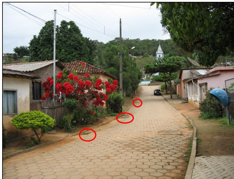
Figura 69 - Detalhe da microdrenagem do povoado de São José da Vargem Alegre
