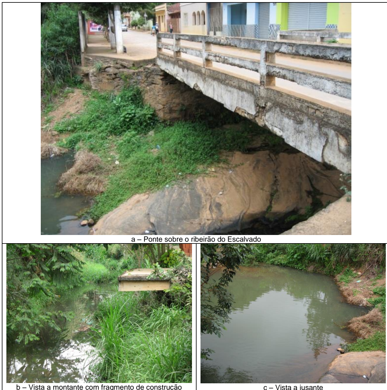
Figura 53 - Detalhe da ponte 4 sobre o ribeirão do Escalvado
