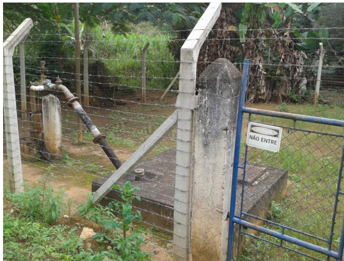
Figura 15 - Detalhamento da captação subterrânea de água da sede
