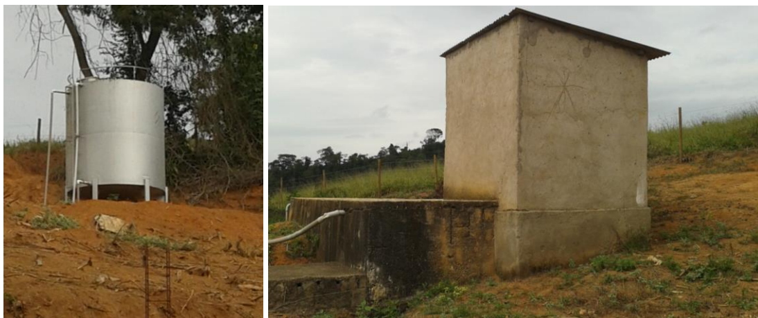
Figura 28 - Reservatórios de água de São José de Vargem Alegre
