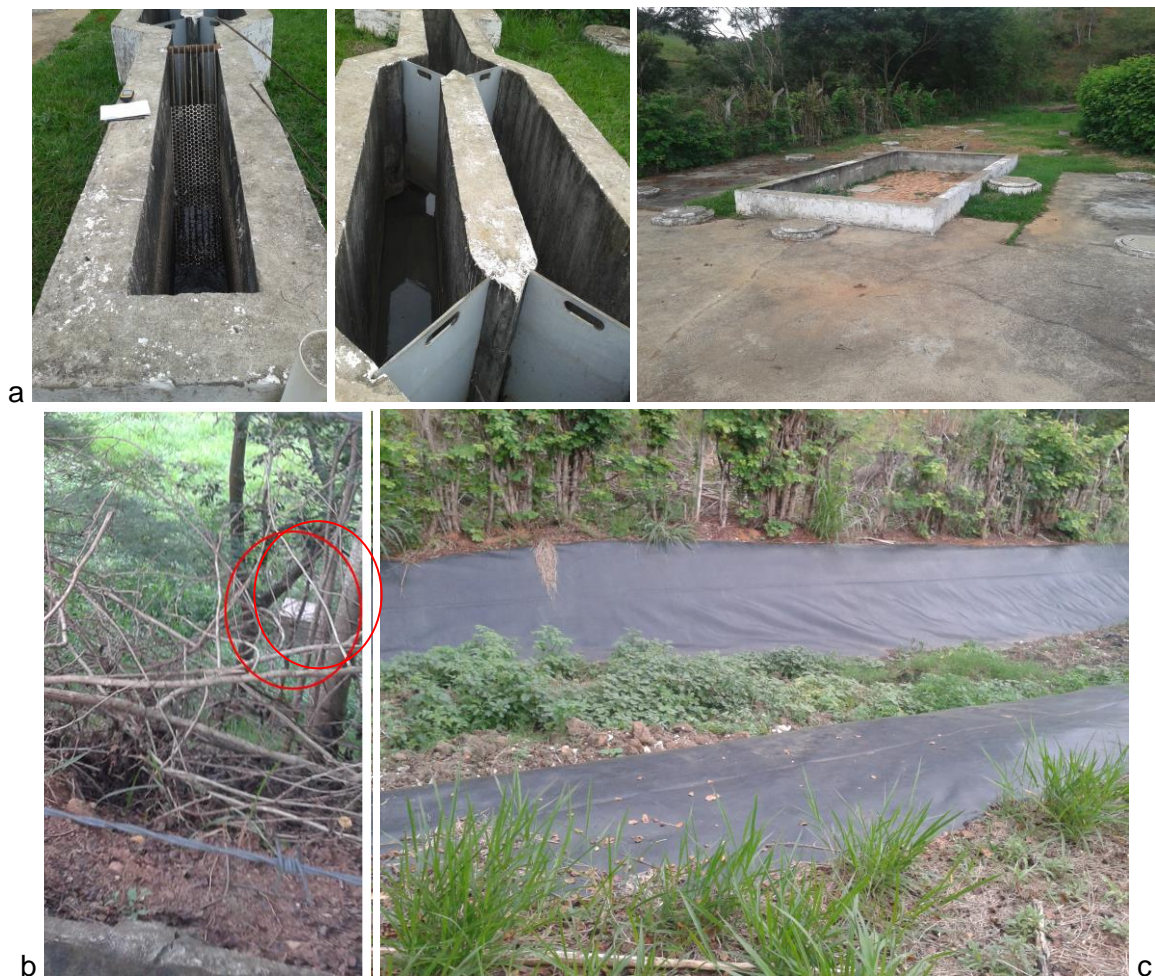
Figura 36 - Estação de Tratamento de Esgoto de São Sebastião do Soberbo
