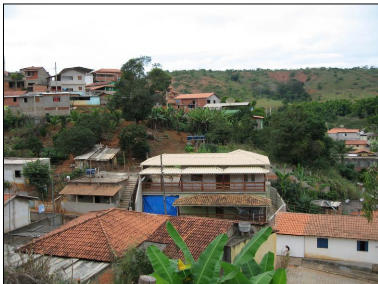
Figura 74 - Área de encosta ocupada
