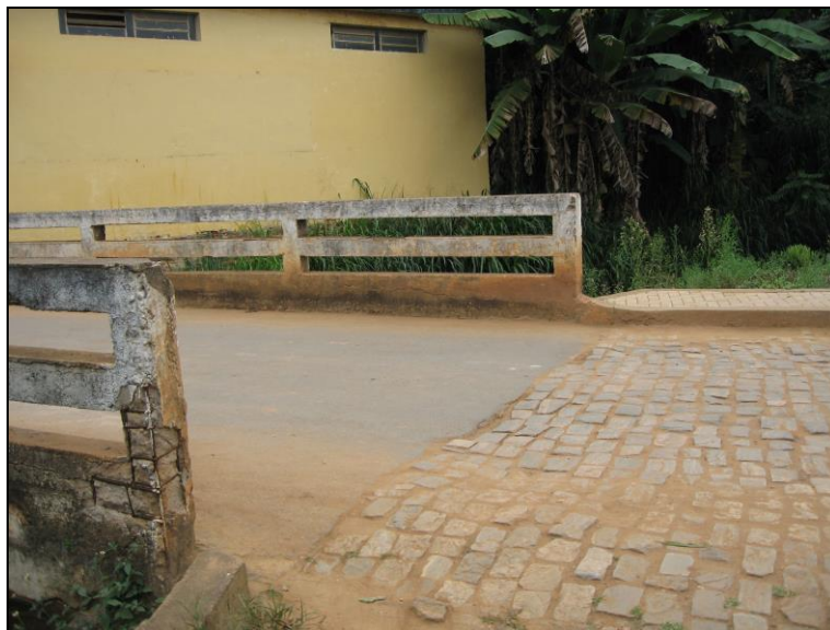
Figura 59 - Detalhe pavimentação de paralelepípedo e asfalto
