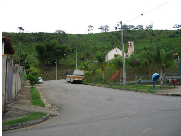
Figura 60 - Pavimentação – São Sebastião do Soberbo
