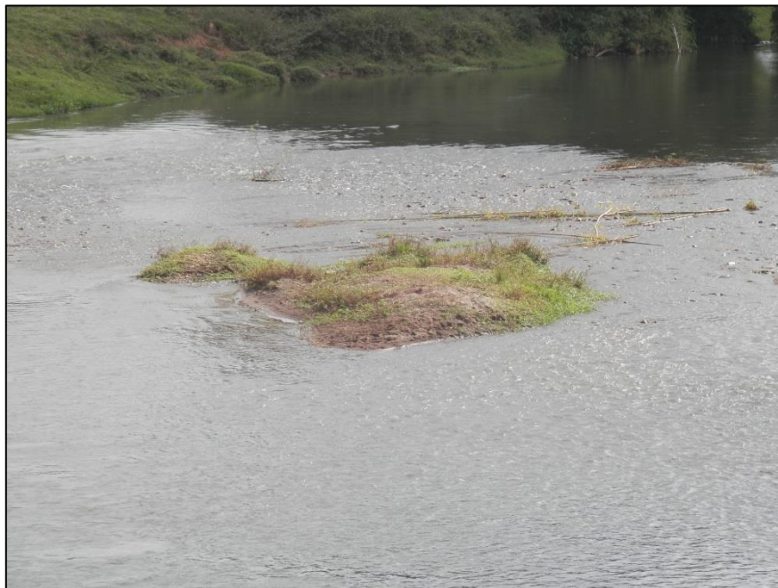
Figura 30 - Assoreamento no rio do Carmo na sede de Acaiaca
