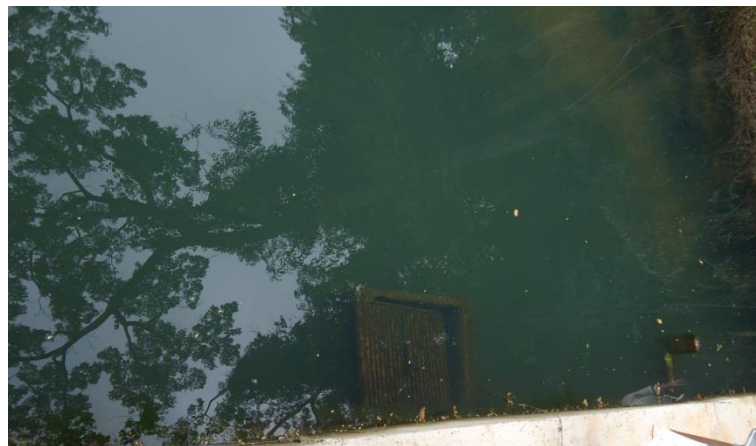
Figura 2 - Grade para retenção de sólidos grosseiros
