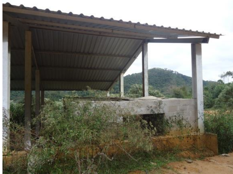
Figura 33 - Usina de Triagem e Compostagem de resíduos sólidos
