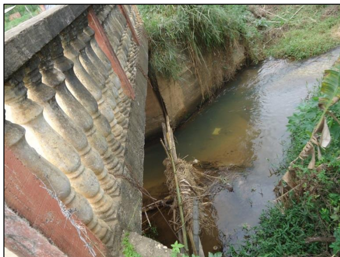
Figura 21 - Ponte 1 sobre o ribeirão Ubá
