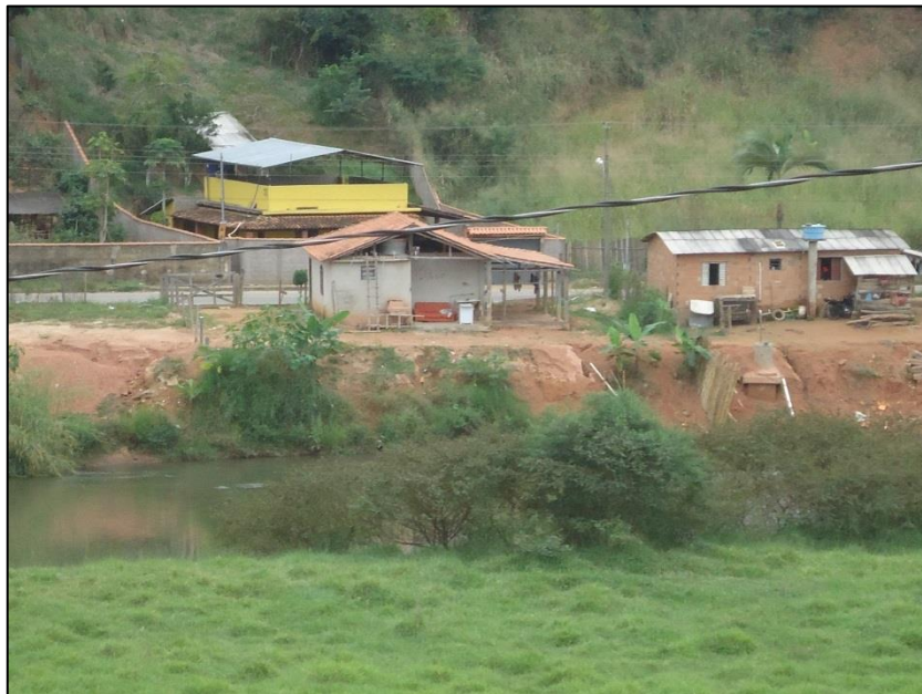
Figura 29 - Erosão das margens do rio do Carmo em Acaiaca
