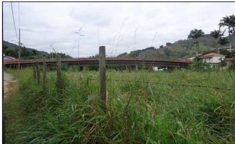
Figura 16 - Ponte sobre o rio do Carmo
