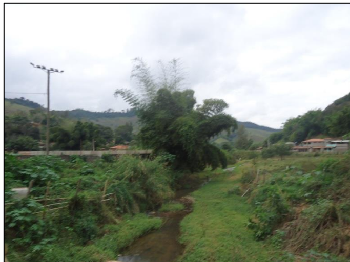
Figura 22 - Visão de montante da Ponte 1
