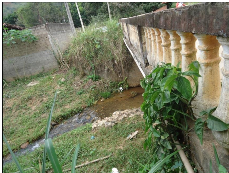
Figura 23 - Segunda ponte do ribeirão Ubá
