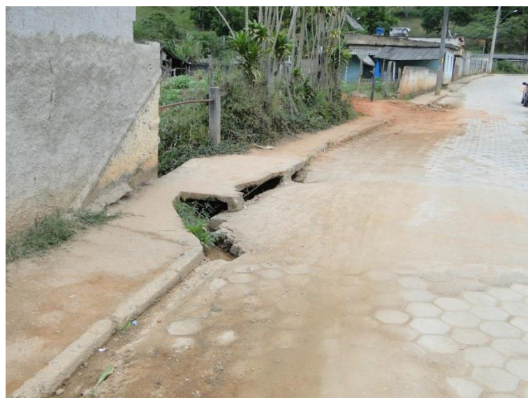
Figura 49 - Rua pavimentada com bloquete sextavado e boca de lobo
