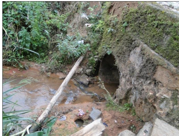
Figura 56 - Ponte sobre o córrego afluente do córrego dos Pintos - tubulação de passagem vista de jusante para montante
