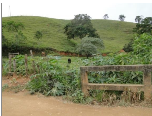
Figura 43 - Ponte sobre o córrego afluente do ribeirão Conceição (margem esquerda do curso d'água a jusante da ponte)
