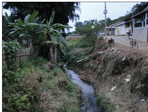
Figura 69 - Ponte sobre córrego afluente do rio Brejaúba - vista de jusante para montante
