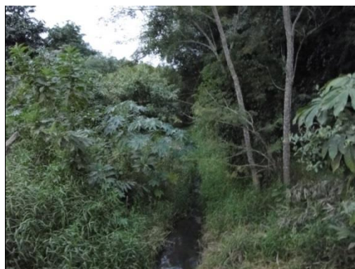
Figura 70 - Ponte sobre córrego afluente do rio Brejaúba - vista de montante para jusante
