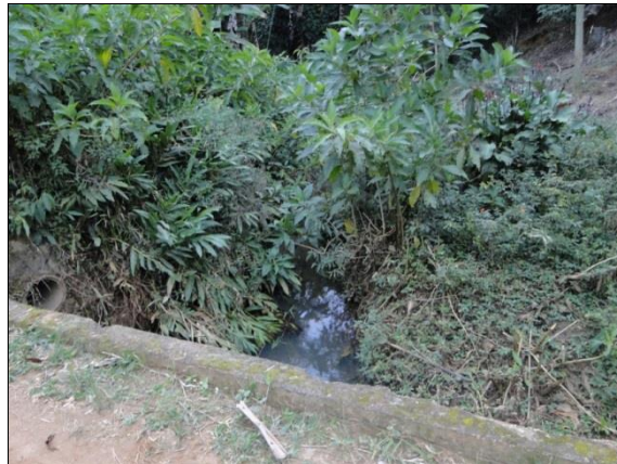
Figura 82 - Ponte sobre o córrego da Vaca - vista de jusante para montante
