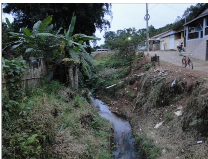
Figura 28 - Lançamento de esgotos in natura - Vitorinos (córrego afluente do rio Brejaúba)
