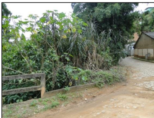
Figura 42 - Ponte sobre o córrego afluente do ribeirão Conceição (margem esquerda do curso d'água a montante da ponte)
