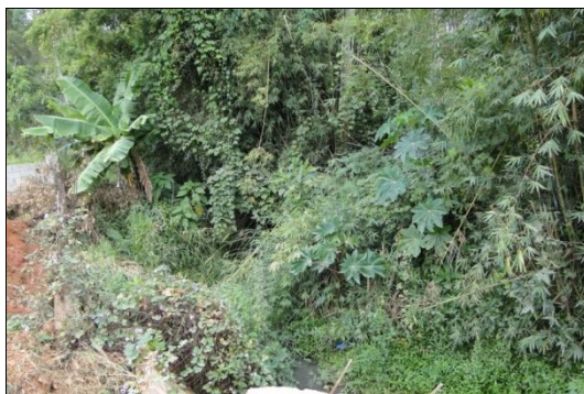
Figura 41 - Ponte sobre córrego afluente do ribeirão Conceição - vista a jusante
