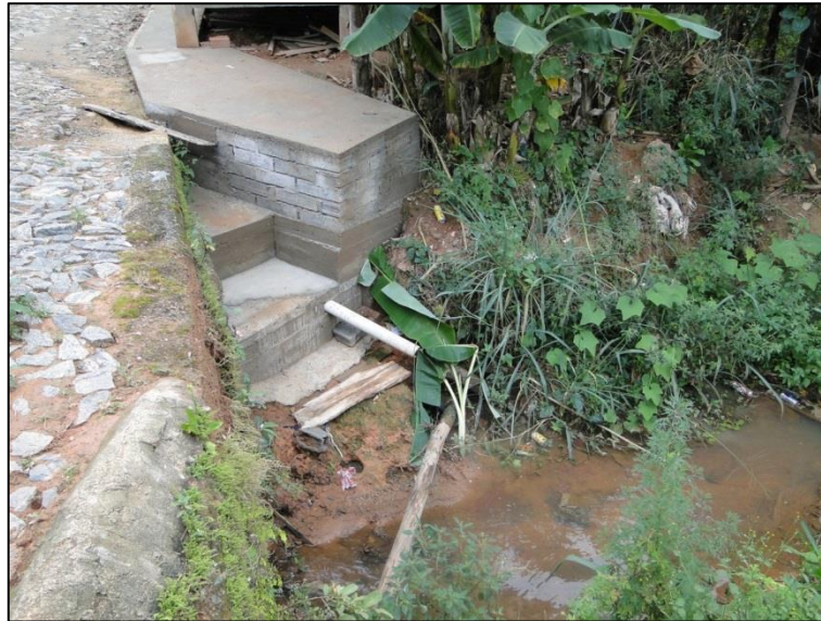
Figura 59 - Ponte sobre o córrego afluente do córrego dos Pintos - escada para escoamento das águas pluviais
