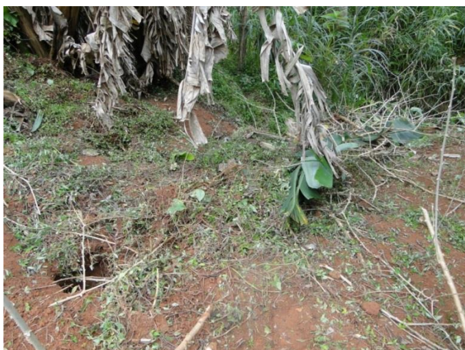
Figura 24 - Lançamento de esgotos a céu aberto
