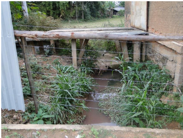
Figura 61 - Ponte sobre o córrego afluente do córrego dos Pintos - vista de montante para jusante
