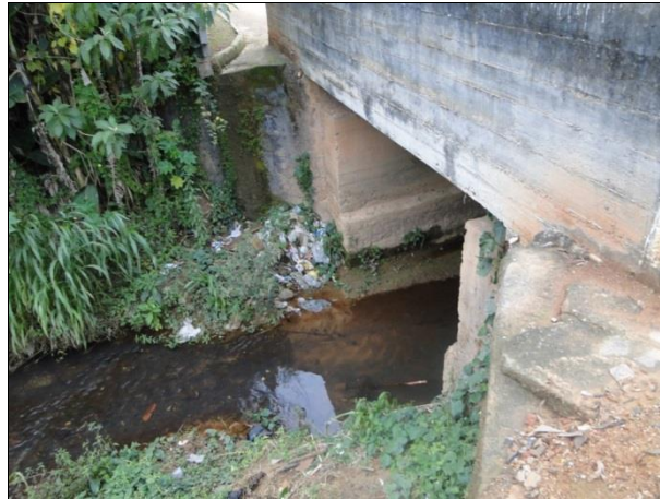
Figura 63 - Ponte sobre córrego dos Pintos
