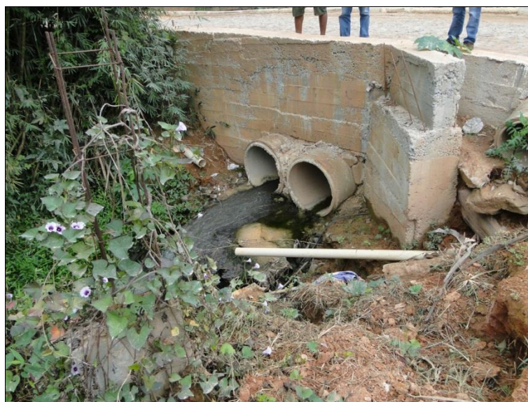
Figura 39 - Ponte sobre córrego afluente do ribeirão Conceição - perfil
