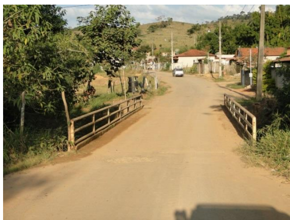
Figura 74 - Ponte sobre o rio Brejaúba - vista de montante para jusante
