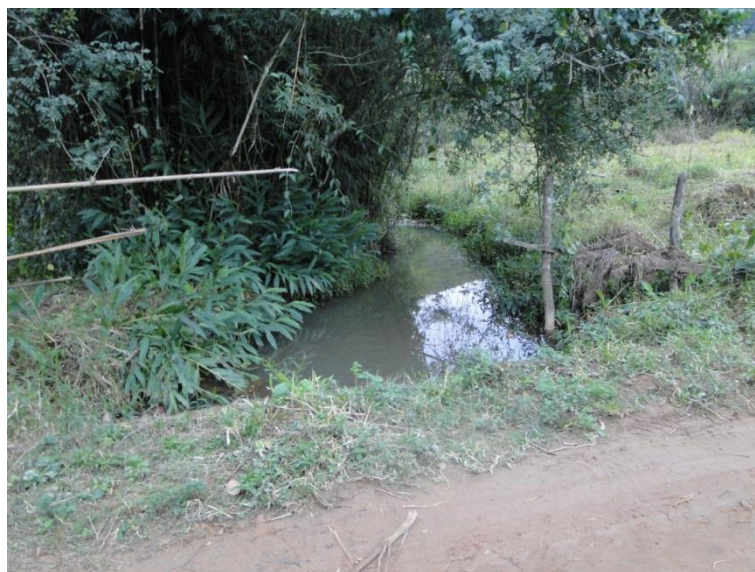
Figura 80 - Ponte sobre córrego afluente do córrego da Vaca - vista de montante para jusante para montante
