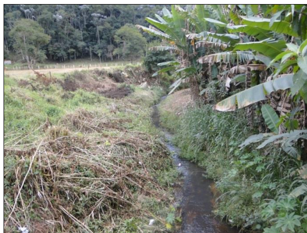
Figura 65 - Ponte sobre córrego dos Pintos - vista de montante para jusante
