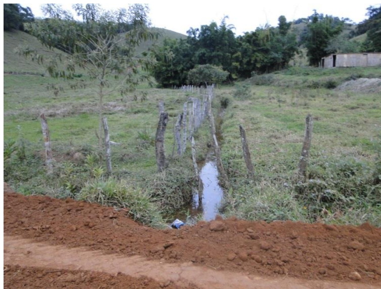
Figura 77 - Ponte sobre córrego afluente do córrego da Vaca - vista de montante para jusante
