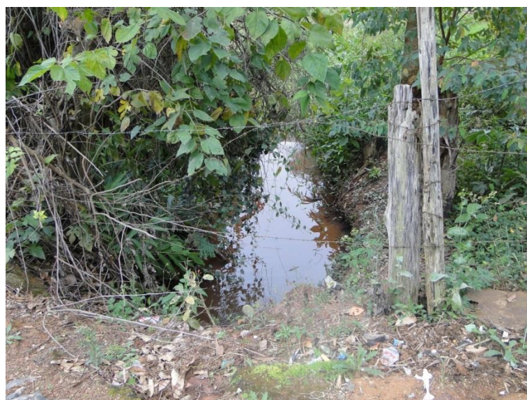
Figura 55 - Ponte sobre o córrego afluente do córrego dos Pintos - vista a montante da ponte
