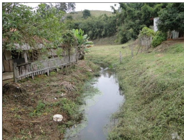
Figura 53 - Ponte sobre o córrego dos Pintos - vista a montante da ponte
