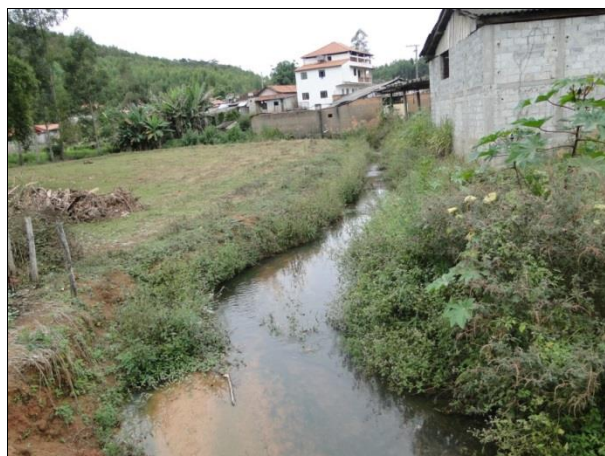
Figura 52 - Ponte sobre o córrego dos Pintos - vista a jusante da ponte
