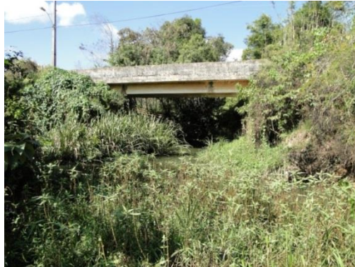
Figura 71 - Ponte sobre o rio Brejaúba
