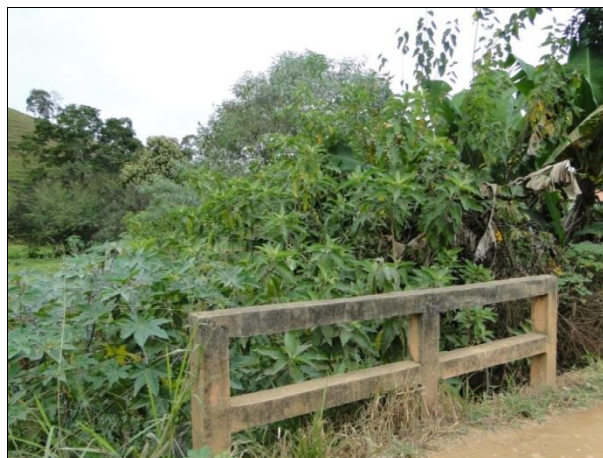
Figura 44 - Ponte sobre o córrego afluente do ribeirão Conceição (vista a jusante)
