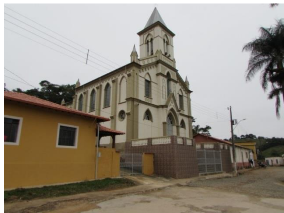
Figura 83 - pavimentação de asfalto e de pedras
