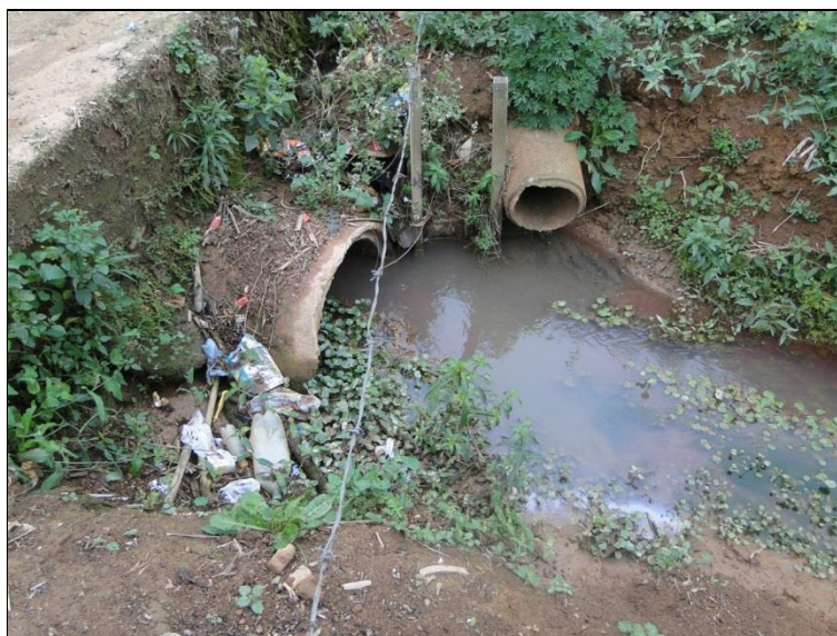
Figura 62 - Ponte sobre o córrego afluente do córrego dos Pintos - tubulação para lançamento de águas pluviais
