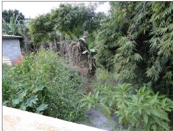
Figura 64 - Ponte sobre córrego dos Pintos - vista de jusante para montante
