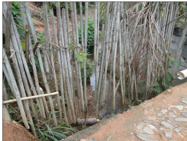
Figura 57 - Ponte sobre o córrego afluente do córrego dos Pintos - vista de jusante para montante
