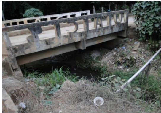
Figura 68 - Ponte sobre córrego afluente do rio Brejaúba
