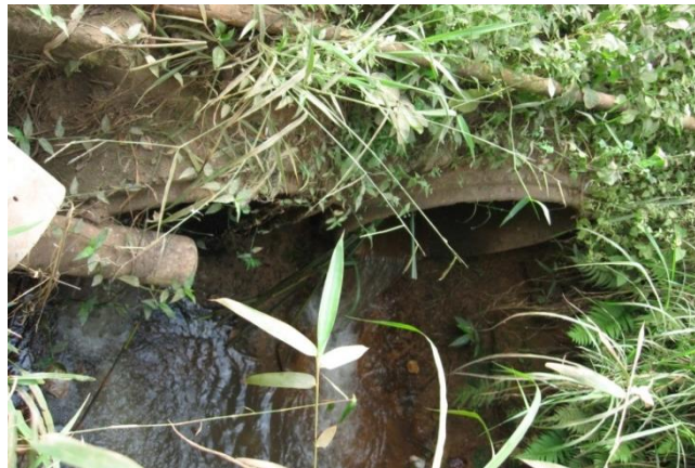
Figura 45 - Lançamento de esgotos 04
