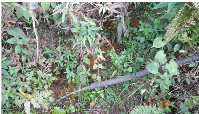
Figura 20 - Chegada da água aduzida da Captação 02 até o canal desviado
