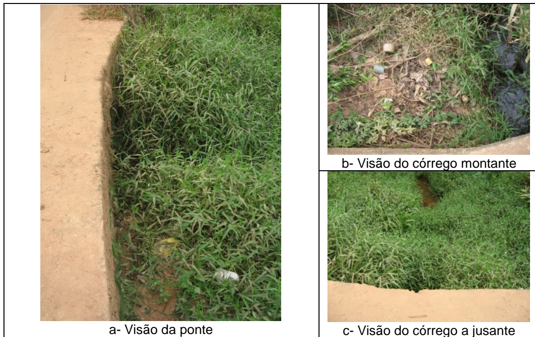
Figura 89 - Primeira ponte visitada em Dias
