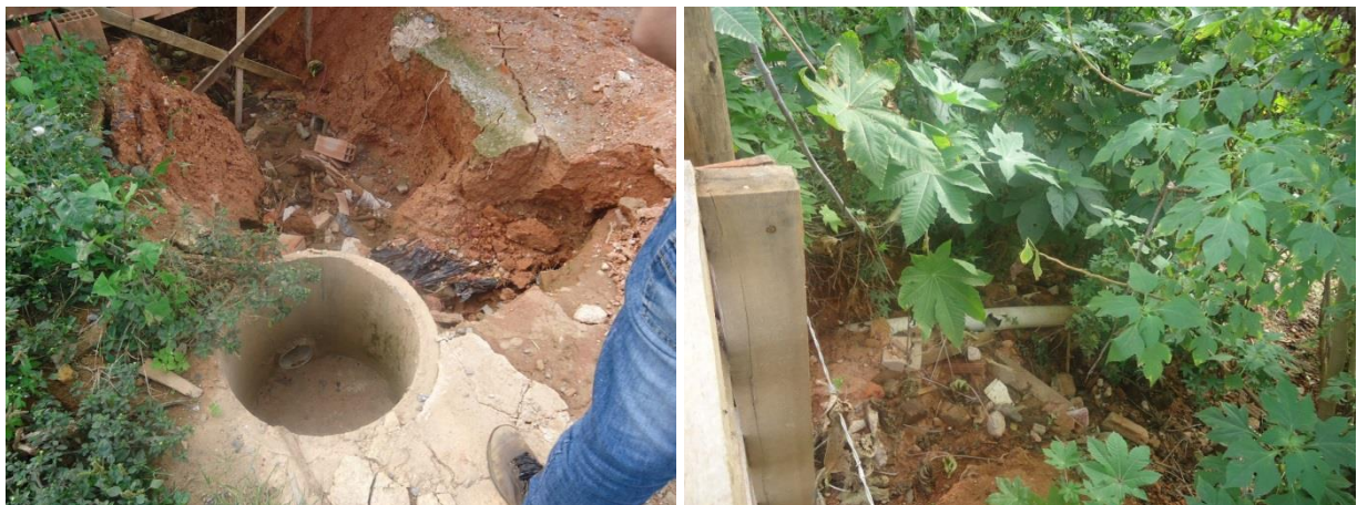
Figura 43 - Lançamento de esgotos 02
