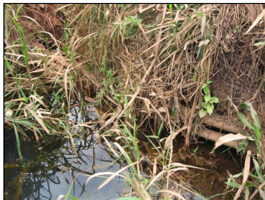
Figura 90 - Detalhe da segunda ponte amostrada
