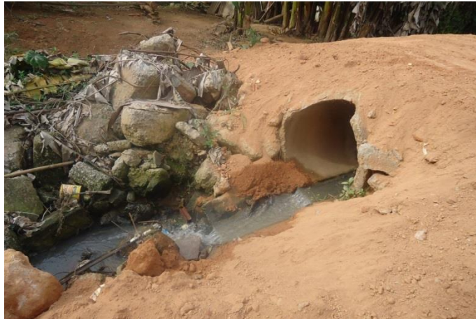
Figura 44 - Lançamento de esgotos 03
