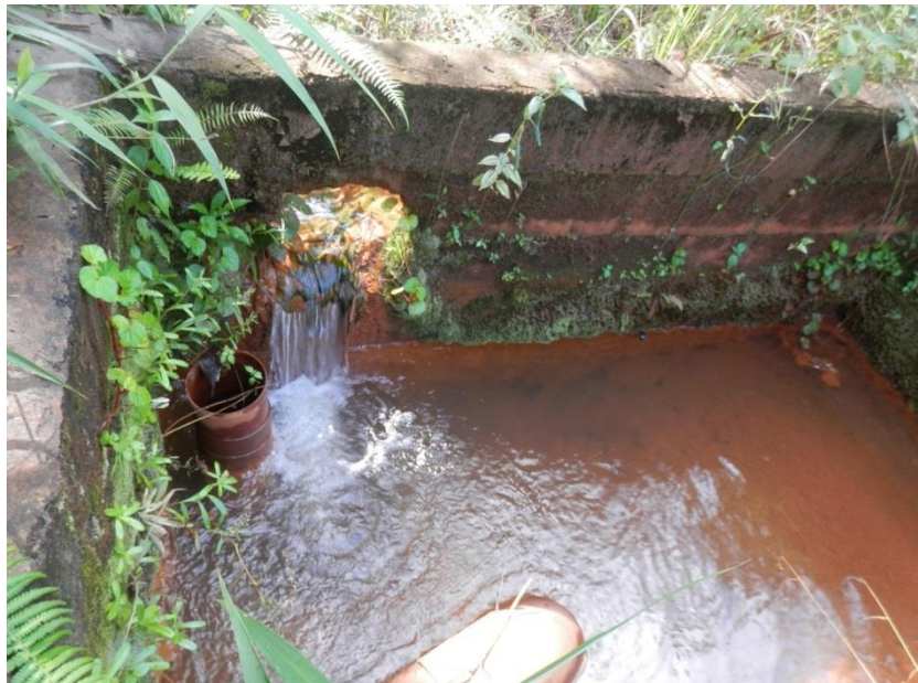
Figura 15 - Caixa de concreto utilizada para captação de Barretos de Alvinópolis
