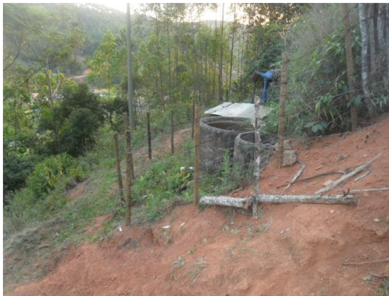
Figura 30 - Reservatório menor de água da captação superficial de Terras
