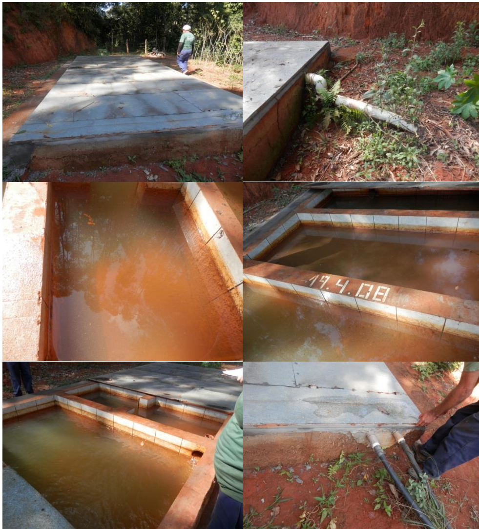
Figura 16 - Detalhes da caixa de areia
