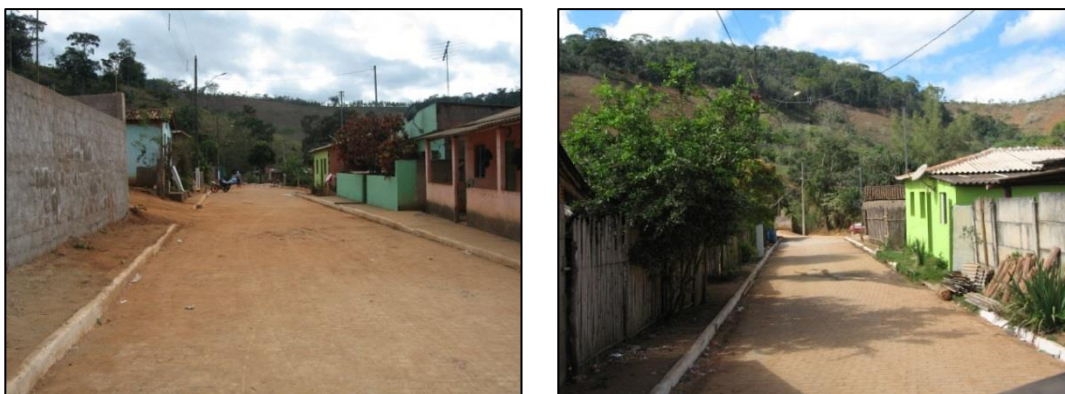
Figura 71 - Aspectos das vias da comunidade de Gravatá
