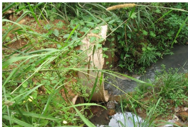
Figura 46 - Lançamento de esgotos 05
