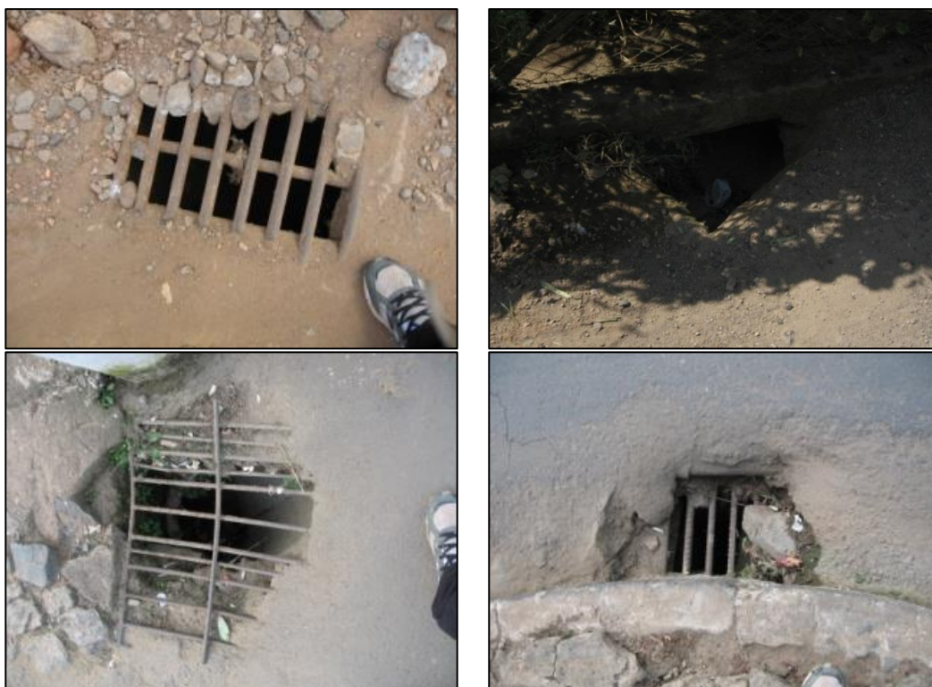
Figura 61 - Aspectos das bocas de lobo
