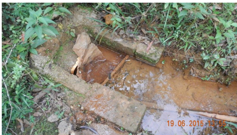
Figura 21 - Captação de água de Fonseca - córrego Togó (Captação 03)
