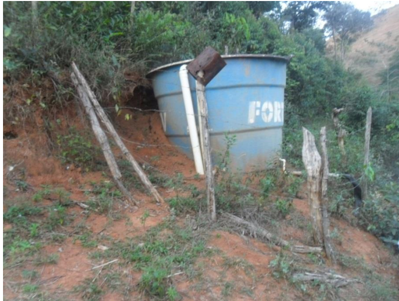
Figura 31 - Reservatório principal de água da captação superficial de Terras
