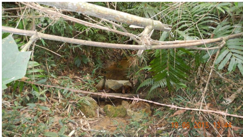
Figura 19 - Captação de água de Fonseca - córrego Togó (Captação 02)
