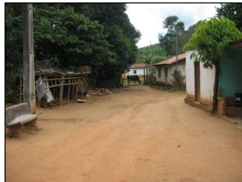
b- Via não pavimentada
