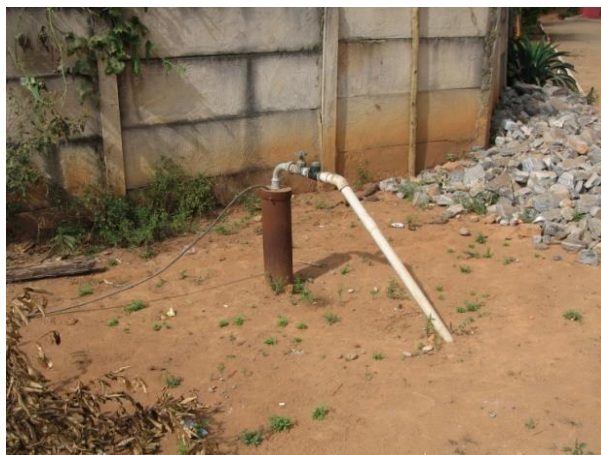
Figura 27 - Captação subterrânea de Gravatá
