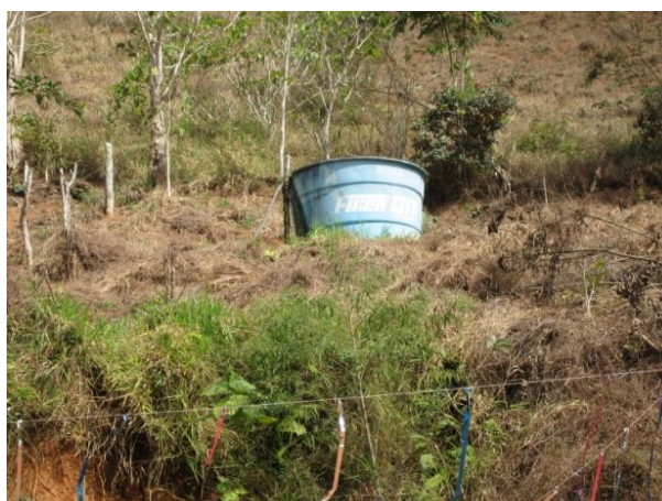
Figura 28 - Reservatório de água da captação subterrânea de Gravatá
