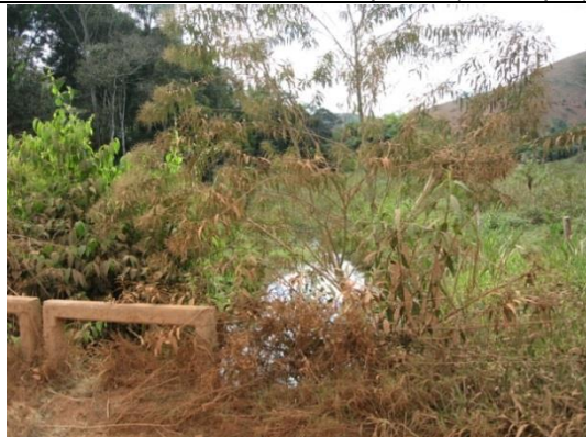
b- Vista da ponte e córrego
