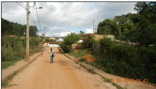
b- Via sem pavimentação
