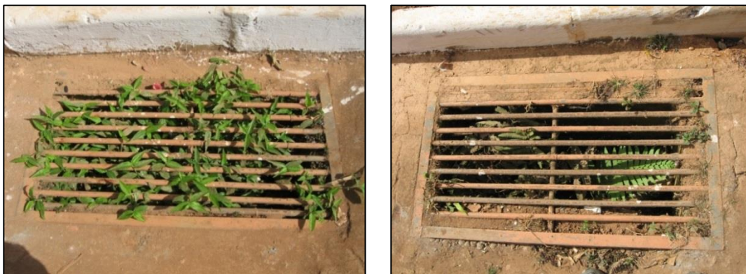
Figura 70 - Aspectos da microdrenagem de Gravatá
