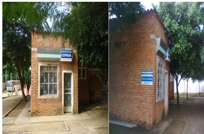
Figura 1 - Estação de Tratamento de Água (Sede)
