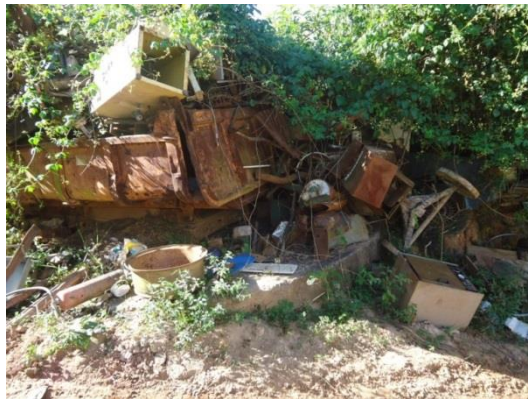
Figura 13 - Local da ETE inoperante (Sede)
