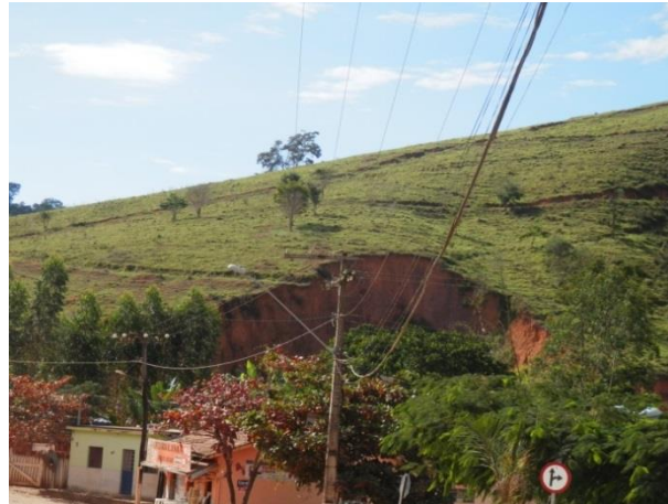
Figura 38 - Erosão em morro de Amparo do Serra
