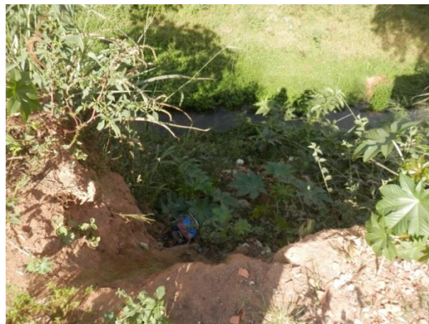
Figura 39 - Margem do ribeirão em processo de erosão
