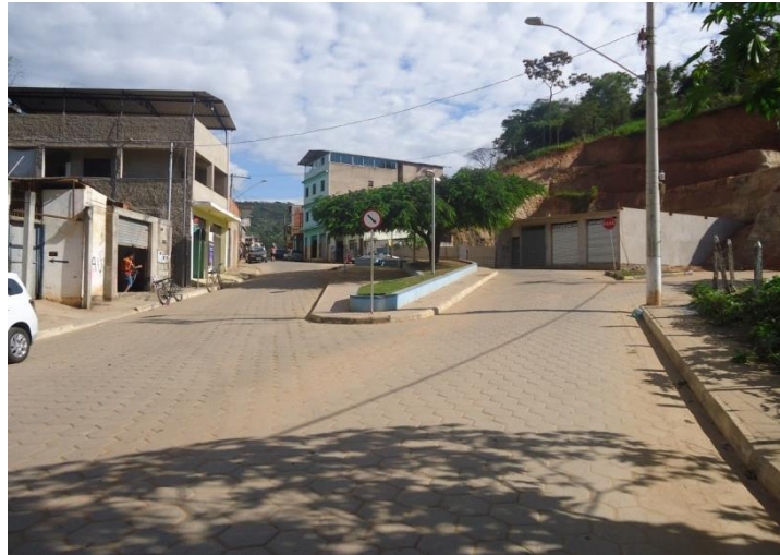
Figura 19 - Pavimentação de bloquete sextavado
