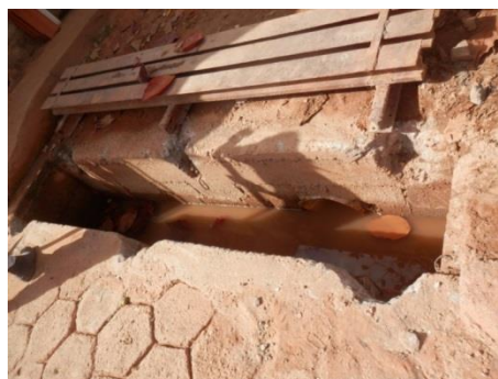
Figura 12 - Manutenção em interceptor de esgotos
