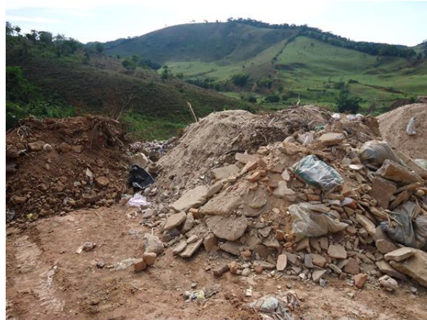
Figura 44 - Entulho disposto no lixão
