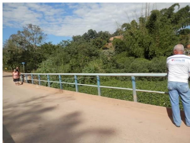
Figura 23 - Visão lateral da ponte 1
