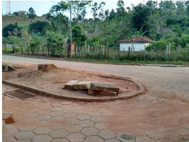
Figura 35 - Bocas de lobo do distrito
