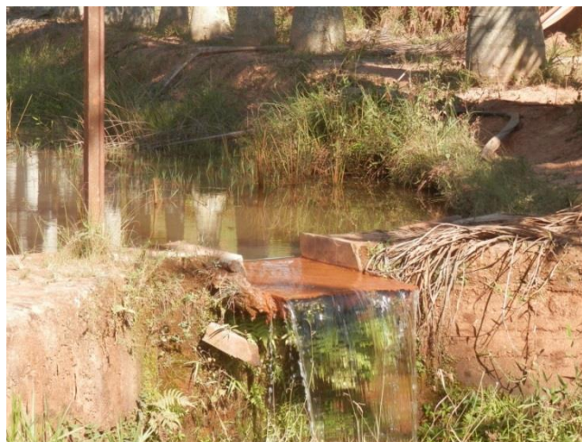
Figura 31 - Vertedor da barragem
