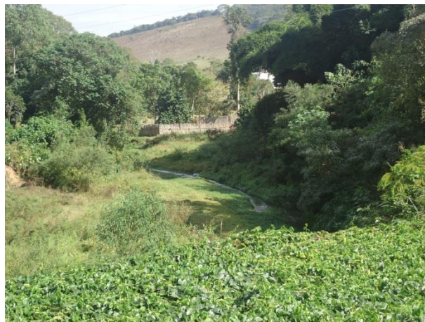
Figura 22 - Visão de montante da ponte 1
