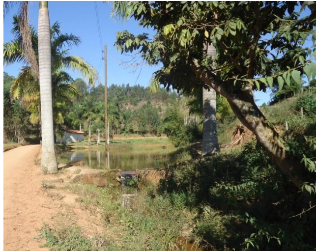
Figura 30 - Barragem na entrada do distrito
