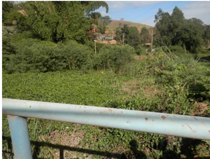
Figura 24 - Ponte inacabada em ruínas ao lado da ponte estudada
