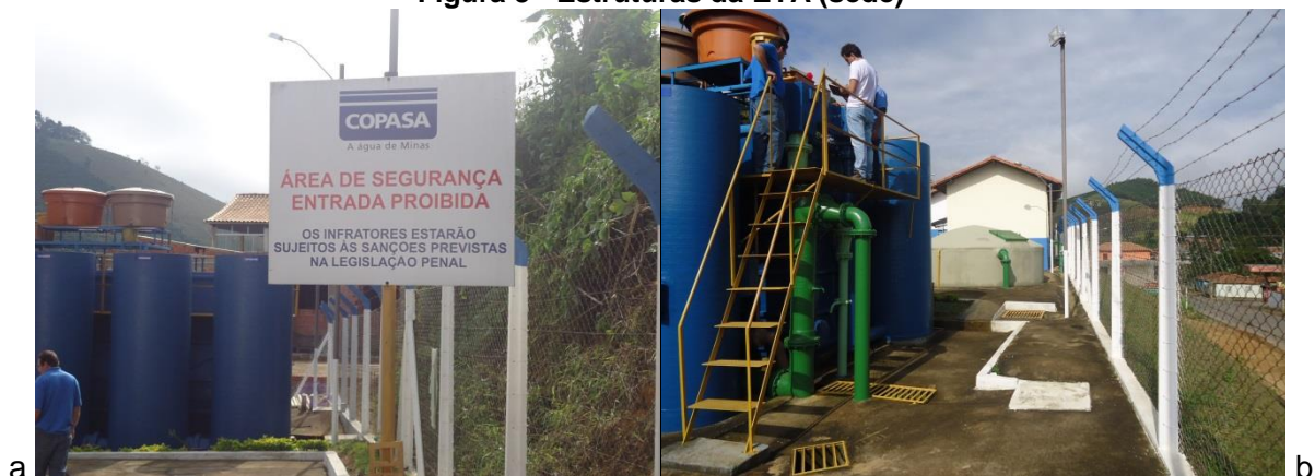
Figura 3 - Estruturas da ETA (sede)
