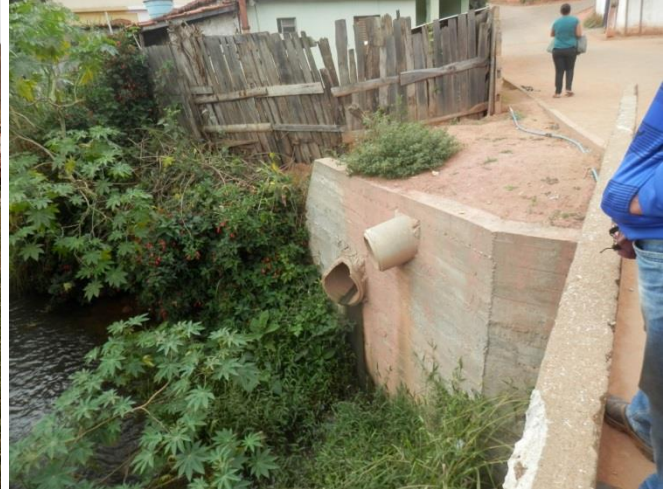
Figura 38 - Visão de jusante da ponte
