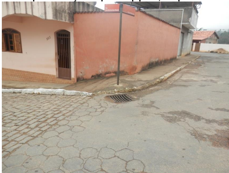
Figura 35 - Detalhe pavimentação de paralelepípedo, bloquete sextavado e asfalto.
