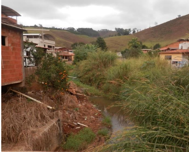
Figura 37 - Visão de montante da ponte
