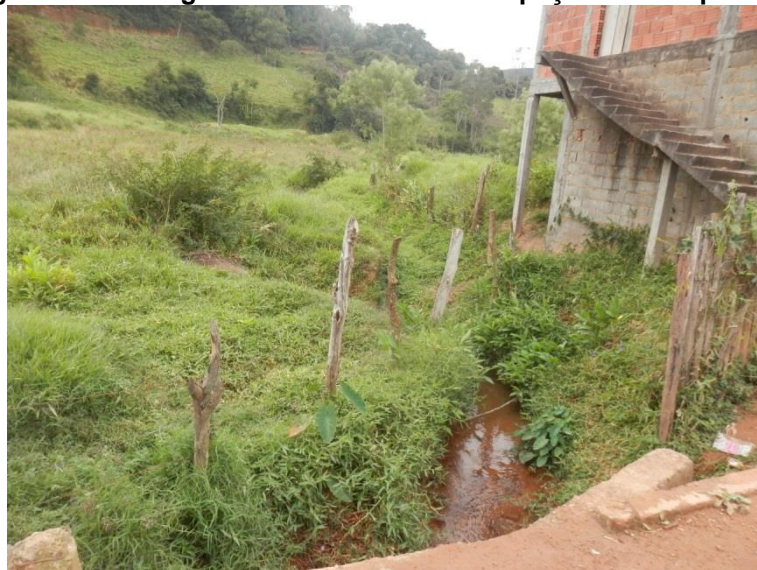
Figura 48 - Córrego Santo Antônio com ocupação urbana próxima
