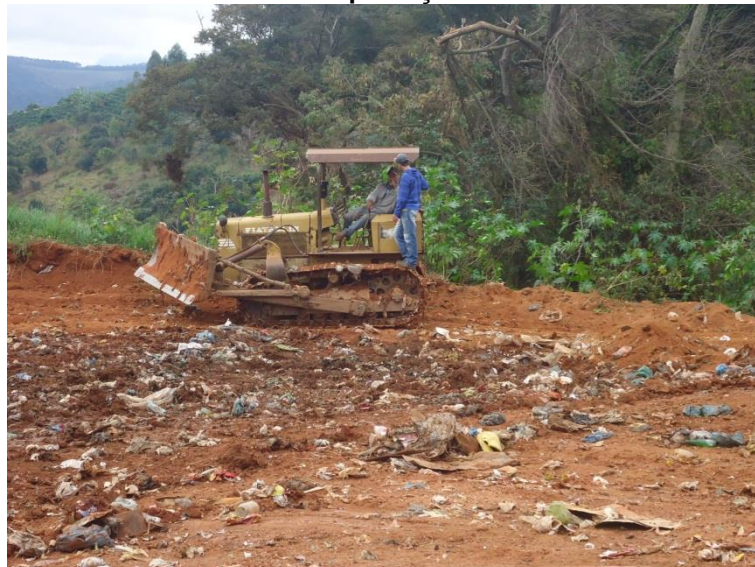
Figura 63 - Trator de esteira realizando a compactação de resíduos sólidos na vala ativa do lixão
