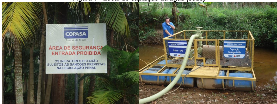
Figura 1 - Local de captação da água (sede)
