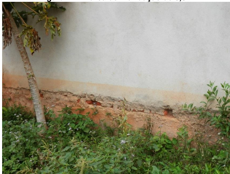
Figura 41 - Marca de inundação de 0,8m.
