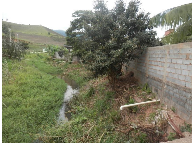
Figura 46 - Lançamento de esgotos diretamente no corpo d'água
