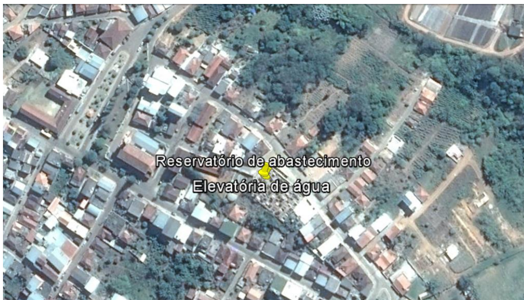
Figura 6 - Vista panorâmica do local da estação elevatório da água e o reservatório de abastecimento da sede do município de Araponga
