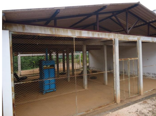
Figura 59 - Galpão para armazenamento de material triado e enfardado da UTC de Araponga
