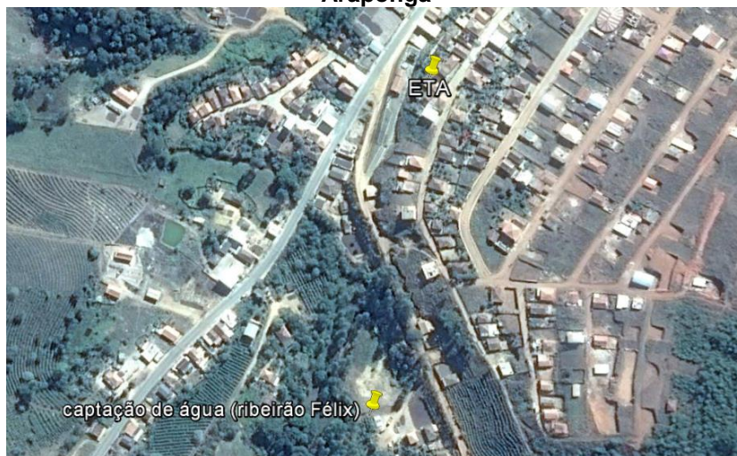
Figura 2 - Vista panorâmica do local do ponto de captação e da ETA da sede do município de Araponga
