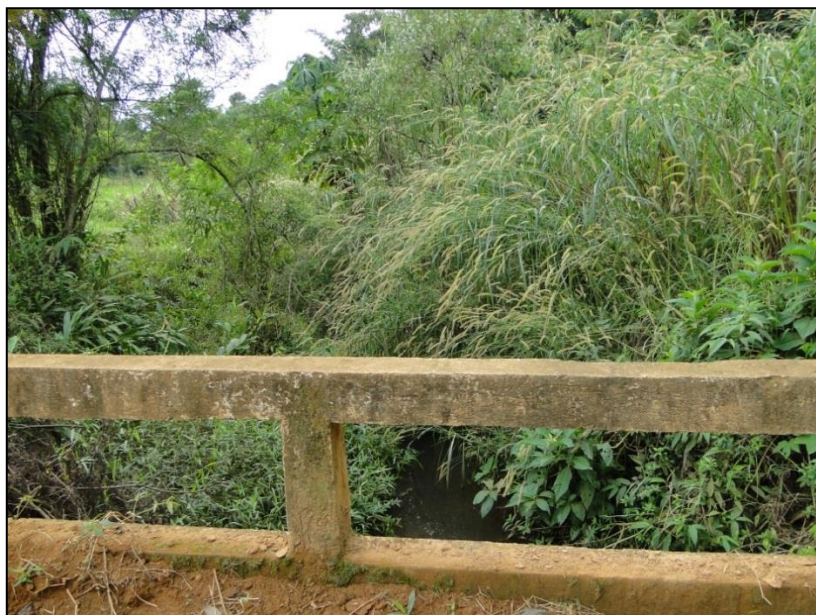
Figura 23 - Visão a montante da Ponte 3, sobre o ribeirão Pedroso
