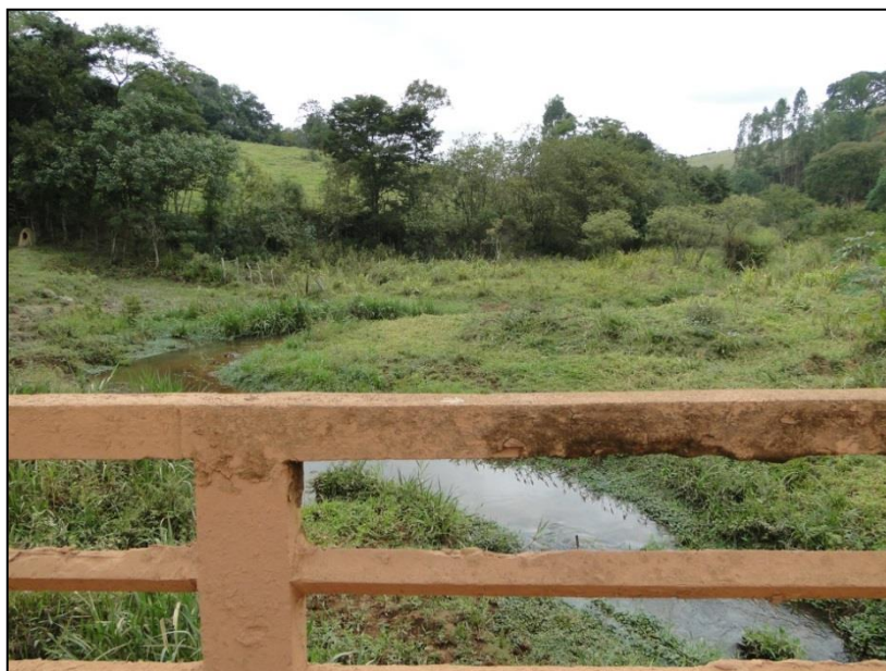
Figura 21 - Visão a montante da Ponte 2, sobre o ribeirão Pedroso
