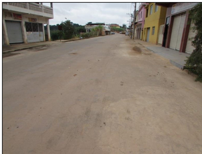
Figura 32 - Via revestida com asfalto
