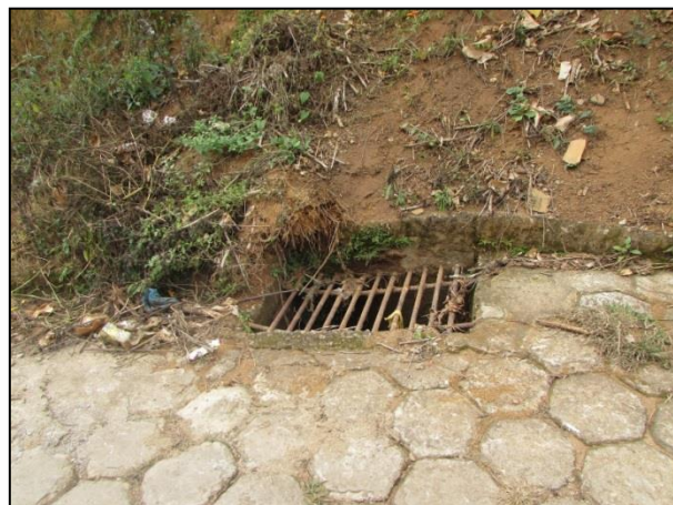
Figura 36 - Detalhe da rede de drenagem
