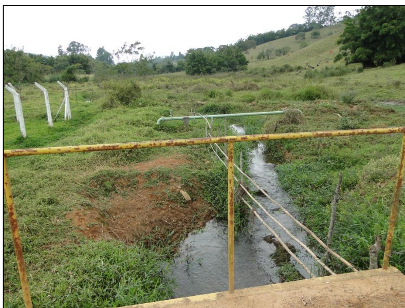
Figura 19 - Visão a montante da Ponte 1, sobre o ribeirão Pedroso
