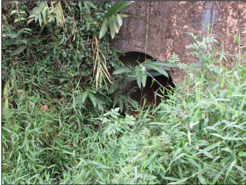
Figura 30 - Ponte 7, sobre o córrego Caiçara
