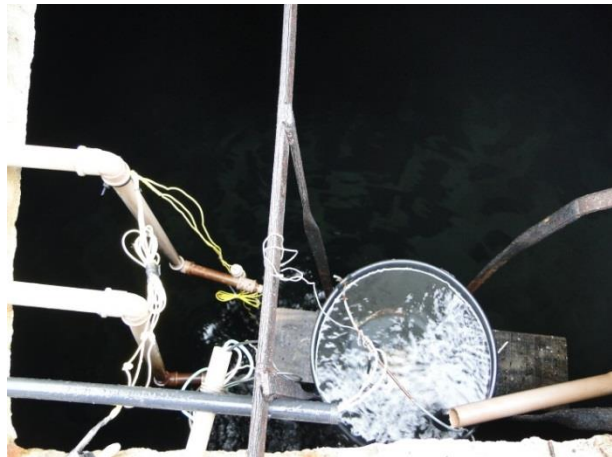
Sistema para controle da dosagem de cloro e flúor
