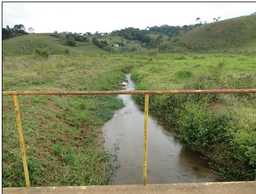
Figura 20 - Visão a jusante da Ponte 1, sobre o ribeirão Pedroso
