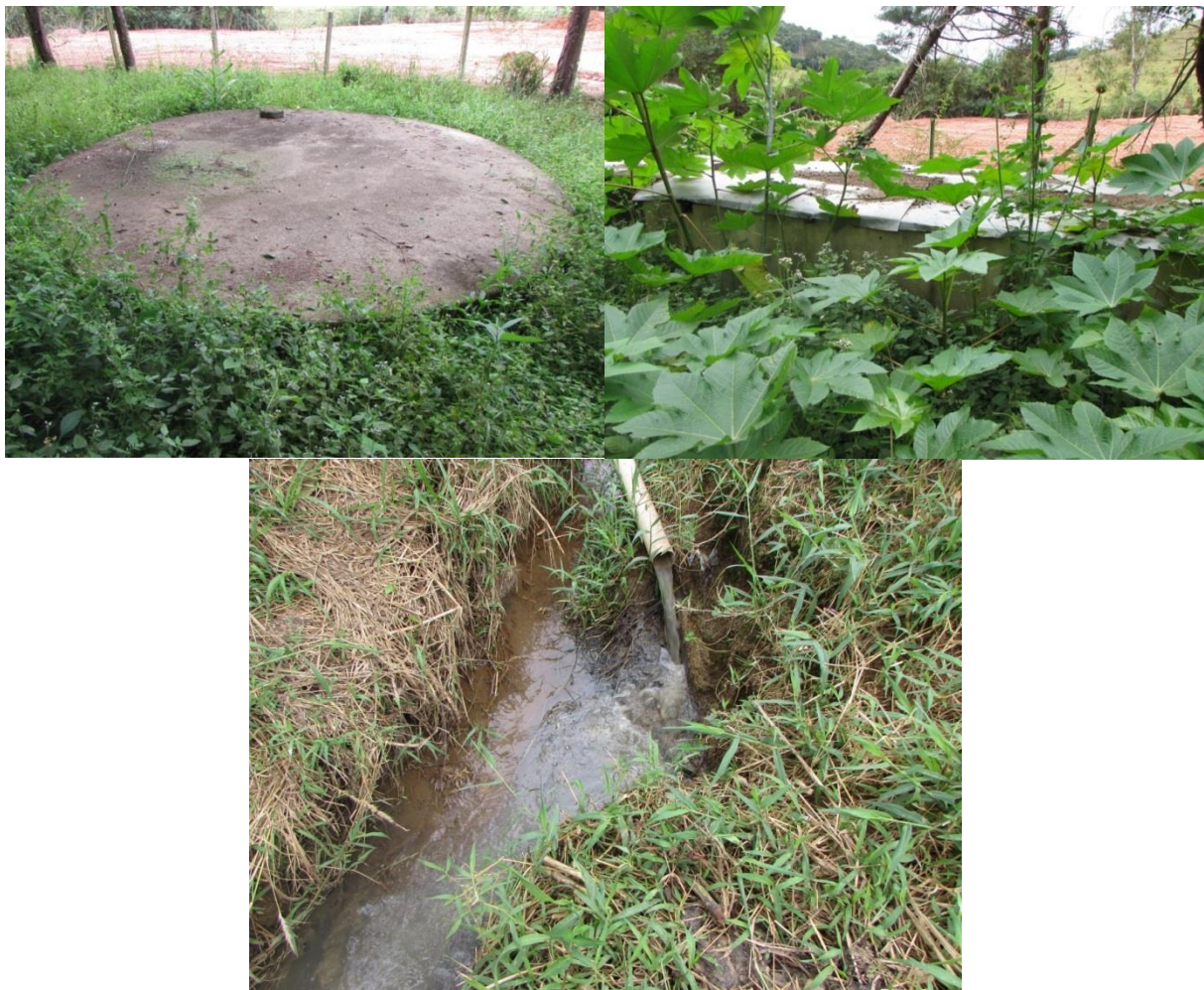
Figura 14 - Estação de Tratamento de Esgoto desativada de Capela Nova
