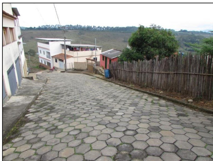
Figura 33 - Via revestida com bloquete sextavado
