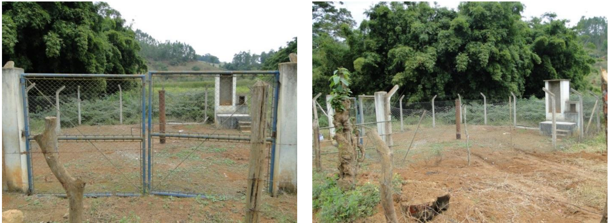
Figura 4 - Captação subterrânea - Poço C01
