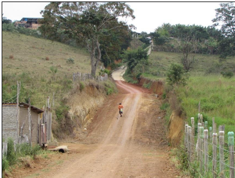
Figura 34 - Via sem pavimentação
