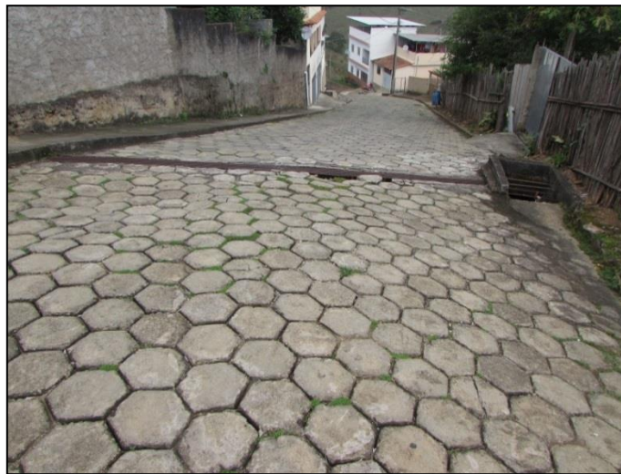
Figura 37 - Detalhe da rede de drenagem
