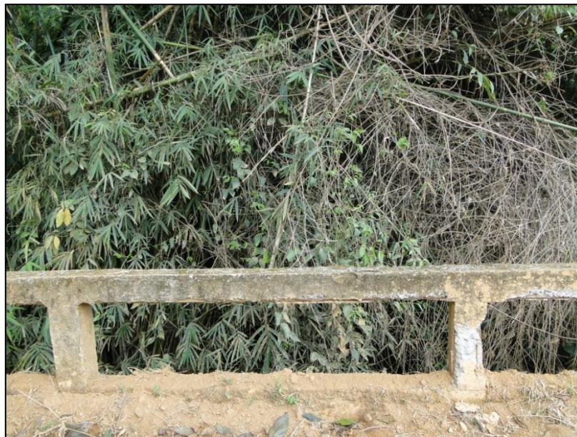
Figura 24 - Visão a jusante da Ponte 3, sobre o ribeirão Pedroso
