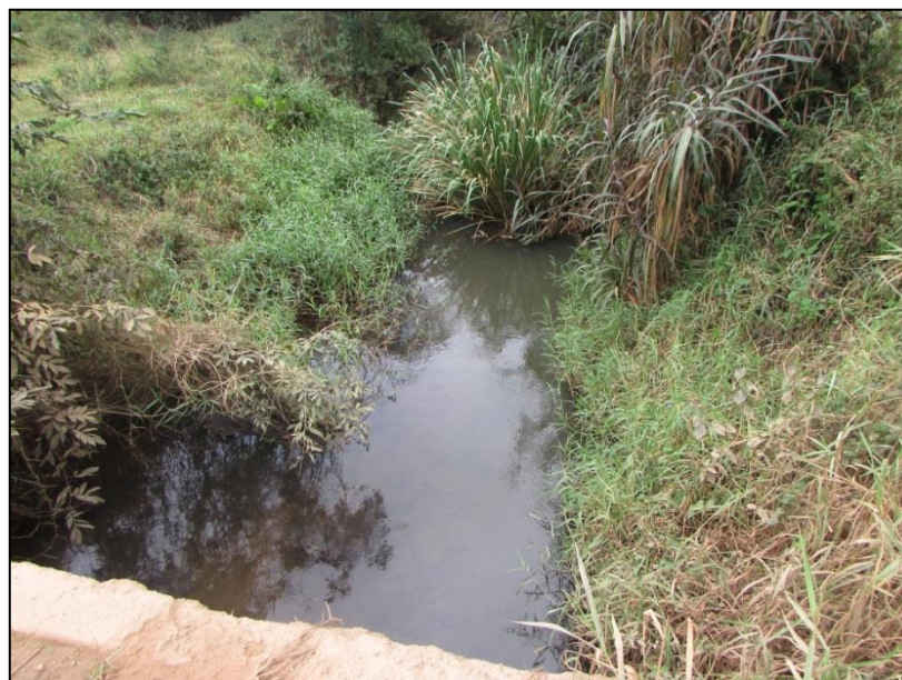
Figura 27 - Visão a montante da Ponte 5, sobre o córrego das Lobas
