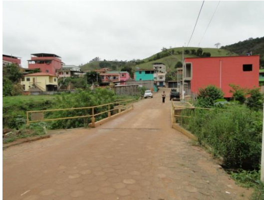
Figura 28 - Pavimentação com bloquete sextavado na rua 13 de Maio
