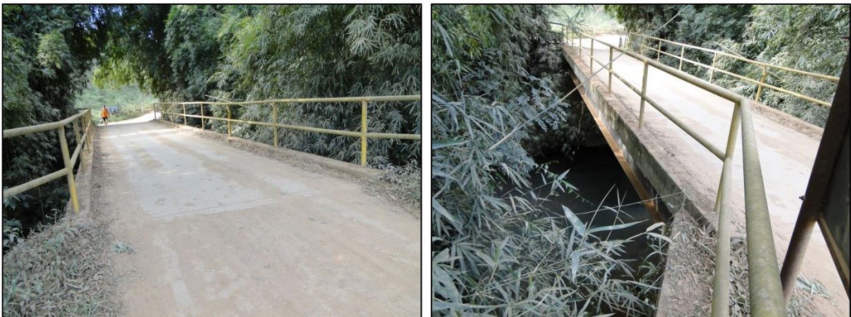
Figura 24 - Ponte da Barra sobre o rio Brejaúba
