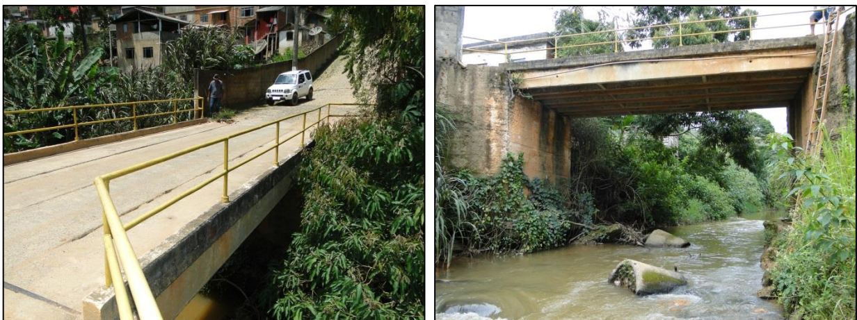
Figura 22 - Ponte sobre o rio Espera na travessa Cap. Gomes
