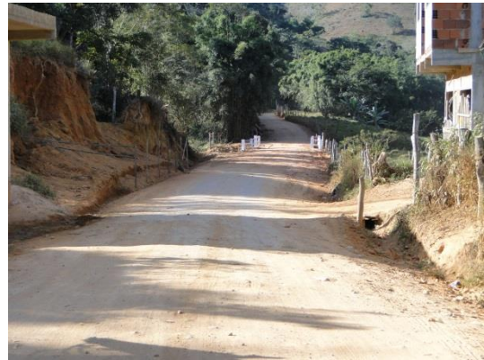
Figura 29 - Via sem pavimentação no bairro Fundão
