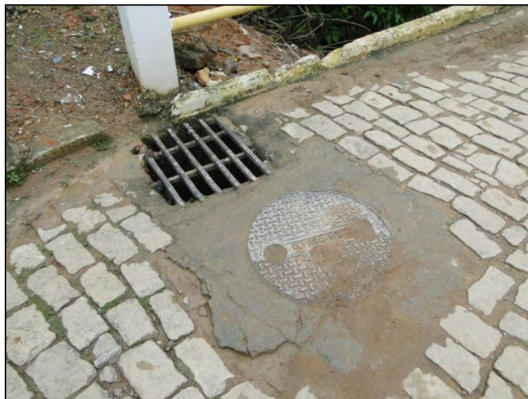
Figura 31 - Boca de lobo próxima à Ponte dos Moinhos
