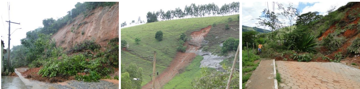
Figura 35 - Episódio de escorregamento no município
