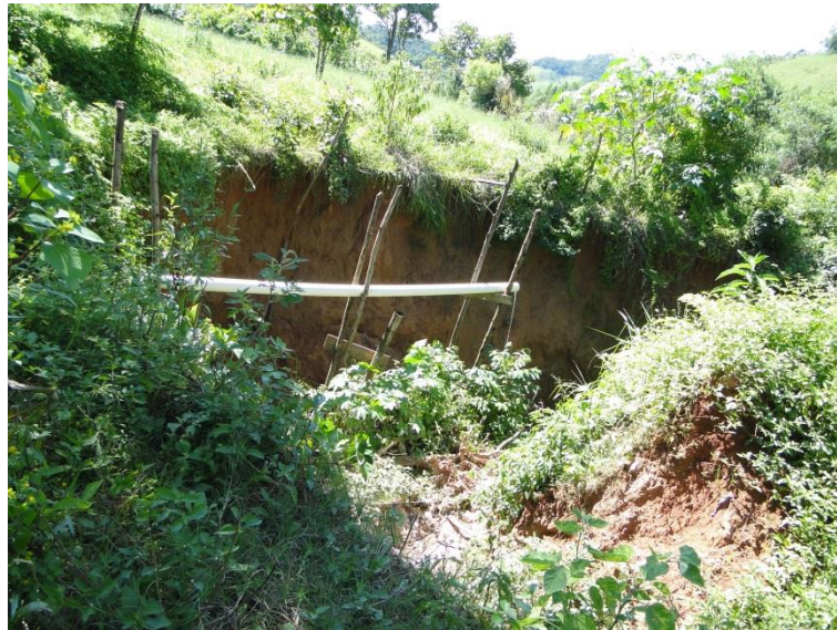
Figura 32 - Lançamento de esgoto em corpo d'água
