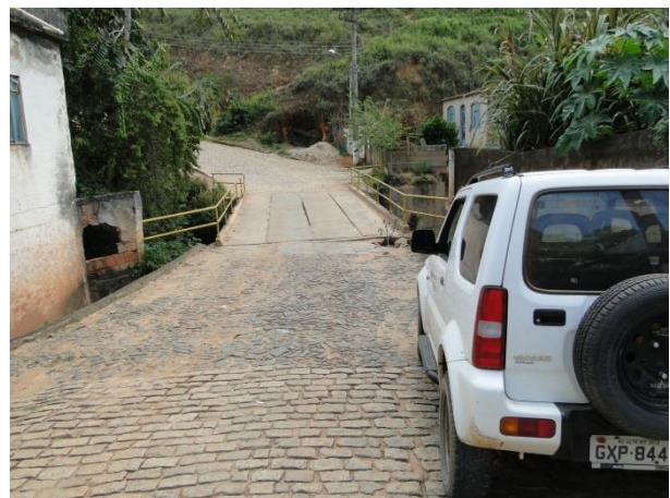
Figura 27 - Pavimentação com pedras na travessa Cap. Gomes
