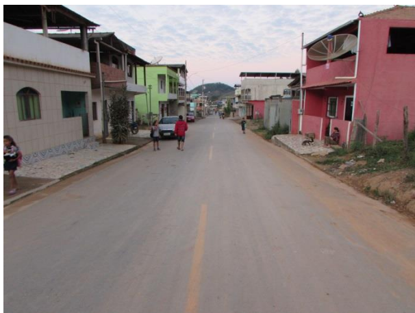
Figura 26 - Via asfaltada no município de Cipotânea
