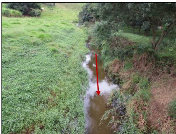
Figura 29 - Vista de montante a partir da Ponte 3 (sobre o rio Xopotó)
