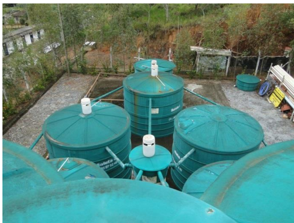
Figura 13 - Vista superior da ETE
