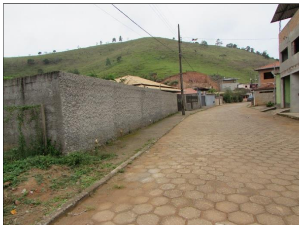
Figura 37 - Rua pavimentada com bloquete sextavado
