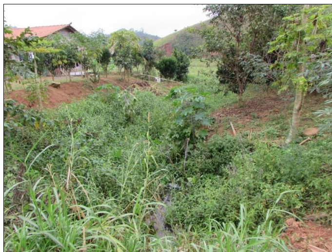
Figura 31 - Vista de jusante a partir da Ponte 4 sobre o córrego água Santa ( afluente do rio Xopotó)
