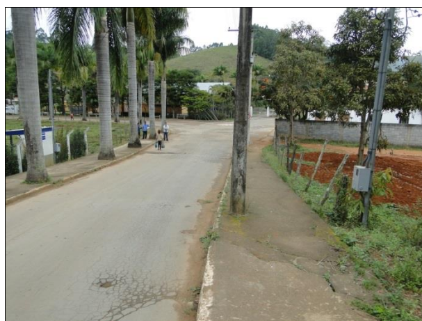
Figura 38 - Rua pavimentada com asfalto - cruzamento entre a Av. Francisco Afonso Filho e Prof. Joaquim Magalhães de Sousa, onde ocorrem alagamentos
