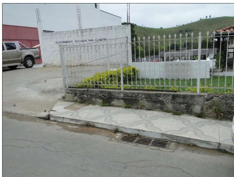
Figura 41 - Detalhe da rede de drenagem
