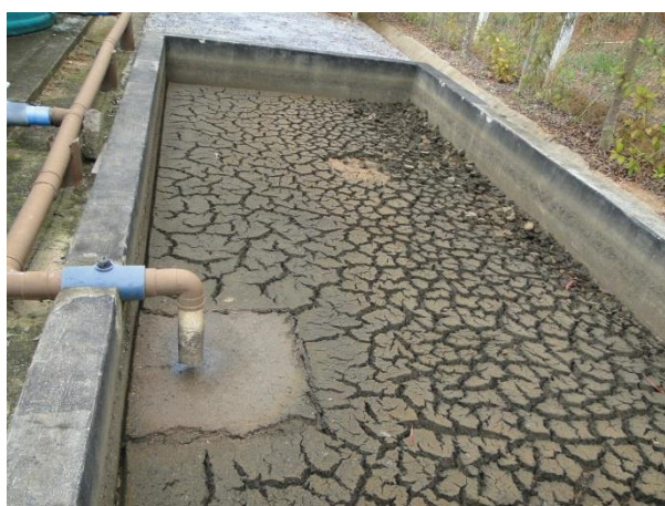
Figura 14 - Leitos de secagem de lodos
