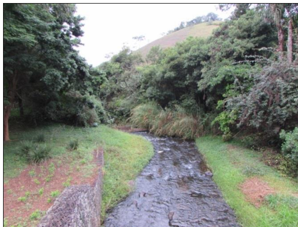
Figura 25 - Vista de jusante da Ponte 1 sobre o rio Xopotó
