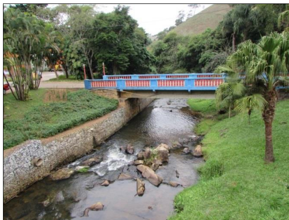
Figura 24 - Ponte 1 sobre o rio Xopotó
