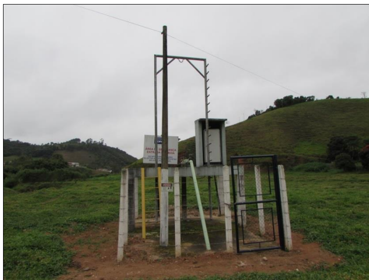
Figura 2 - Poço tubular fundo C-02
