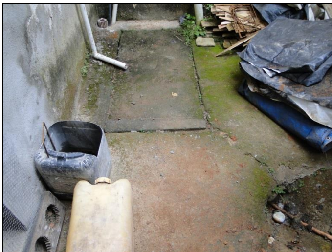
Figura 35 - Afluente canalizado do rio Xopotó - trecho que passa sob as construções
