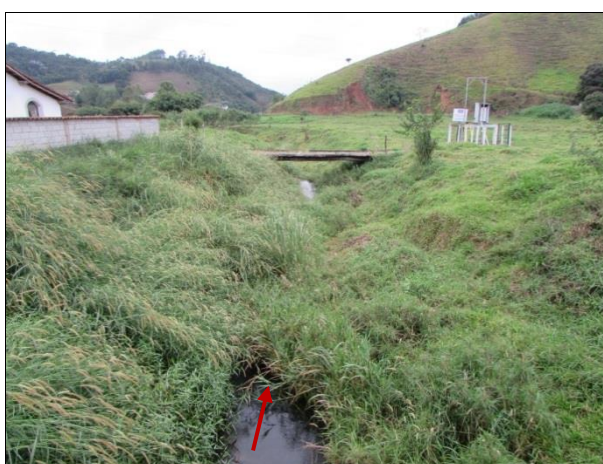
Figura 30 - Vista de jusante a partir da Ponte 3 (sobre o rio Xopotó)
