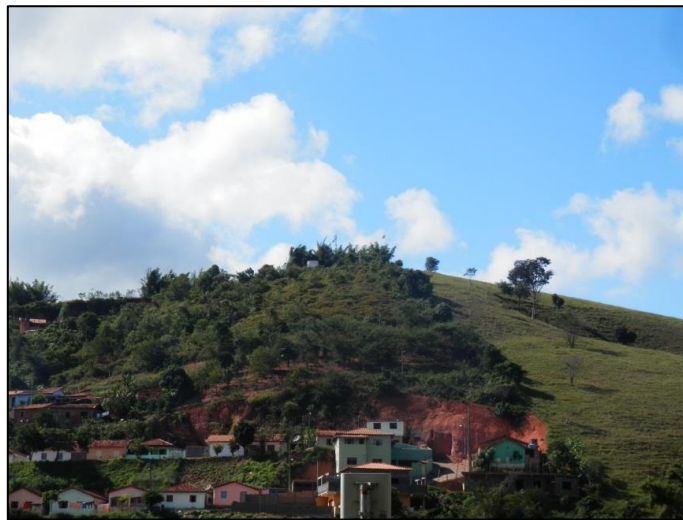
Figura 15 - Área de encosta ocupada
