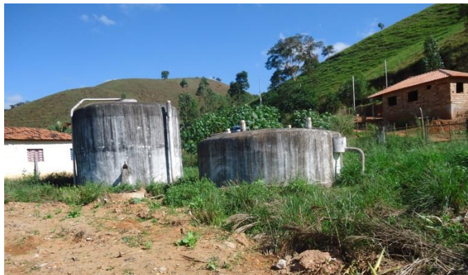
Figura 9 - ETE abandonada na sede de Diogo de Vasconcelos
