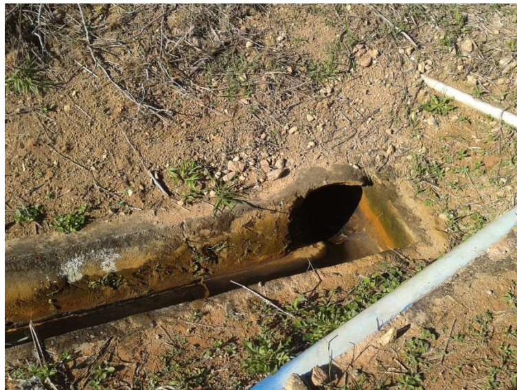
Figura 2 - Canaleta de águas pluviais da ETA, onde são dispostos os efluentes de lavagens
