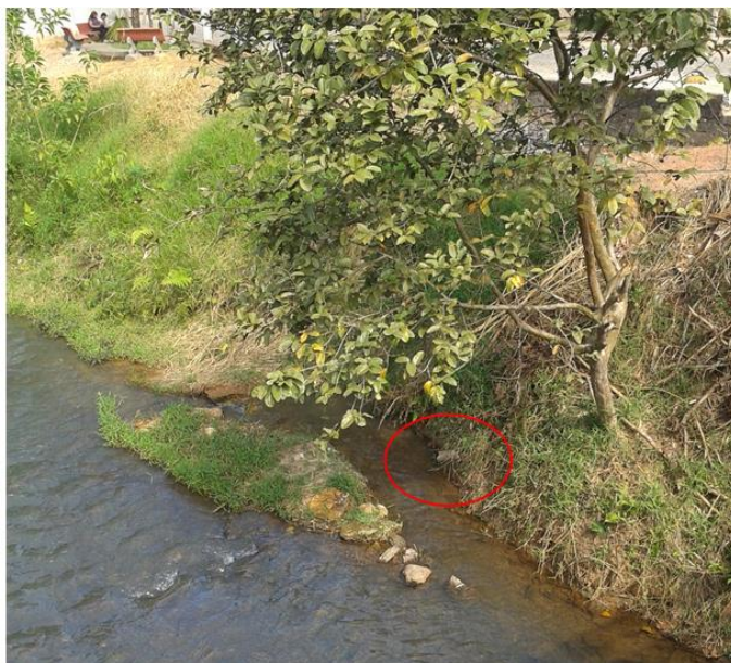
Figura 18 - Lançamento de esgotos 07
