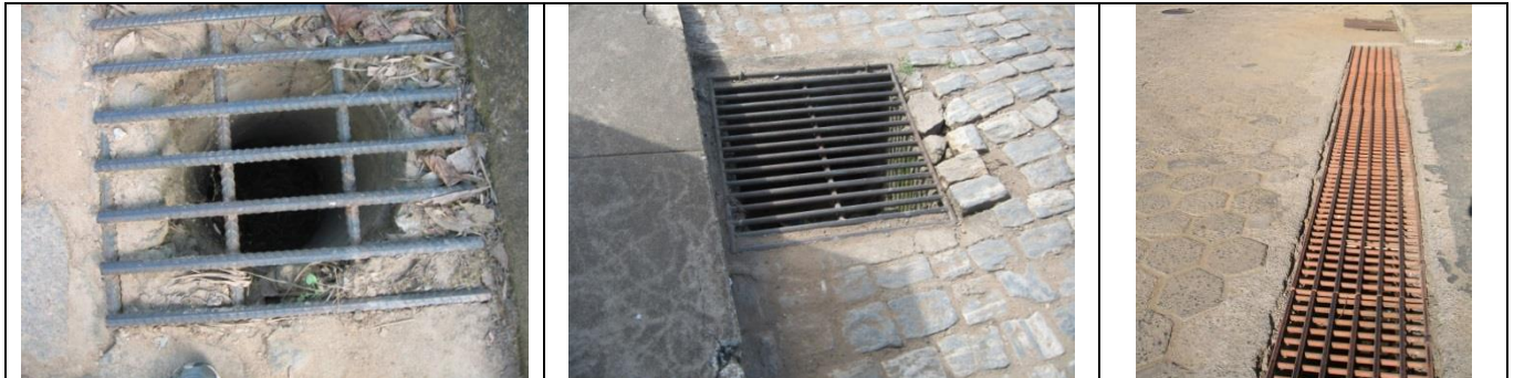
Figura 23 - Aspectos das bocas de lobo
