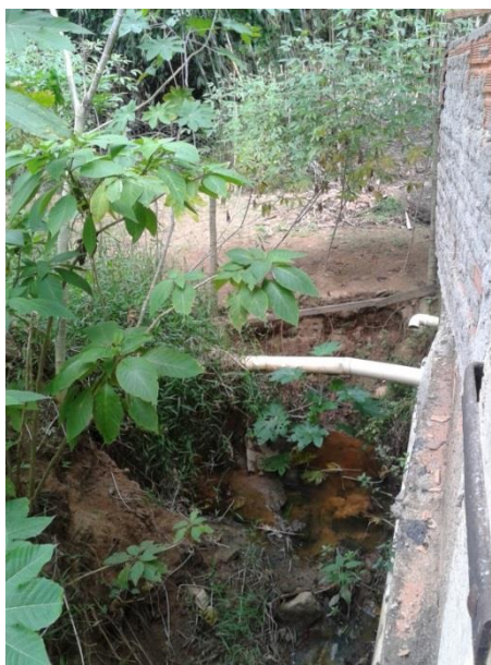
Figura 16 - Lançamento de esgotos 05
