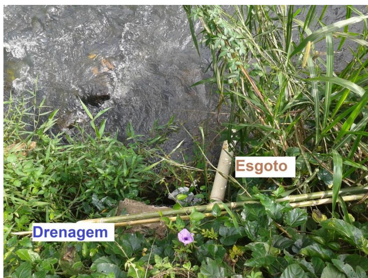
Figura 14 - Lançamento de esgotos 03
