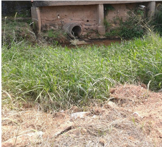
Figura 19 - Lançamento de esgotos 08
