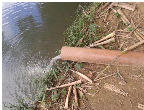
Figura 12 - Lançamento de esgotos 01
