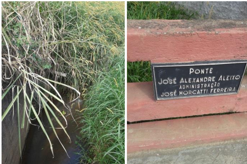
Figura 20 - Lançamento de esgotos 09
