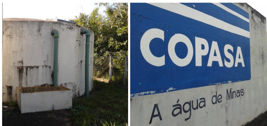
Figura 5 - Reservatório de água tratada 02 e 03
