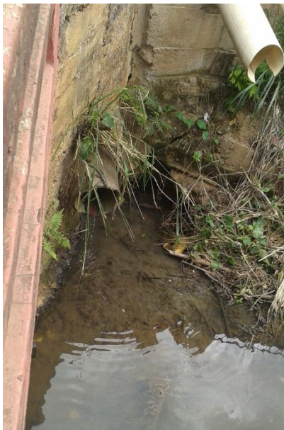
Figura 15 - Lançamento de esgotos 04
