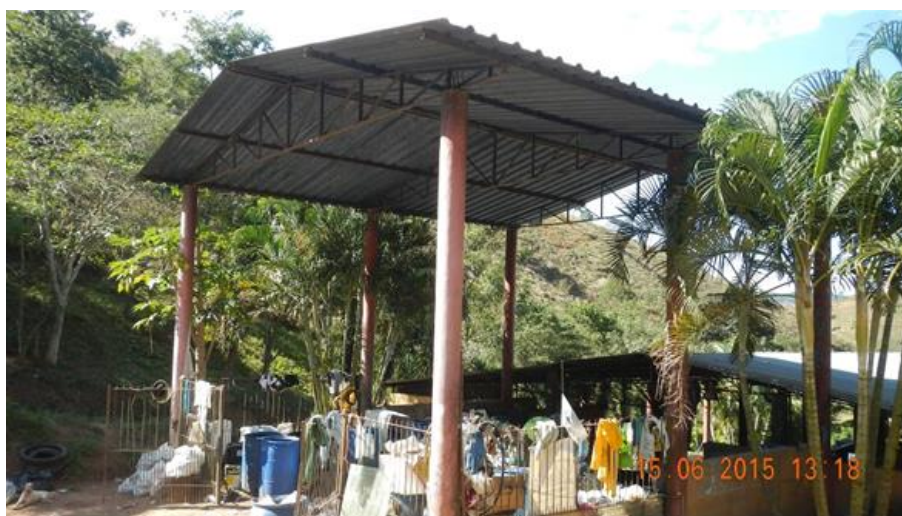
Figura 55 - Galpão de recepção dos resíduos sólidos
