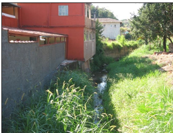
Figura 36 - Vista do córrego do Mingau e ocupações no seu entorno
