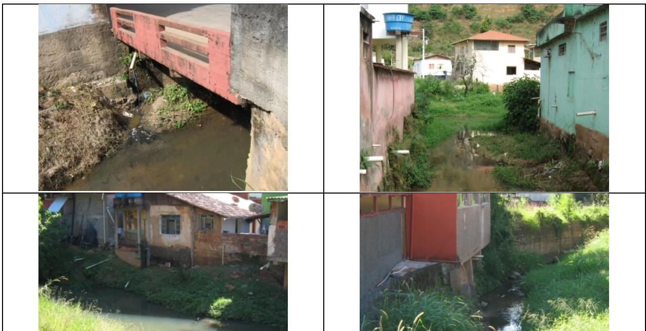
Figura 42 - Lançamento de esgoto nos corpos hídricos da sede municipal
