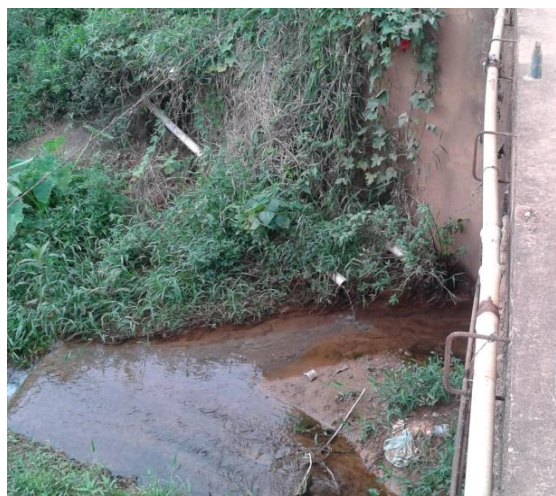
Figura 32 - Lançamento de esgotos 02
