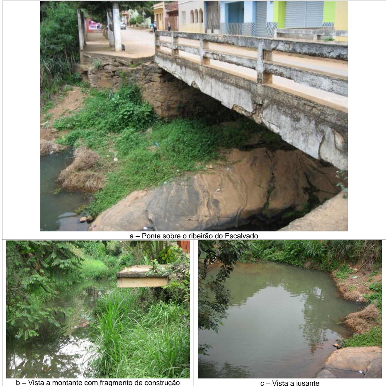
Figura 47 - Detalhe da Ponte 4 sobre o ribeirão do Escalvado
