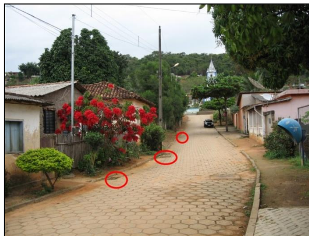
Figura 63 - Detalhe da microdrenagem do povoado de São José da Vargem Alegre
