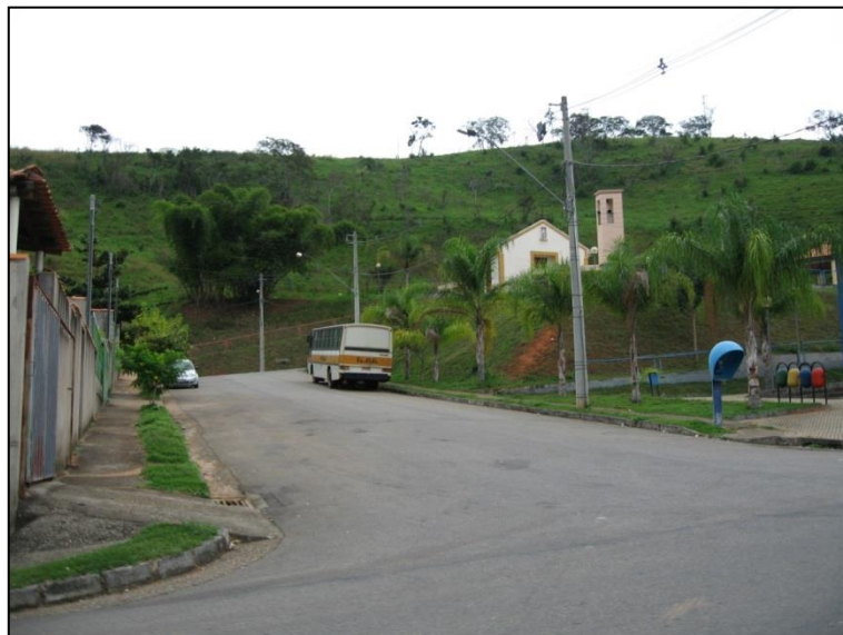
Figura 54 - Pavimentação – São Sebastião do Soberbo
