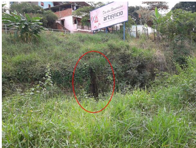
Figura 29 - Lançamento de esgotos 06
