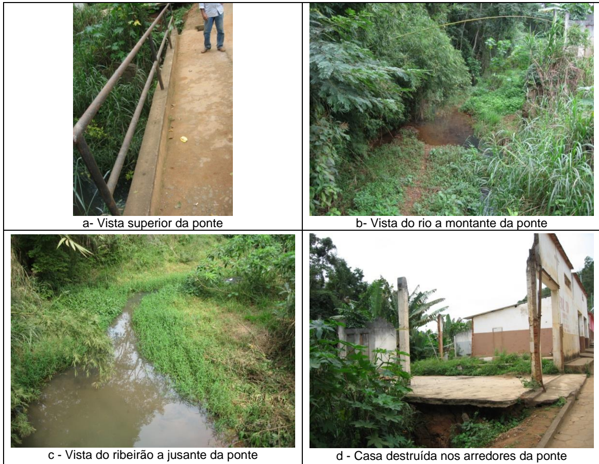
Figura 45 - Detalhes da Ponte 2 sobre o ribeirão do Escalvado
