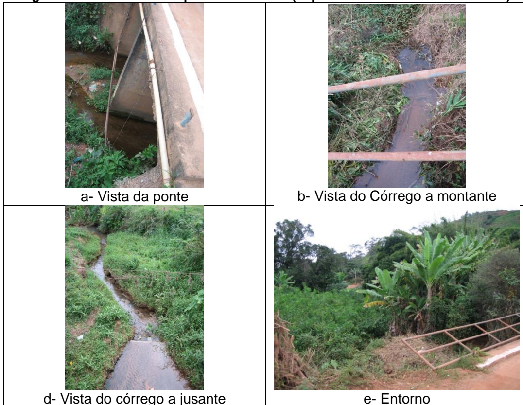
Figura 51 - Vista da oitava ponte amostrada (2º ponte do distrito de Zito Soares)
