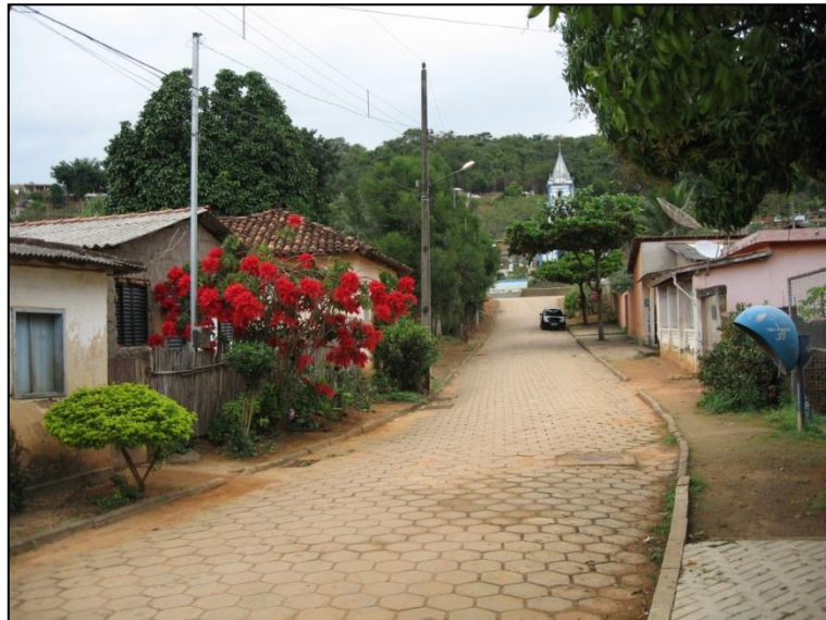
Figura 56 - Pavimentação de bloquete sextavado – São José da Vargem Alegre
