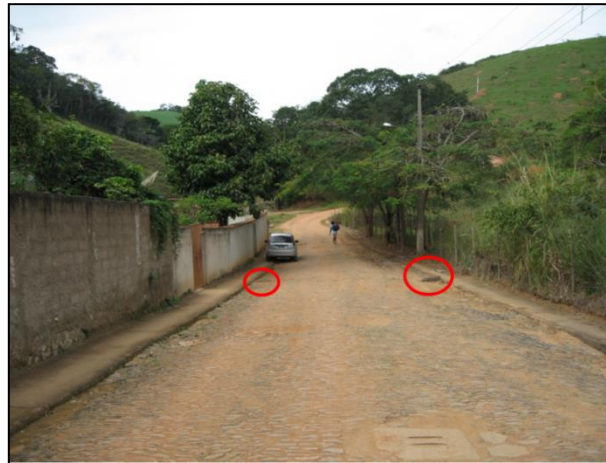
Figura 62 - Detalhe da microdrenagem do povoado de São José da Vargem Alegre
