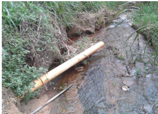
Figura 31 - Lançamento de esgotos 01
