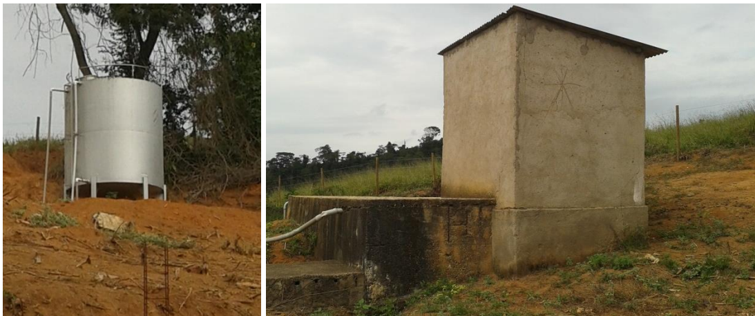
Figura 14 - Reservatórios de água de São José de Vargem Alegre
