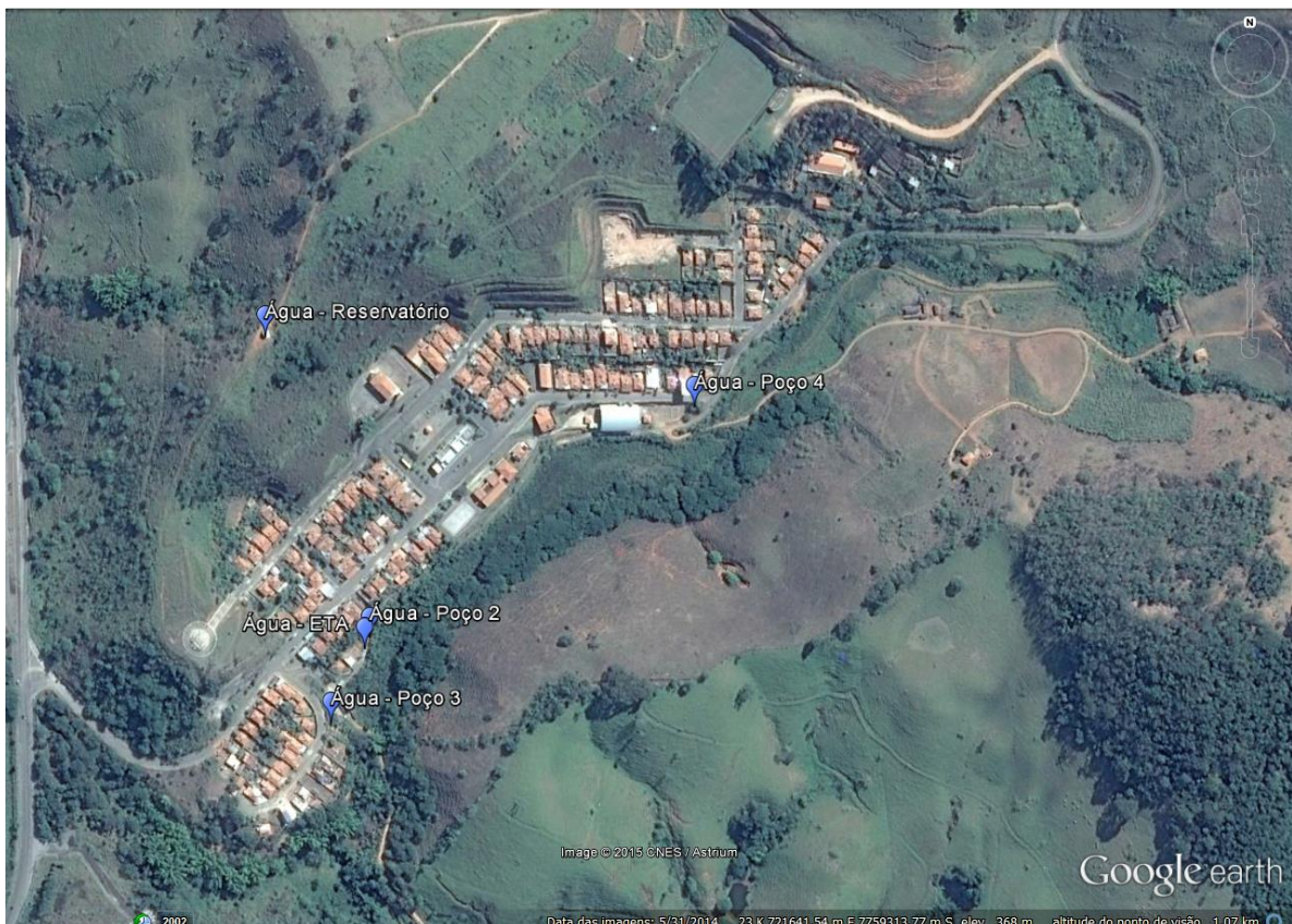
Figura 9 - Imagem de satélite com a localização dos equipamentos do SAA de São Sebastião do Soberbo
