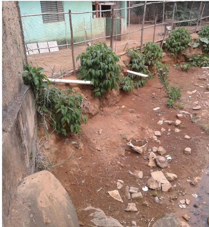
Figura 34 - Esgoto a céu aberto na sede
