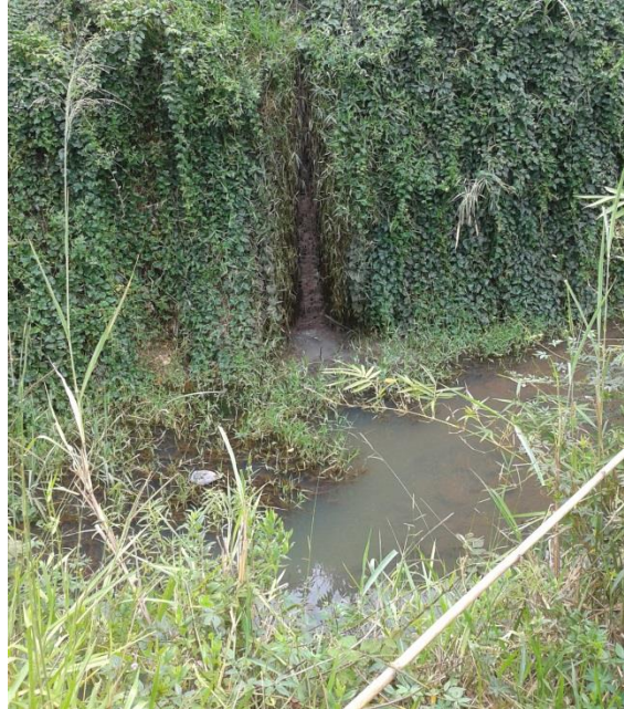
Figura 28 - Lançamento de esgotos 05
