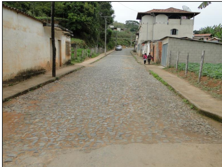
Figura 50 – Rua pavimentada com brita
