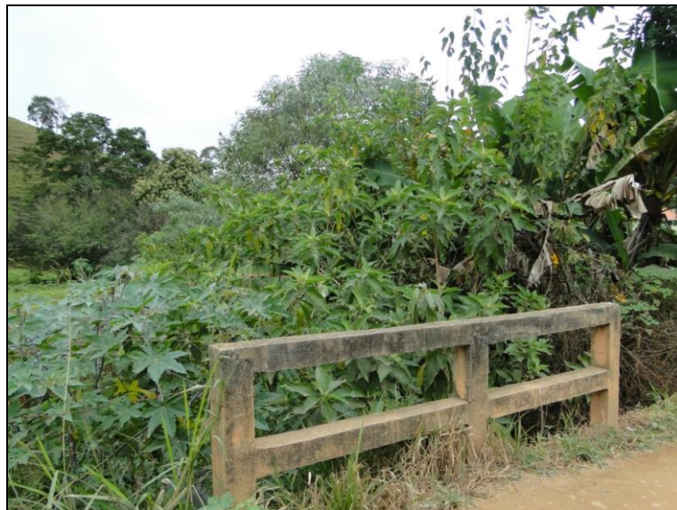
Figura 46 – Ponte sobre o córrego afluente do ribeirão Conceição (vista a jusante)
