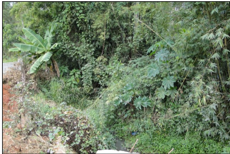
Figura 43 – Ponte sobre córrego afluente do ribeirão Conceição – vista a jusante
