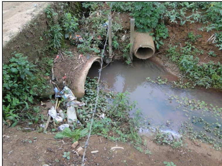
Figura 64 – Ponte sobre o córrego afluente do córrego dos Pintos – tubulação para lançamento de águas pluviais
