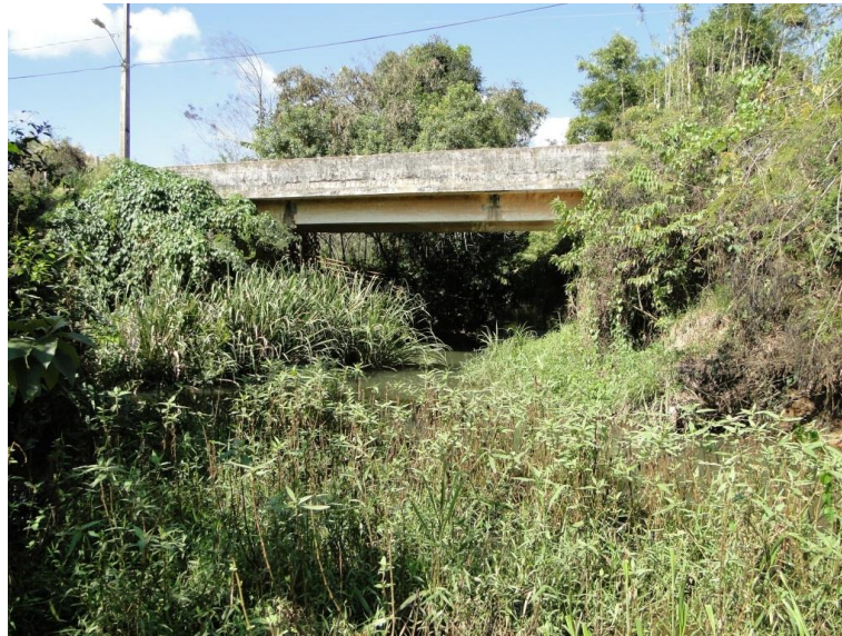
Figura 73 – Ponte sobre o rio Brejaúba
