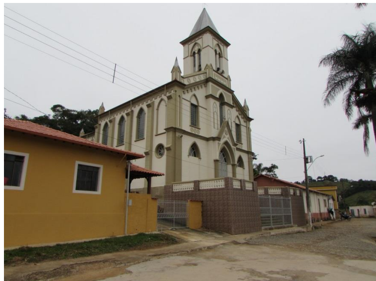
Figura 85 – pavimentação de asfalto e de pedras
