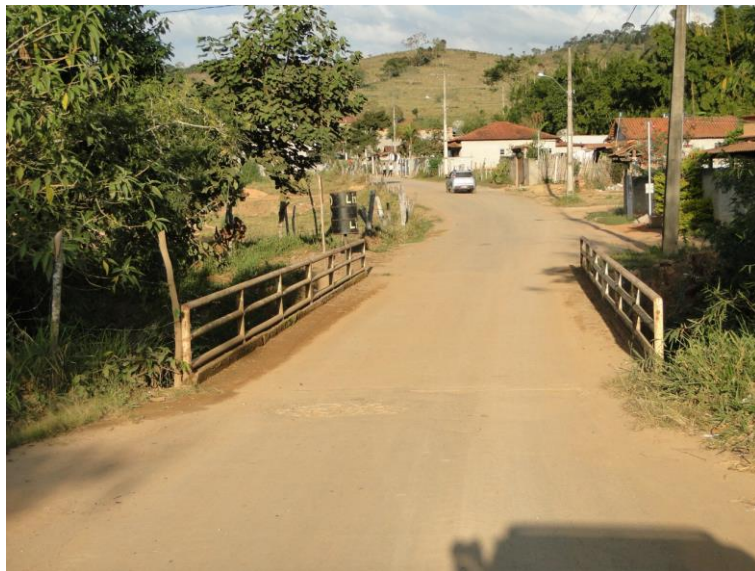
Figura 76 – Ponte sobre o rio Brejaúba - vista de montante para jusante
