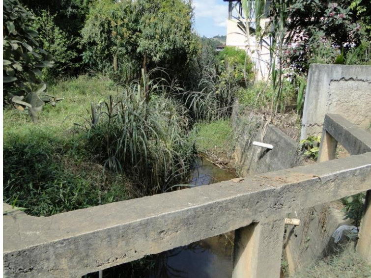
Figura 75 – Ponte sobre o rio Brejaúba - vista de jusante para montante
