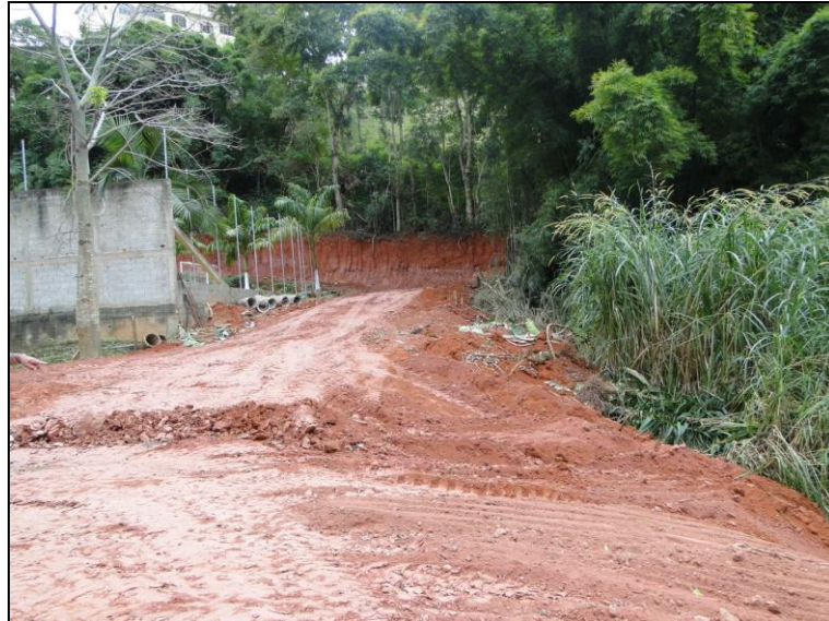
Figura 94 – Aterro da APP da nascente do córrego afluente do ribeirão Conceição
