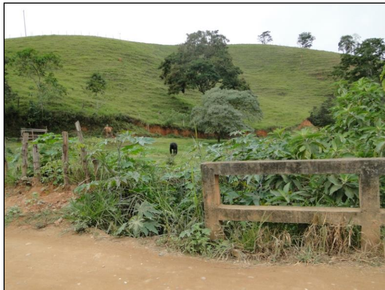
Figura 45 – Ponte sobre o córrego afluente do ribeirão Conceição (margem esquerda do curso d'água a jusante da ponte)
