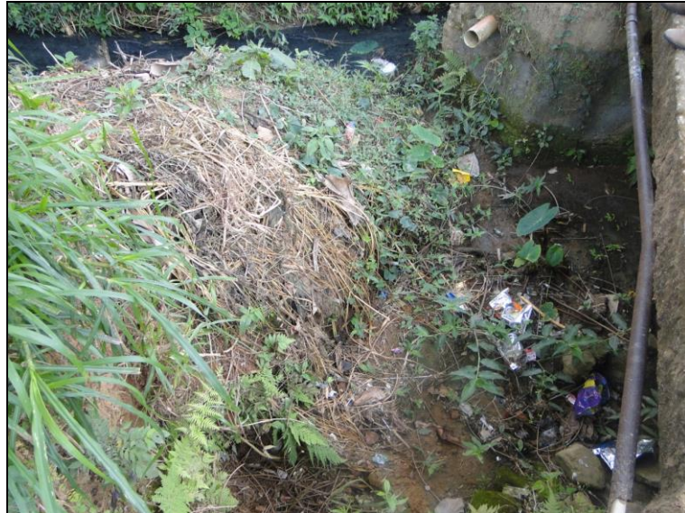
Figura 47 – Ponte sobre o córrego do Alto Rio Doce (vista de jusante para montante)
