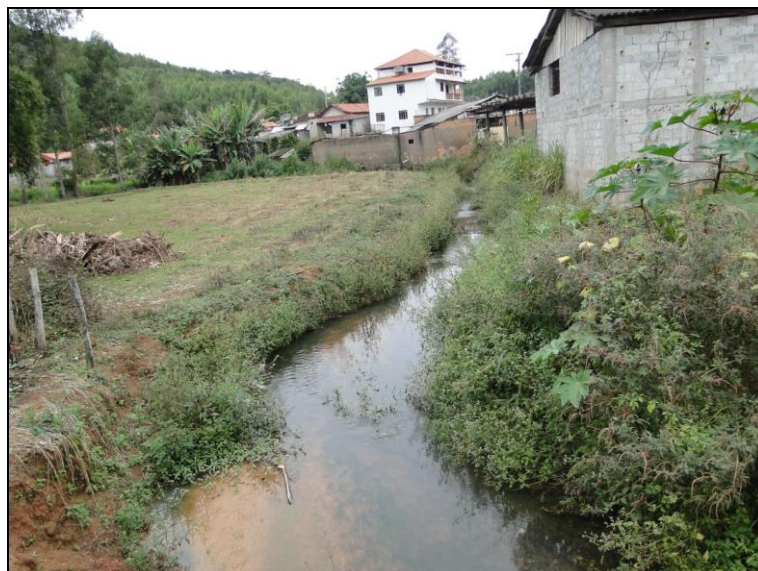
Figura 54 – Ponte sobre o córrego dos Pintos – vista a jusante da ponte
