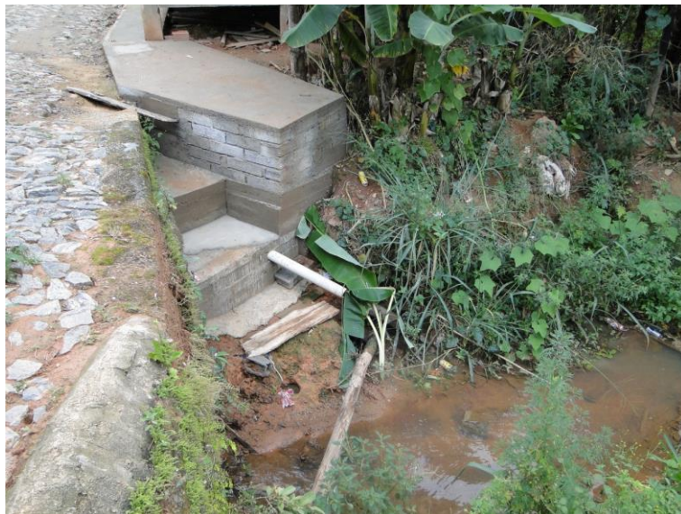
Figura 61 – Ponte sobre o córrego afluente do córrego dos Pintos – escada para escoamento das águas pluviais
