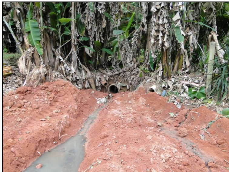
Figura 91 – APP da nascente com solo exposto, algumas bananeiras e lançameto de esgoto in natura
