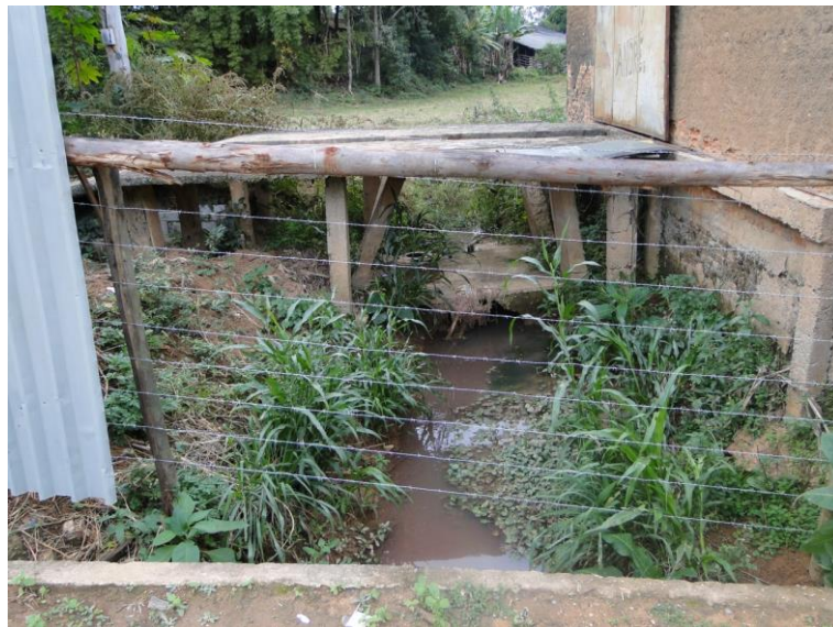
Figura 63 – Ponte sobre o córrego afluente do córrego dos Pintos – vista de montante para jusante
