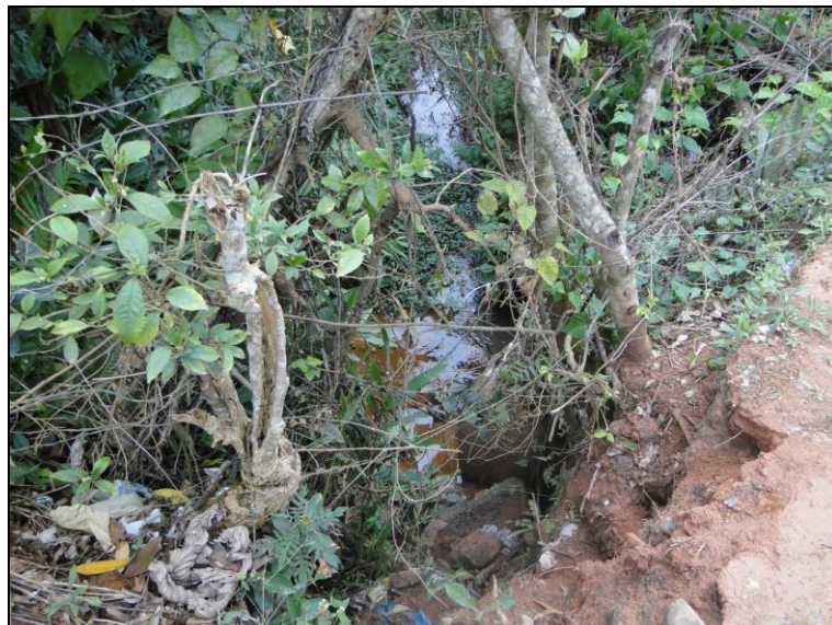
Figura 56 – Ponte sobre córrego afluente do córrego dos Pintos – tubulação de passagem e vista a jusante da ponte
