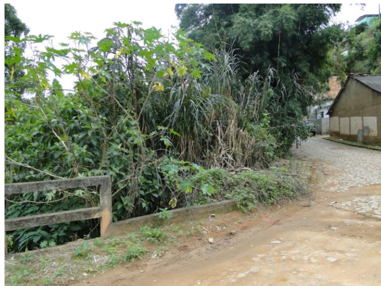
Figura 44 – Ponte sobre o córrego afluente do ribeirão Conceição (margem esquerda do curso d'água a montante da ponte)
