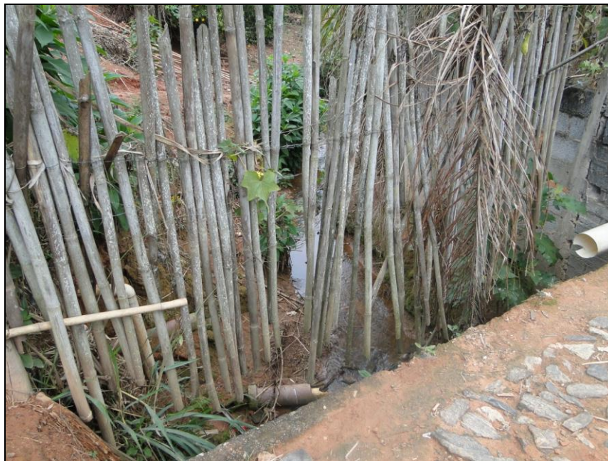
Figura 59 – Ponte sobre o córrego afluente do córrego dos Pintos – vista de jusante para montante
