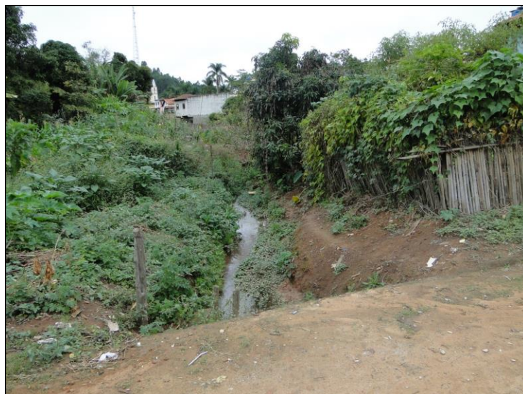
Figura 62 – Ponte sobre o córrego afluente do córrego dos Pintos – vista de jusante para montante
