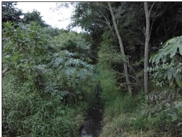
Figura 72 – Ponte sobre córrego afluente do rio Brejaúba - vista de montante para jusante
