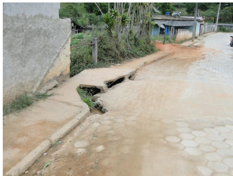
Figura 51 – Rua pavimentada com bloquete sextavado e boca de lobo
