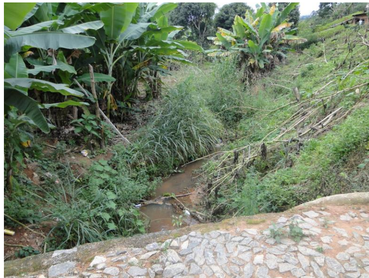
Figura 60 – Ponte sobre o córrego afluente do córrego dos Pintos – vista de montante para jusante
