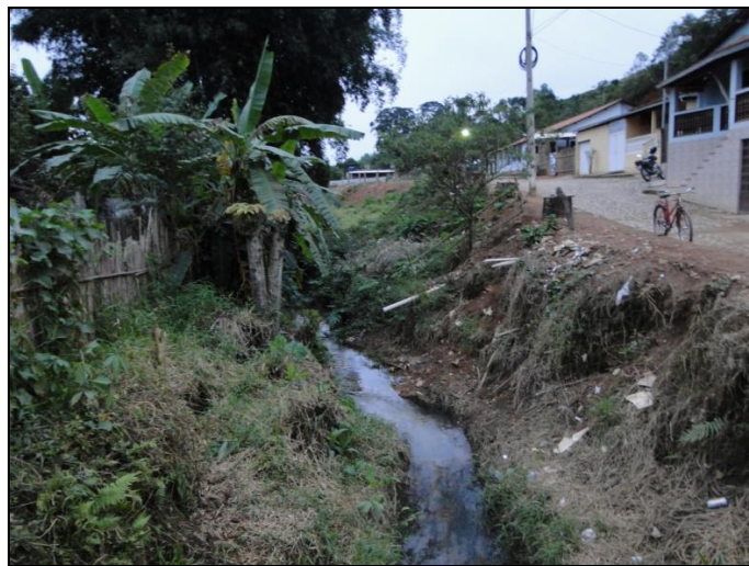
Figura 35 – Lançamento de esgotos in natura - Vitorinos (córrego afluente do rio Brejaúba)
