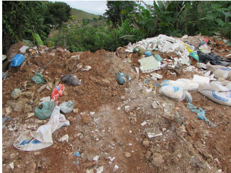
Figura 103 – Local inadequado de descarte de Resíduos de Construção Civil (RCC)
