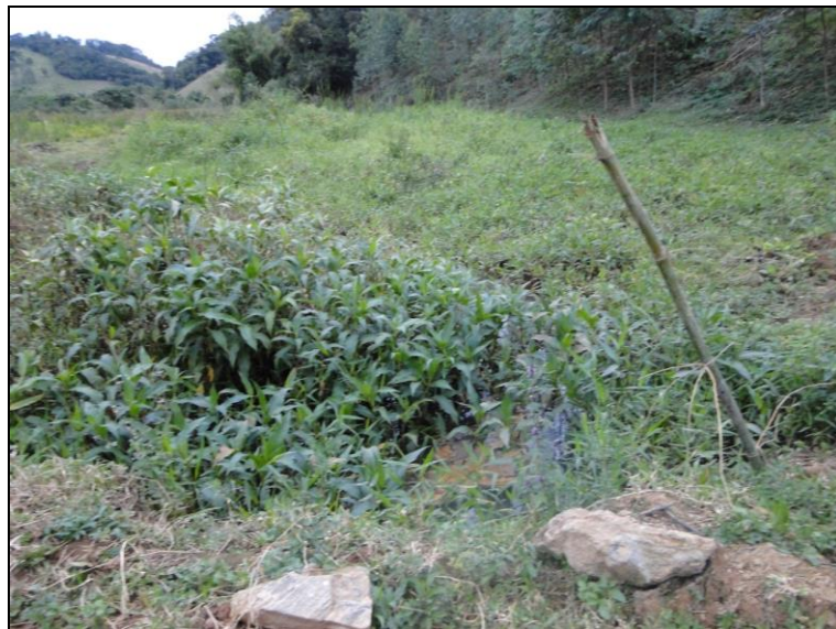
Figura 81 – Ponte sobre córrego afluente do córrego da Vaca – vista de jusante para montante
