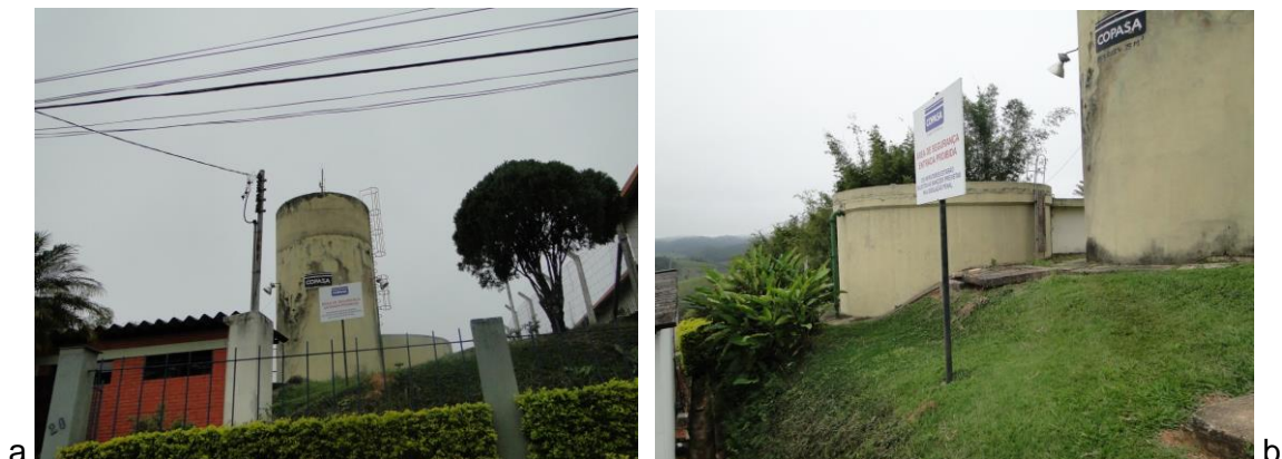
Figura 21 – Reservatório elevado e apoiado (sede)
