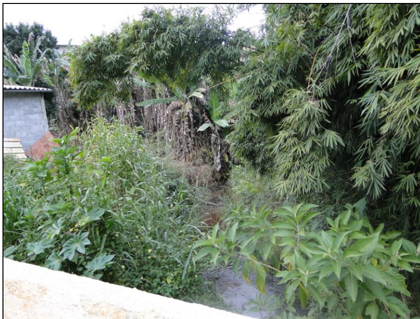
Figura 66 – Ponte sobre córrego dos Pintos – vista de jusante para montante
