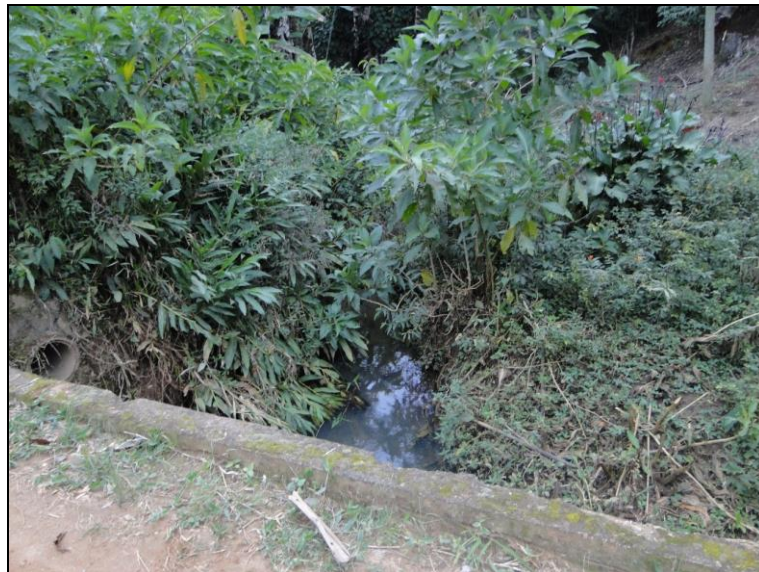
Figura 84 – Ponte sobre o córrego da Vaca – vista de jusante para montante
