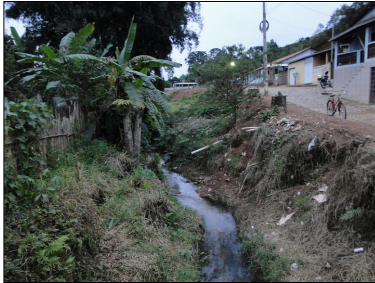
Figura 71 – Ponte sobre córrego afluente do rio Brejaúba - vista de jusante para montante
