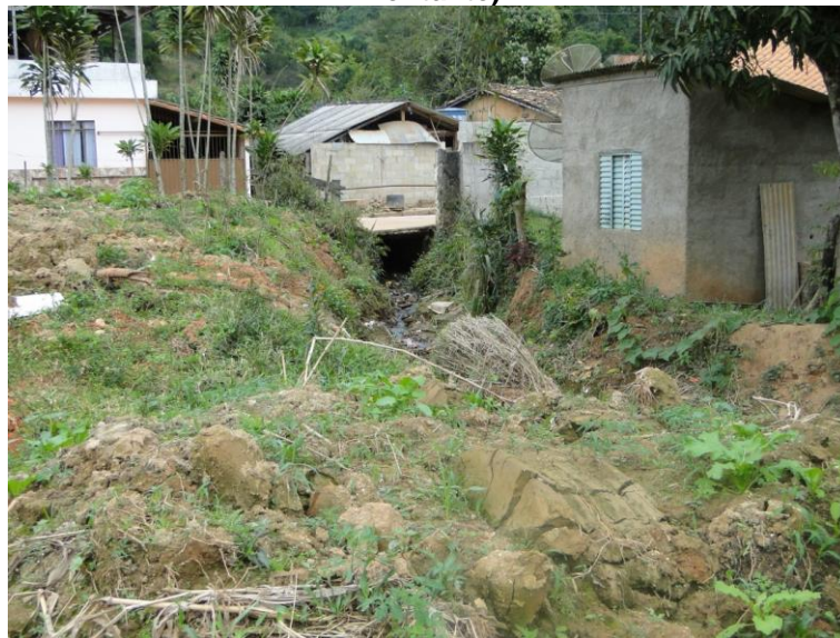
Figura 49 – Casa construída sobre o leito do córrego Alto Rio Doce(vista de jusante para montante)
