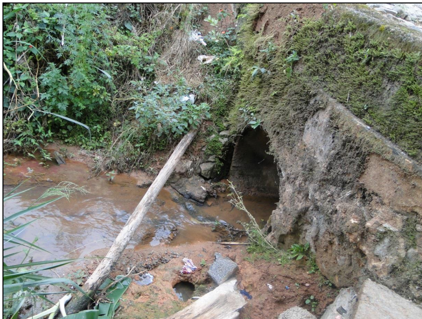
Figura 58 – Ponte sobre o córrego afluente do córrego dos Pintos – tubulação de passagem vista de jusante para montante
