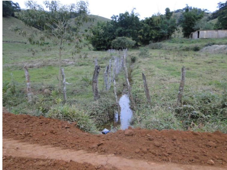
Figura 79 – Ponte sobre córrego afluente do córrego da Vaca – vista de montante para jusante
