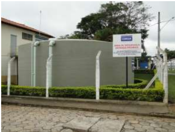
Tanque de contato
