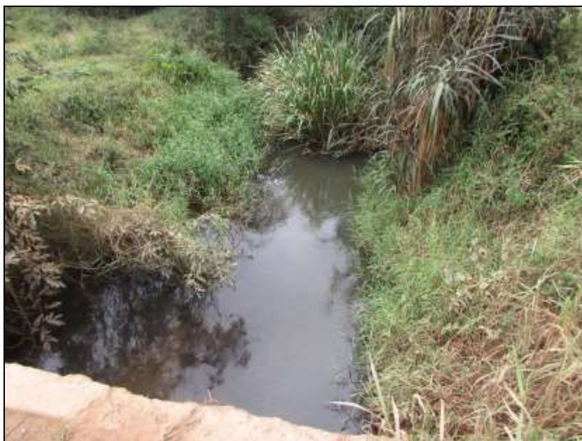
Figura 37 - Visão a montante da Ponte 5, sobre o córrego das Lobas
