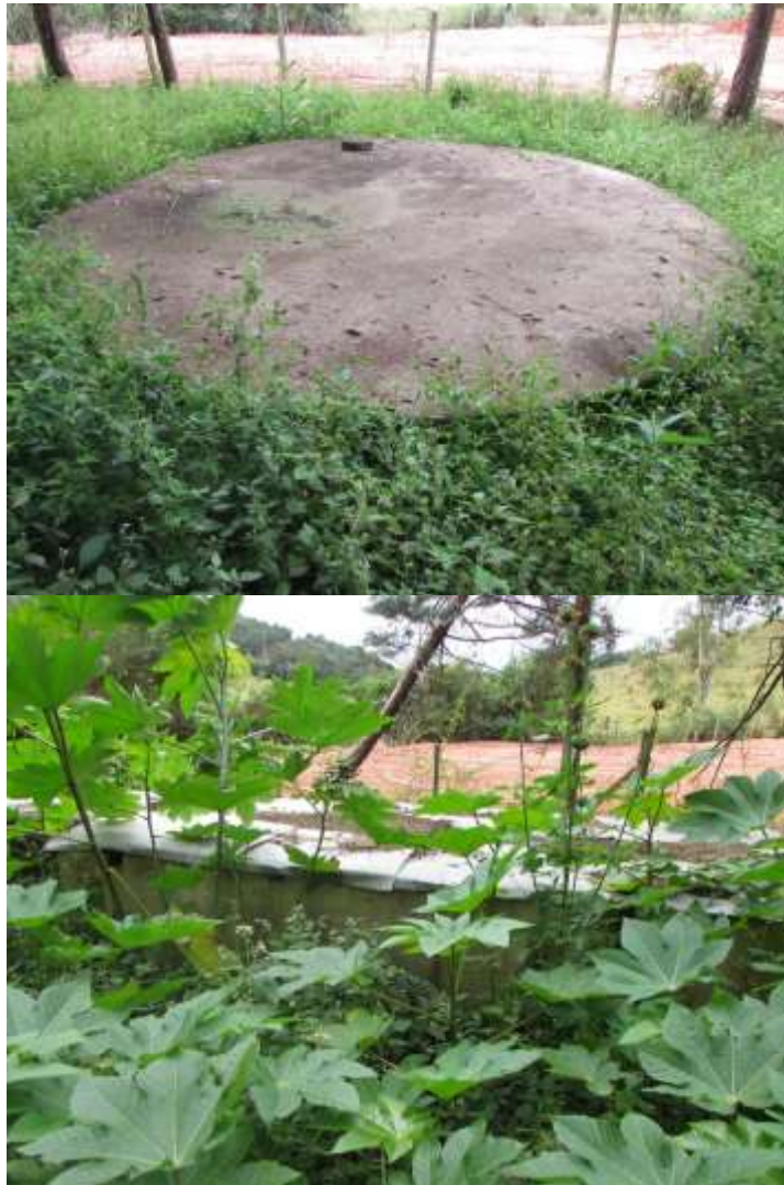
Figura 24 - Estação de tratamento de esgoto desativada de Capela Nova
