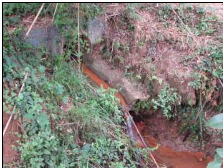
Figura 49 - Lançamento de águas pluviais sem dissipador de energia
