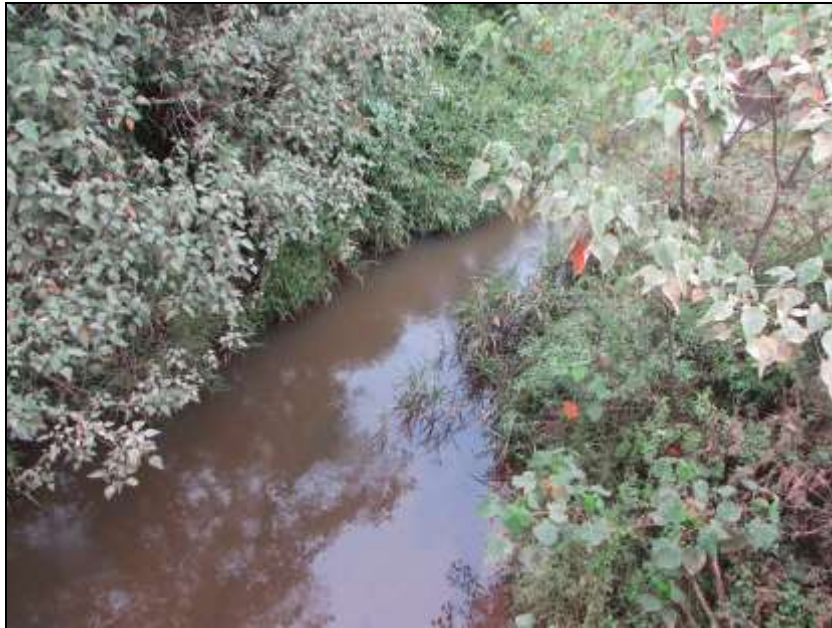
Figura 36 - Visão a jusante da Ponte 4, sobre o rio Piranga
