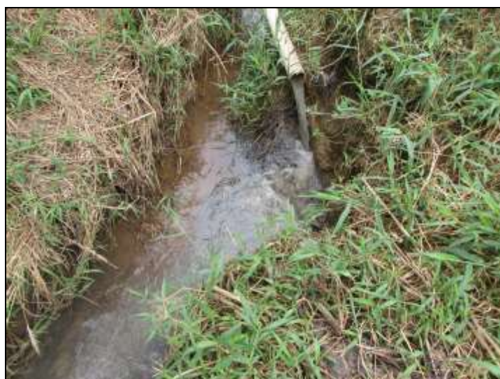
Figura 51 - Lançamento de esgoto in natura a jusante da ETE
