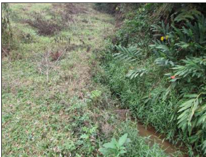
Figura 41 - Visão a jusante da Ponte 7, sobre o córrego Caiçara
