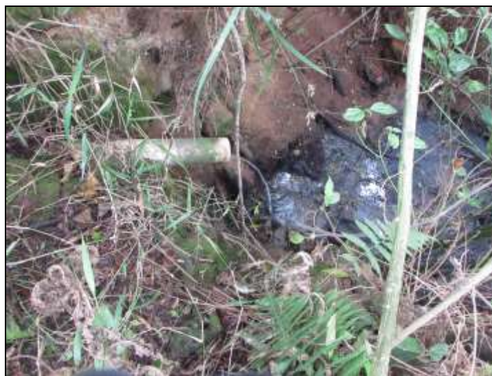
Figura 50 - Lançamento de esgoto sem tratamento no córrego Caiçara
