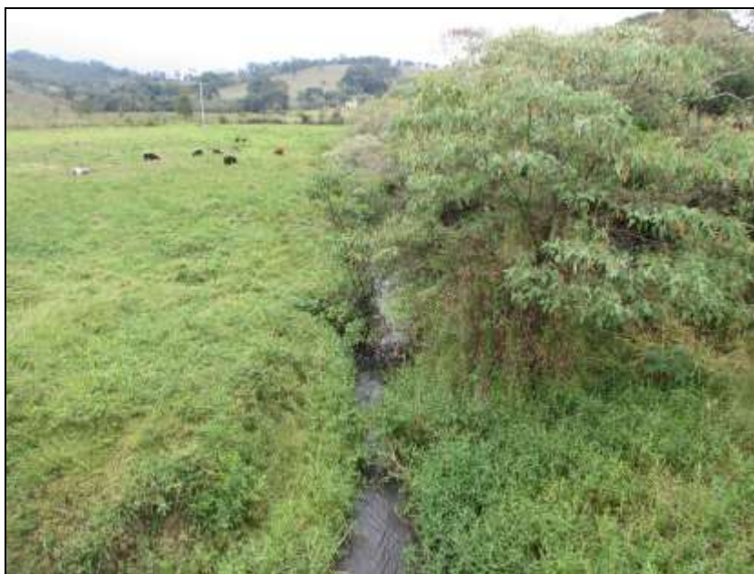
Figura 38 - Visão a montante da Ponte 6, sobre o córrego das Lobas
