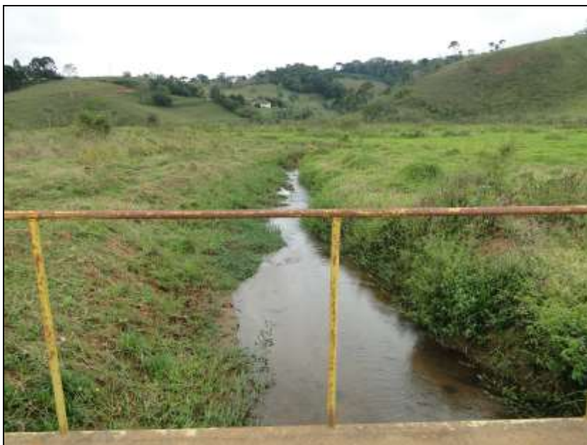
Figura 30 - Visão a jusante da Ponte 1, sobre o ribeirão Pedroso
