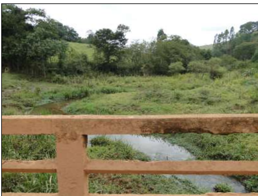
Figura 31 - Visão a montante da Ponte 2, sobre o ribeirão Pedroso
