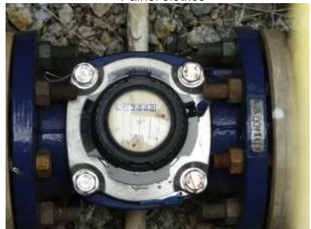
Adutora de água tratada e macromedidor de volume mecânico
