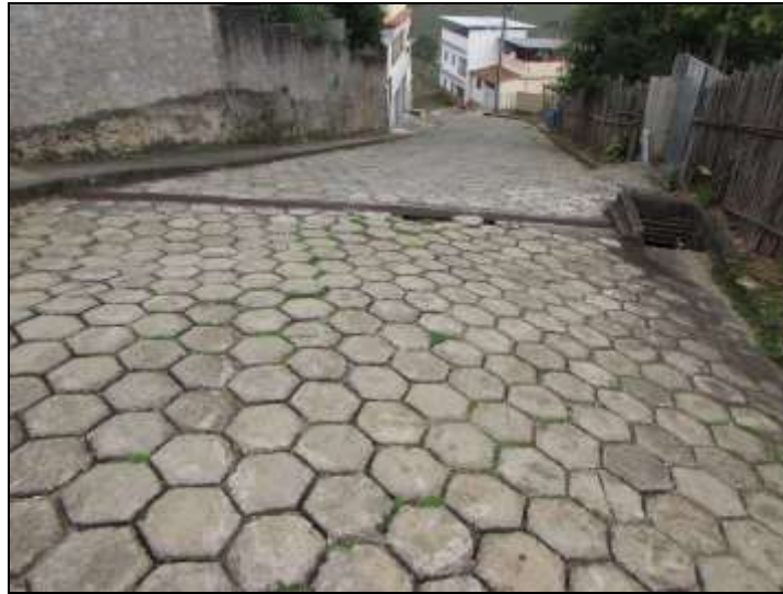
Figura 47 - Detalhe da rede de drenagem
