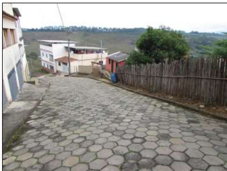
Figura 43 - Via revestida com bloquete sextavado
