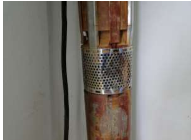
Figura 19 - Bombas reservas dos poços C02 e C04
