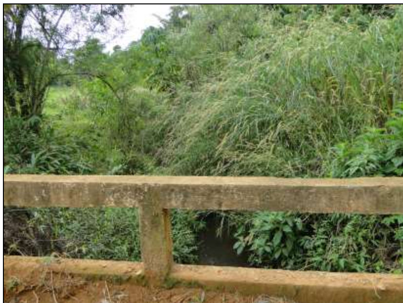
Figura 33 - Visão a montante da Ponte 3, sobre o ribeirão Pedroso
