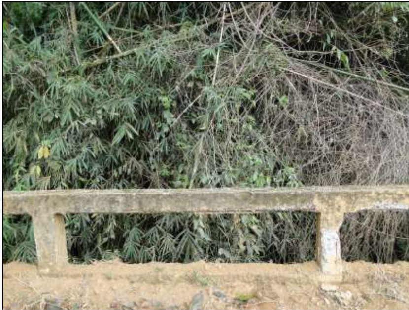
Figura 34 - Visão a jusante da Ponte 3, sobre o ribeirão Pedroso
