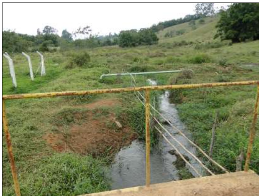
Figura 29 - Visão a montante da Ponte 1, sobre o ribeirão Pedroso
