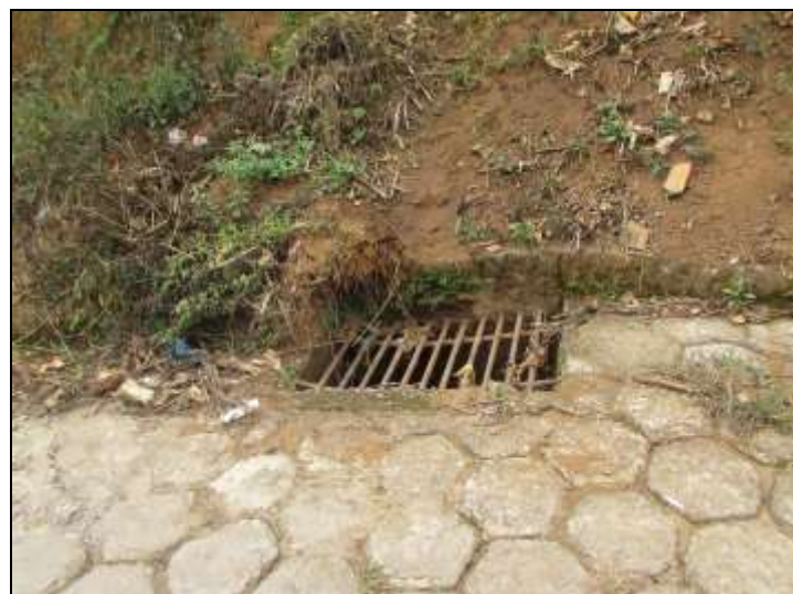
Figura 46 - Detalhe da rede de drenagem
