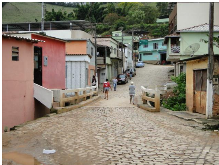
Figura 41 - APP do rio Espera ocupada por arruamento e edificações
