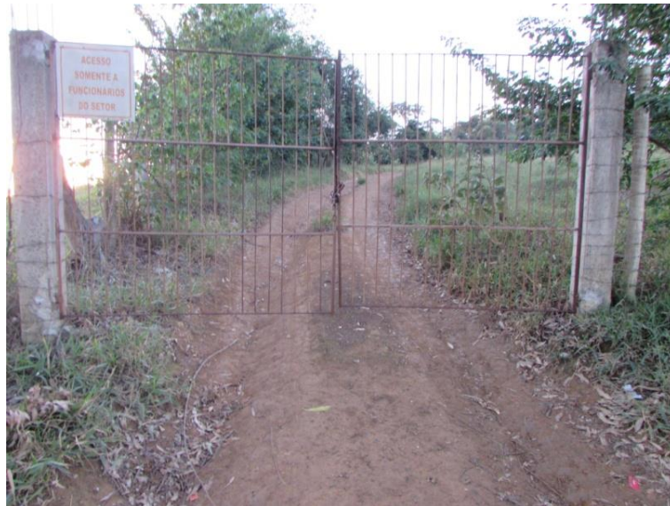
Figura 47 - Isolamento de acesso ao lixão
