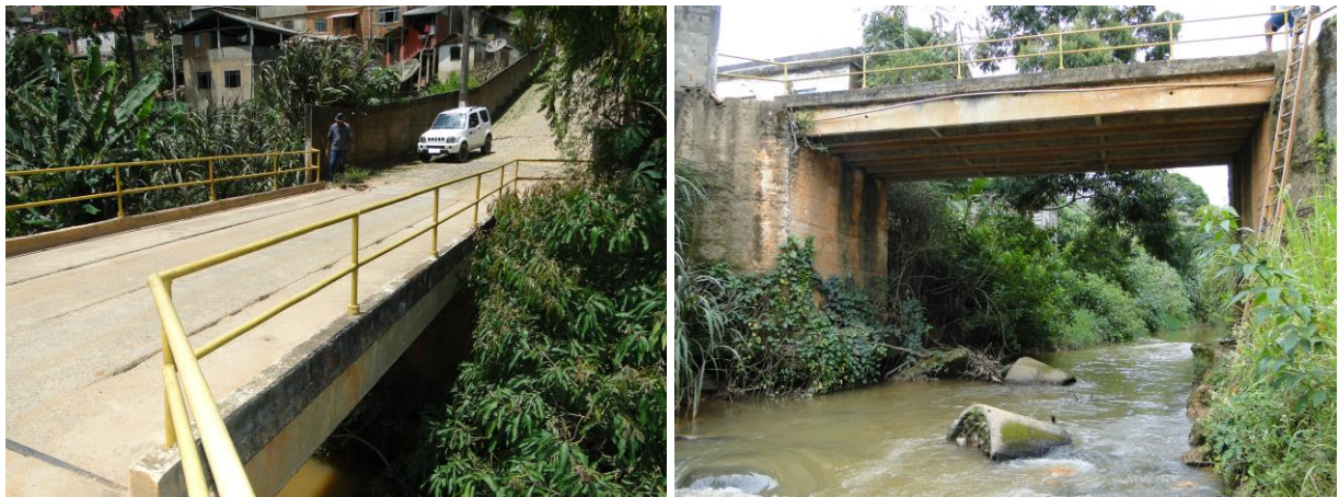
Figura 29 - Ponte sobre o rio Espera na travessa Cap. Gomes
