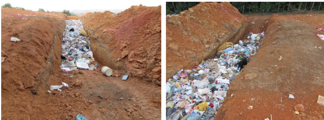
Figura 48 - Aspecto da vala de disposição
