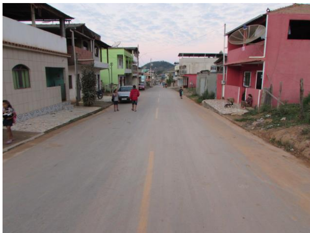
Figura 33 - Via asfaltada no município de Cipotânea
