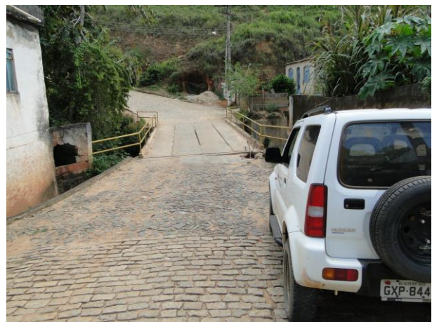
Figura 34 - Pavimentação com pedras na travessa Cap. Gomes
