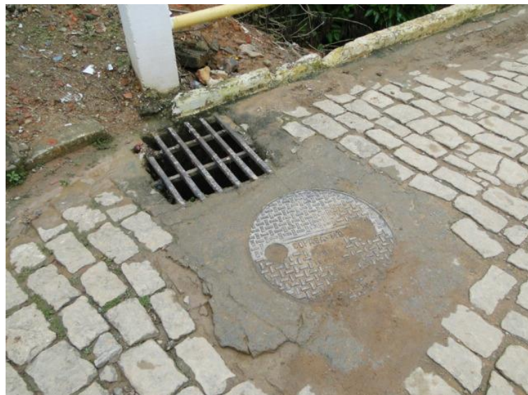
Figura 38 - Boca de lobo próxima à Ponte dos Moinhos
