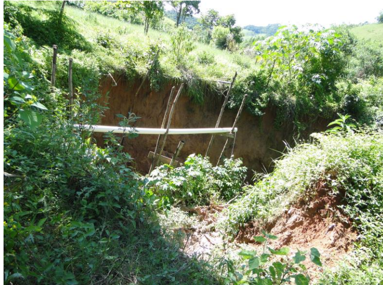
Figura 39 - Lançamento de esgoto em corpo d'água
