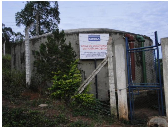
Figura 18 - Reservatório de água tratada
