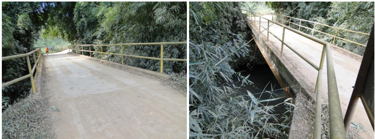
Figura 31 - Ponte da Barra sobre o rio Brejaúba
