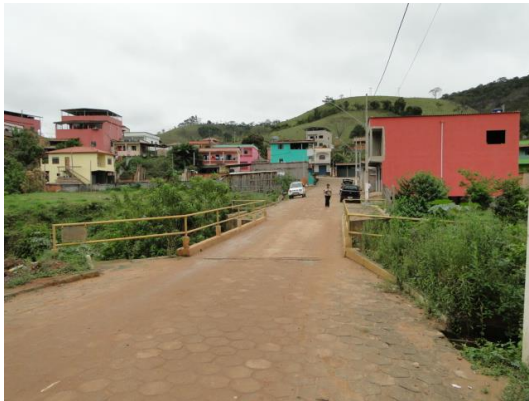
Figura 35 - Pavimentação com bloquete sextavado na rua 13 de Maio
