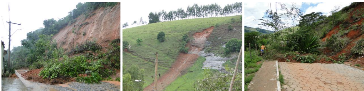
Figura 42 - Episódio de escorregamento no município
