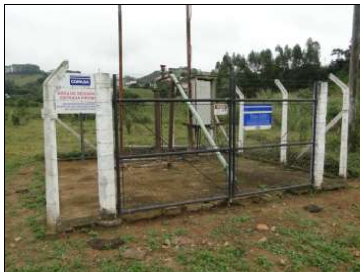
Figura 16 – Poço tubular fundo C-05
