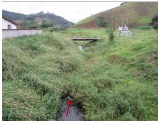
Figura 37 – Vista de jusante a partir da Ponte 3 (sobre o rio Xopotó)
