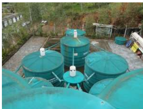
Figura 25 – Vista superior da ETE
