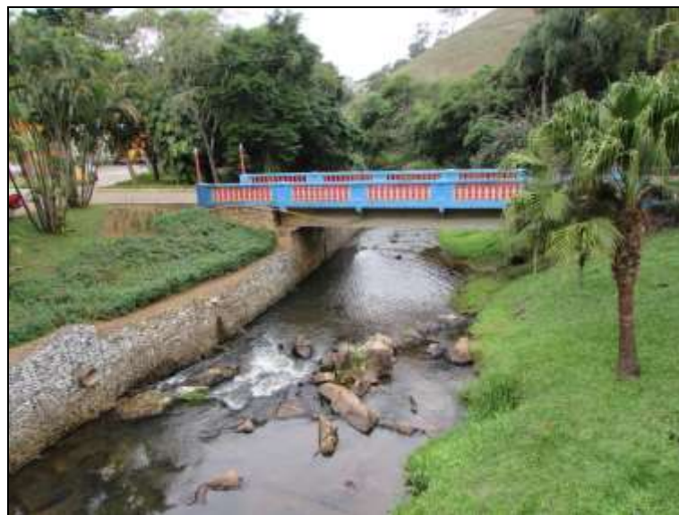
Figura 31 – Ponte 1 sobre o rio Xopotó
