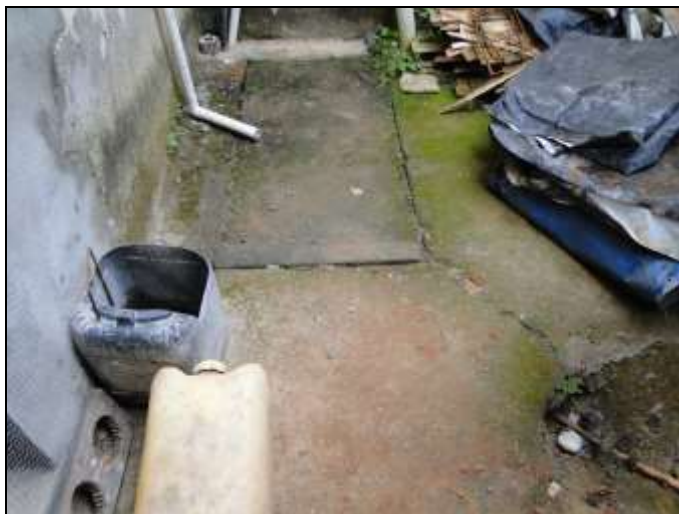
Figura 42 – Afluente canalizado do rio Xopotó – trecho que passa sob as construções
