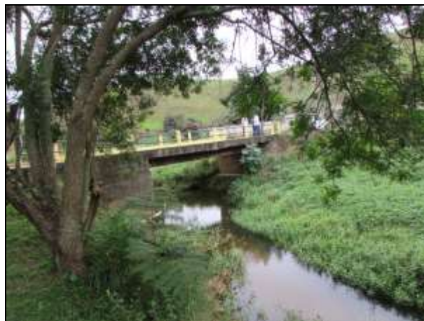
Figura 35 – Ponte 3 sobre o rio Xopotó
