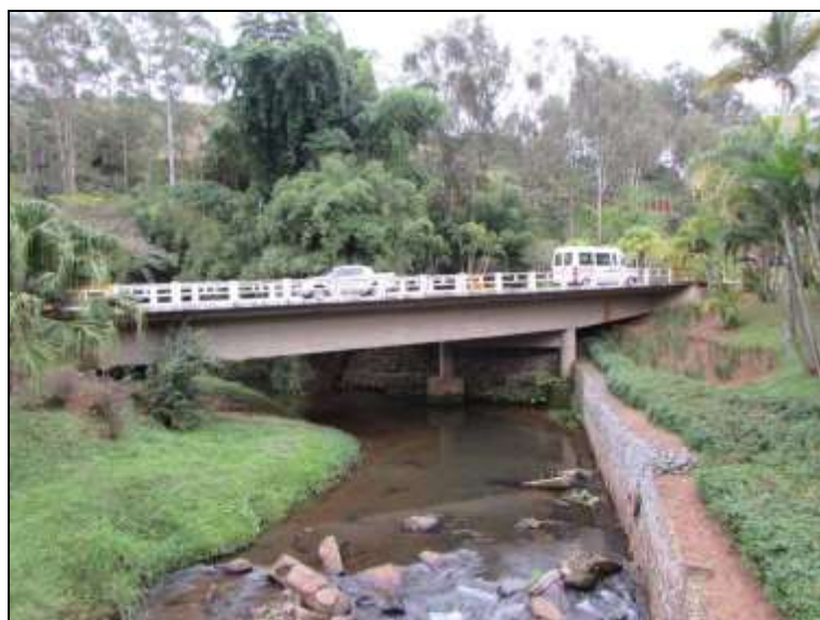
Figura 33 – Ponte 2 sobre o rio Xopotó (vista à montante da Ponte 1)
