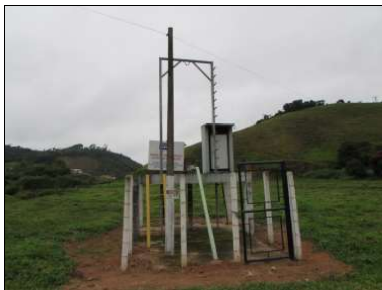
Figura 17 – Poço tubular fundo C-02
