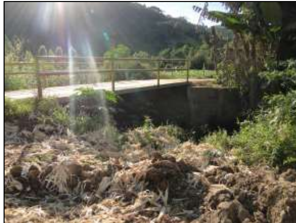
Figura 63 - Ponte 5, sobre o ribeirão das Lobas
