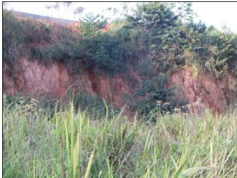
Figura 87 - Erosão na sede de Senhora dos Remédios
