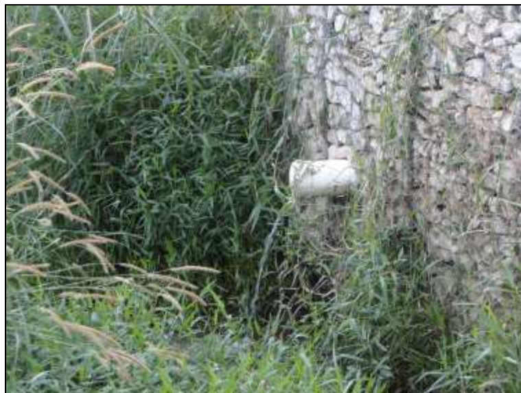
Figura 83 - Lançamento de esgoto in natura no ribeirão das Lobas em Palmital dos Carvalhos
