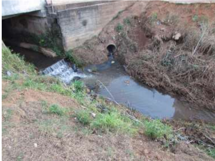
Figura 33 - Lançamento de efluente indevido na rede de drenagem
