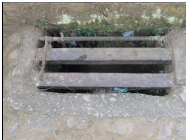
Figura 79 - Boca de lobo na localidade de Japão
