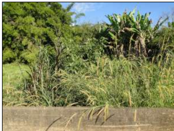
Figura 59 - Visão a jusante da Ponte 3, sobre o ribeirão das Lobas
