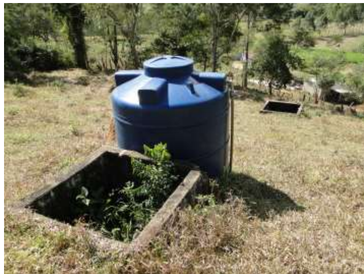
Figura 28 - Reservatório da captação auxiliar de água principal de Palmital dos Carvalhos
