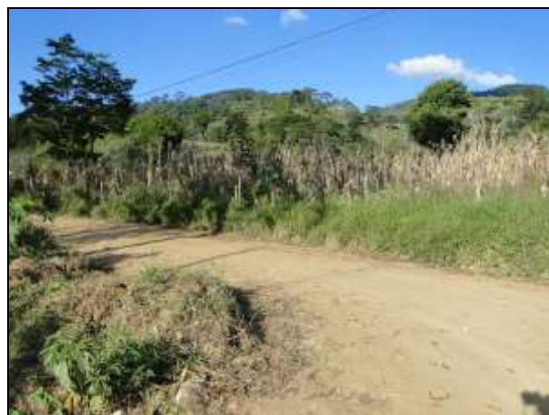
Figura 74 - Via não pavimentada em Palmital dos Carvalhos
