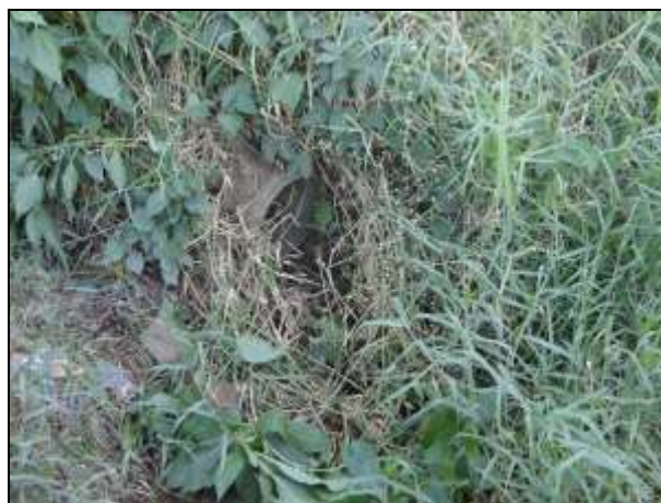
Figura 55 - Lançamento de águas pluviais próximo à Ponte 1
