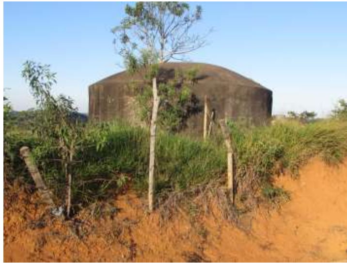
Figura 20 - Reservatório de água do Poço 02
