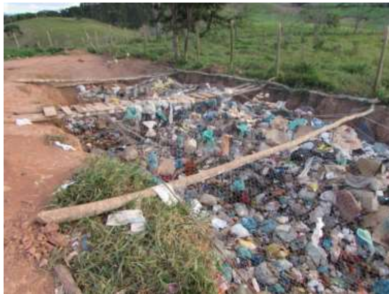
Figura 95 - Resíduos depositados na vala do aterro controlado. Nota-se que existe uma cobertura com tela para evitar o acesso de cães
