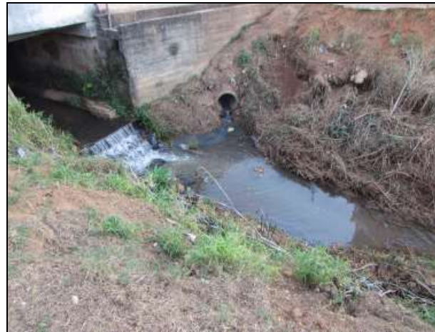
Figura 50 - Lançamento de drenagem e água de lava-rápido no córrego Lava-Pés no Parque de Exposições
