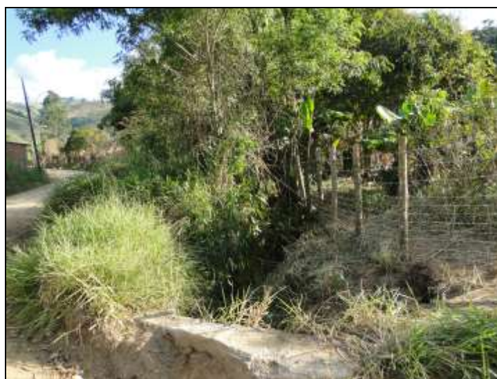
Figura 62 - Visão a jusante da Ponte 4, sobre o ribeirão das Lobas
