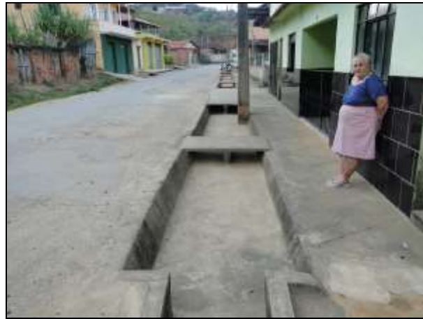
Figura 80 - Passarelas feitas por moradores de Palmital dos Carvalhos em via sem rede de drenagem
