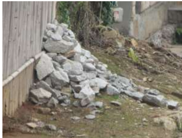
Figura 99 - Resíduos de Construção Civil depositados em local inadequado.
