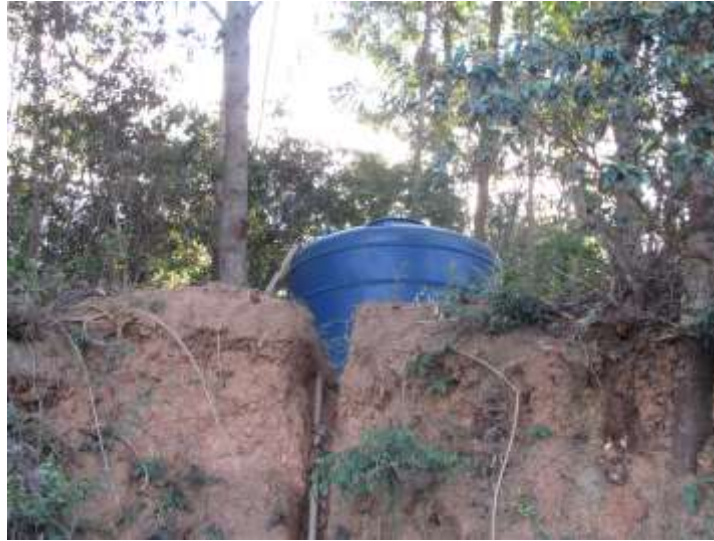
Figura 22 - Reservatórios de água do Poço 03
