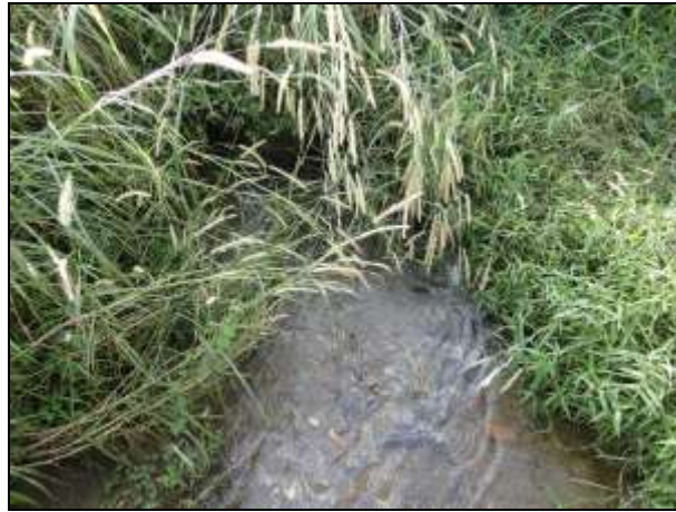
Figura 58 - Ribeirão das Lobas a montante da Ponte 3
