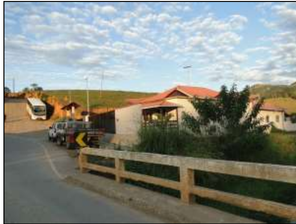
Figura 53 - Ponte 1, sobre o ribeirão das Lobas
