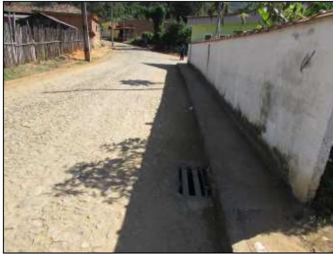
Figura 75 - Pavimentação com pedras na localidade de Japão
