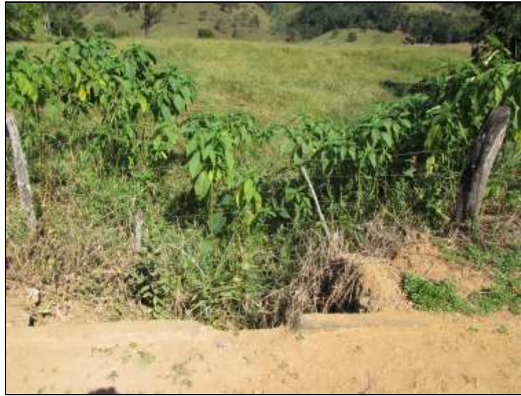
Figura 68 - Vista a jusante da Ponte 2, sobre afluente do córrego Japão
