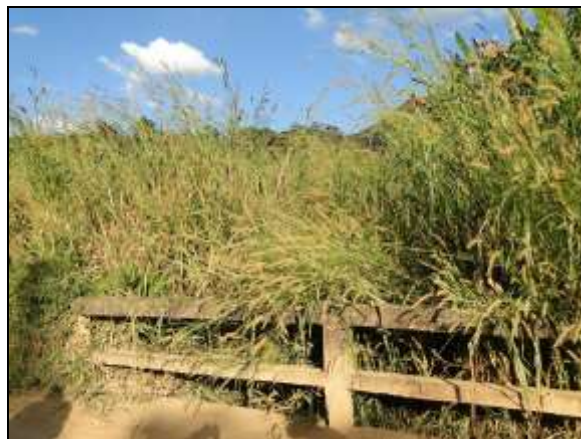
Figura 64 - Ponte 6, sobre o córrego Palmital
