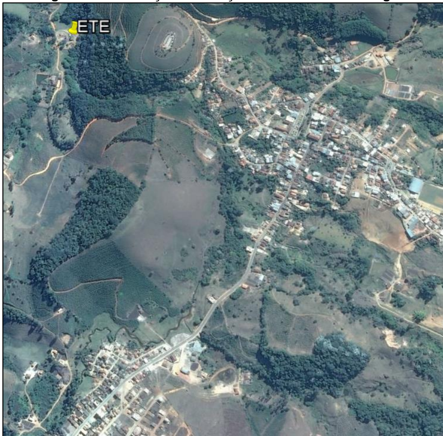
Figura 2 - Localização da Estação de Tratamento de Esgoto
