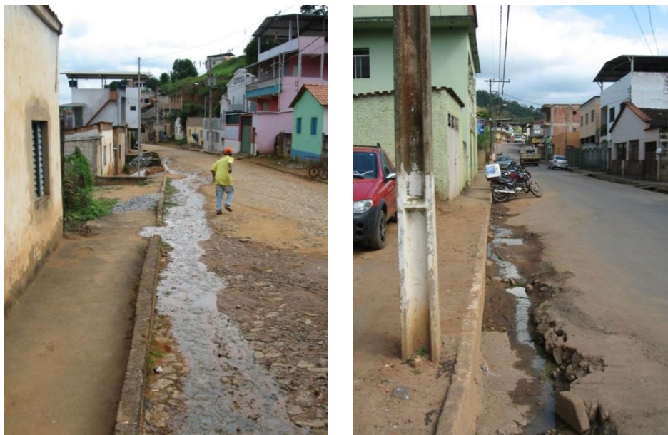
Figura 67 - Vias sem microdrenagem ou microdrenagem insuficiente
