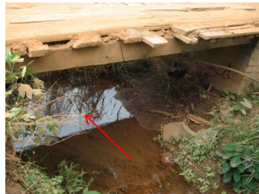
b- Vista da ponte e cabeceira
