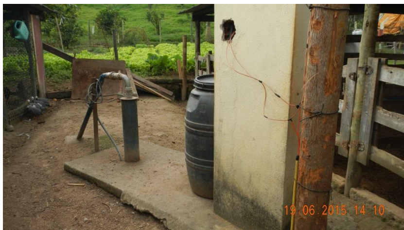
Figura 40 - Captação subterrânea de Fonseca
