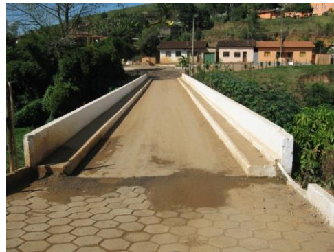
b- Detalhe da ponte
