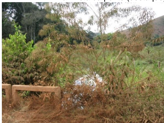
b- Vista da ponte e Córrego
