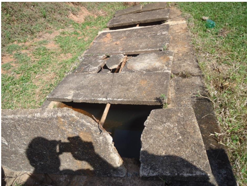
Figura 23 - Filtro de carvão e brita de Major Ezequiel
