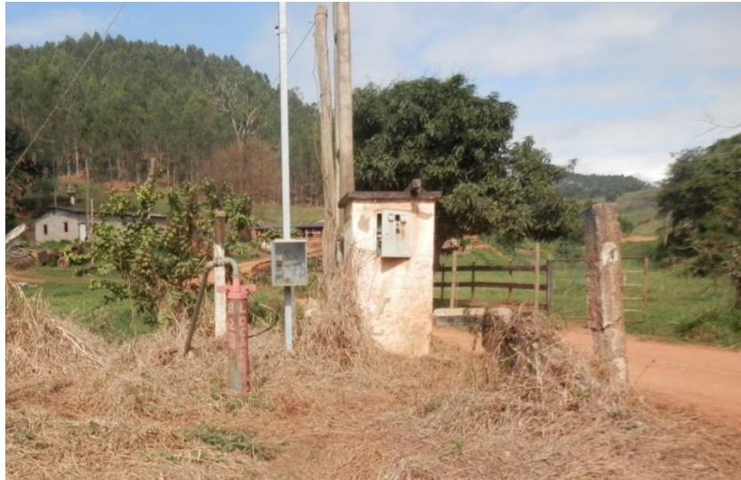
Figura 27 - Poço desativado de Barretos de Alvinópolis
