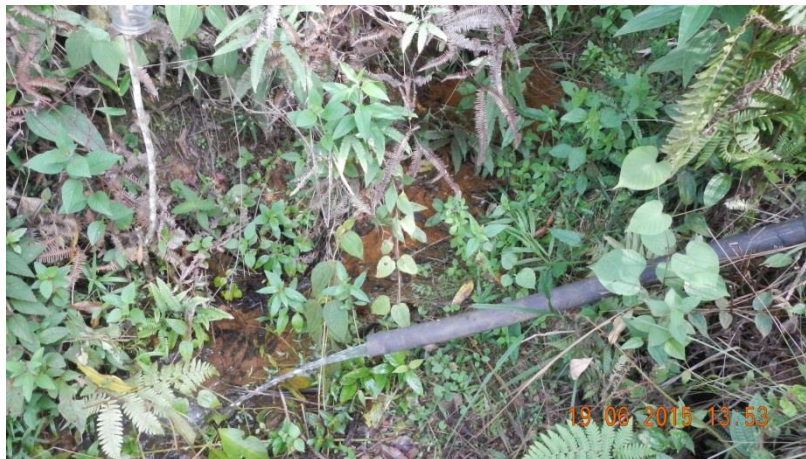
Figura 35 - Chegada da água aduzida da Captação 02 até o canal desviado
