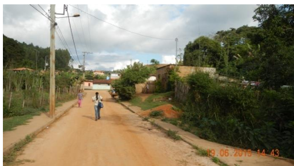
b- Via sem pavimentação
