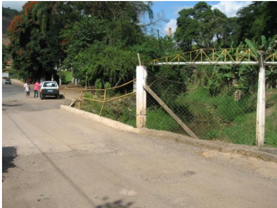
a- Vista da ponte
