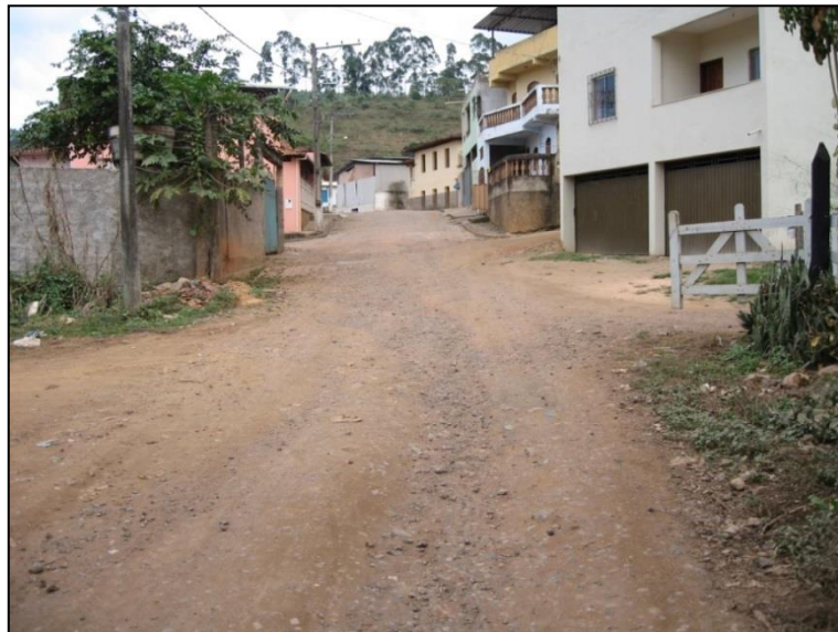
Figura 68 - Via sem pavimentação e ausência de microdrenagem
