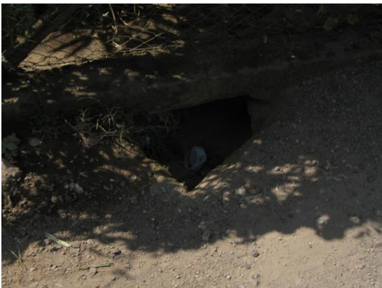
e- Detalhe da microdrenagem ao lado da ponte
