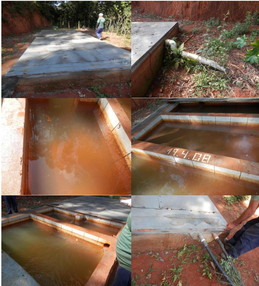
Figura 31 - Detalhes da caixa de areia
