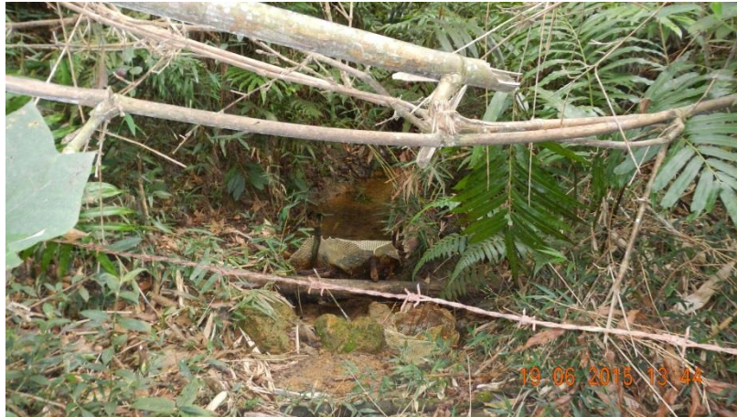
Figura 34 - Captação de água de Fonseca - córrego Togó (Captação 02)
