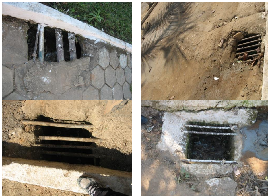
Figura 72 - Aspectos das bocas de lobo
