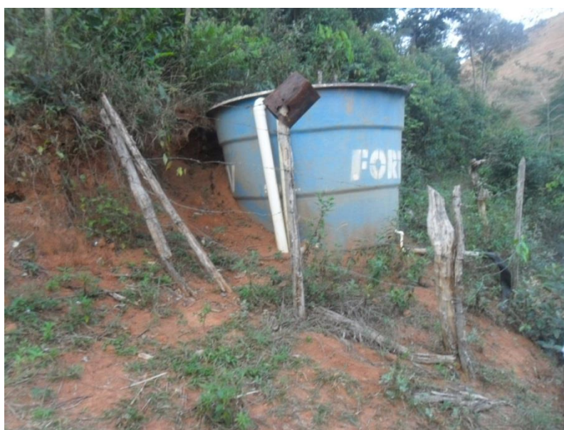
Figura 46 - Reservatório principal de água da captação superficial de Terras
