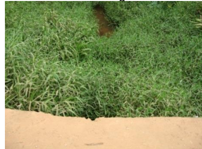
c- Visão do córrego a jusante
