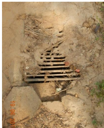
Figura 70 - Características das vias e infraestrutura de microdrenagem
