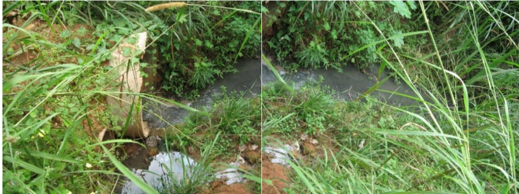
a- Final da tubulação
