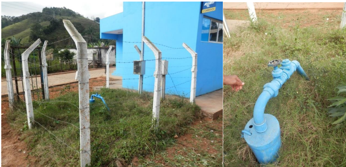
Figura 28 - Poço próximo à Unidade de Saúde de Barretos de Alvinópolis
