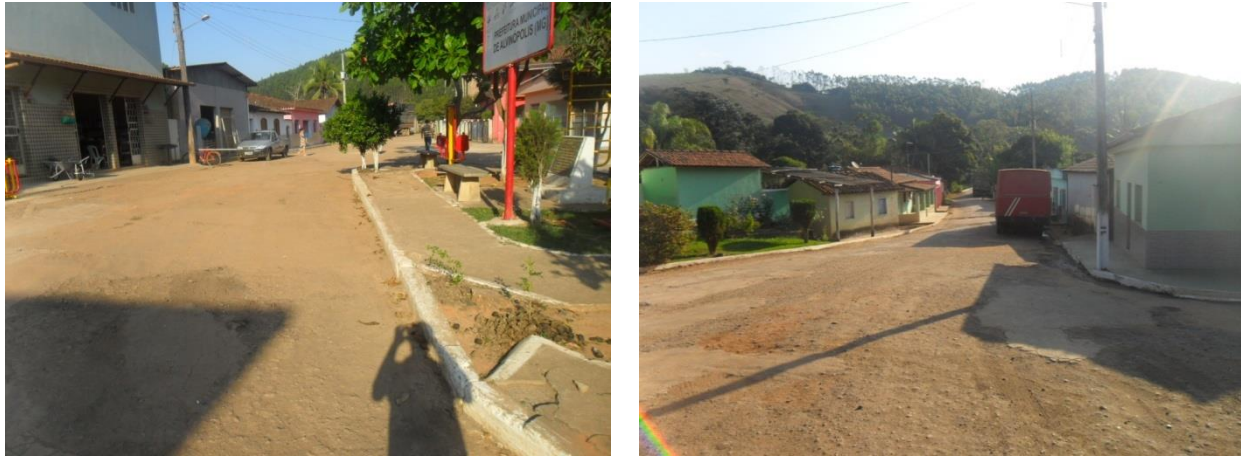
Figura 69 - Aspectos das vias pavimentadas recentemente e com microdrenagem
