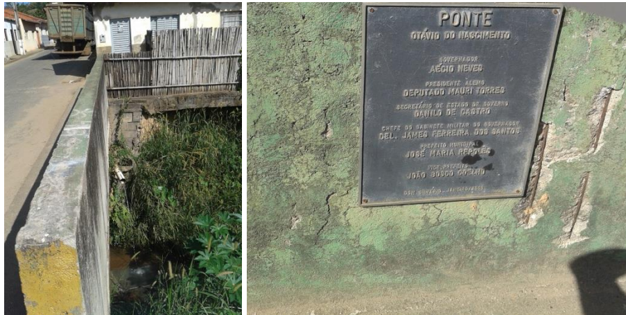
Figura 31 - Lançamento de esgotos 10
