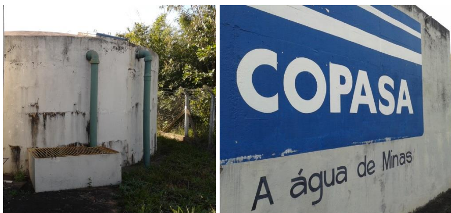
Figura 19 - reservatório de água tratada 02 e 03
