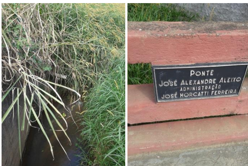
Figura 30 - Lançamento de esgotos 09
