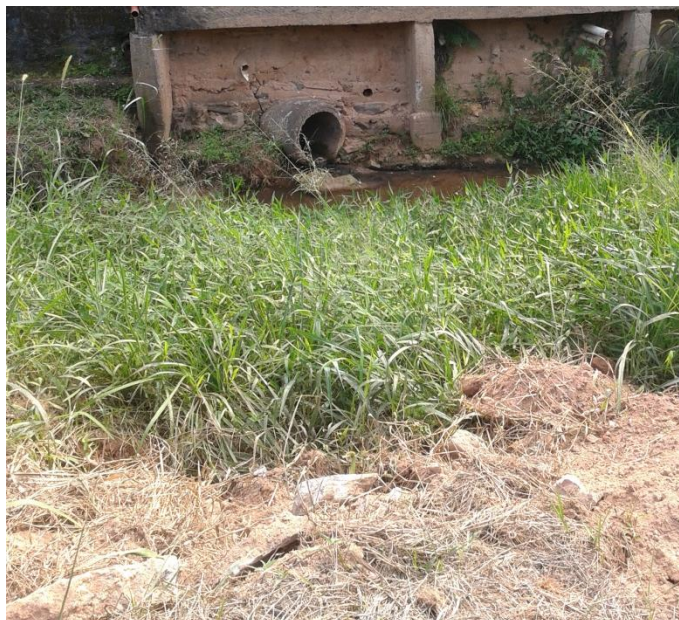
Figura 29 - Lançamento de esgotos 08
