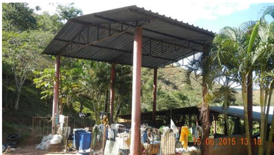
Figura 64 - Galpão de recepção dos resíduos sólidos
