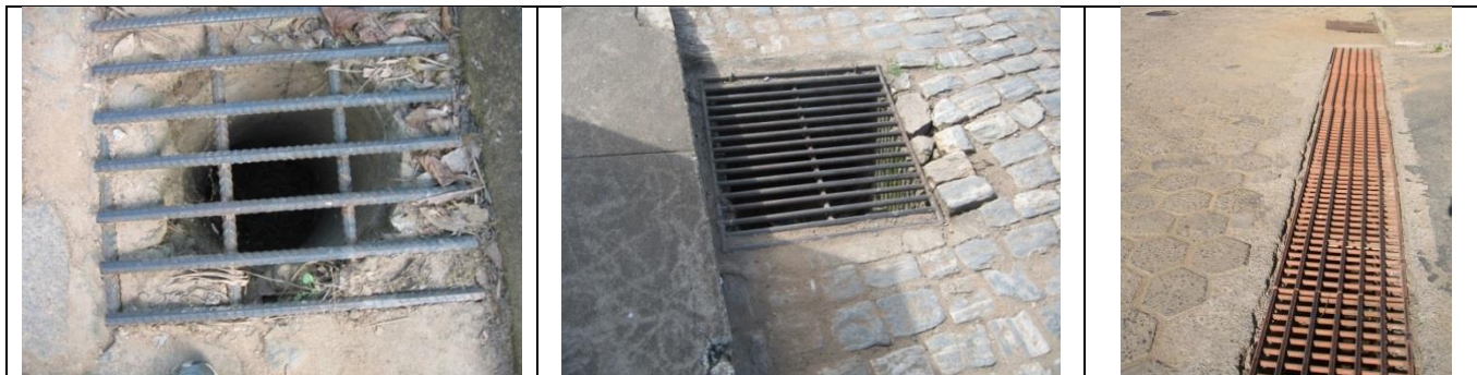
Figura 33 - Aspectos das bocas de lobo
