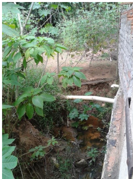
Figura 26 - Lançamento de esgotos 05
