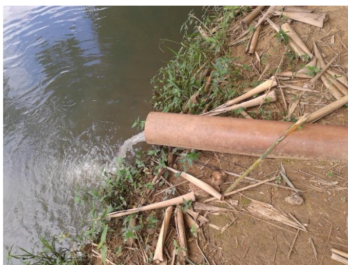
Figura 22 - Lançamento de esgotos 01
