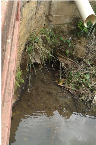
Figura 25 - Lançamento de esgotos 04
