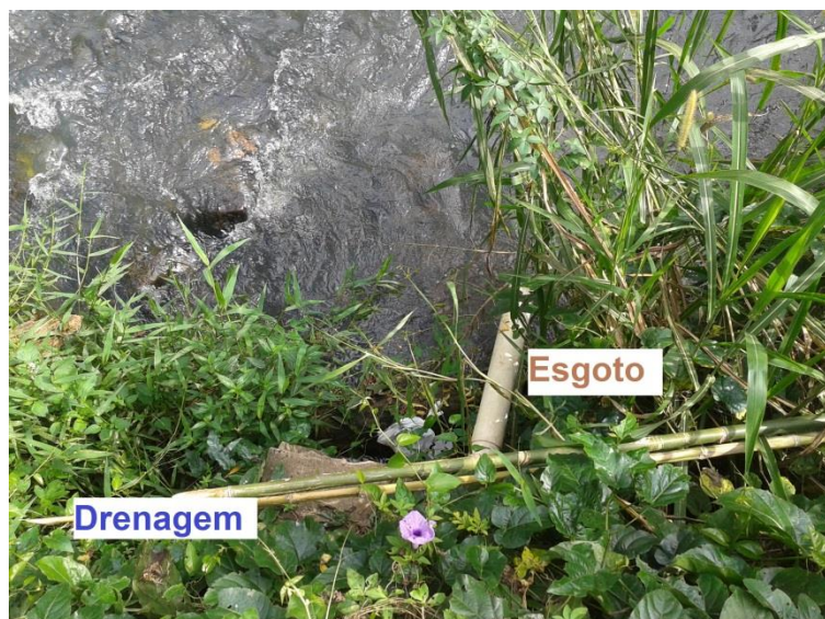
Figura 24 - Lançamento de esgotos 03
