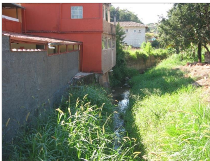
Figura 46 - Vista do córrego do Mingau e ocupações no seu entorno
